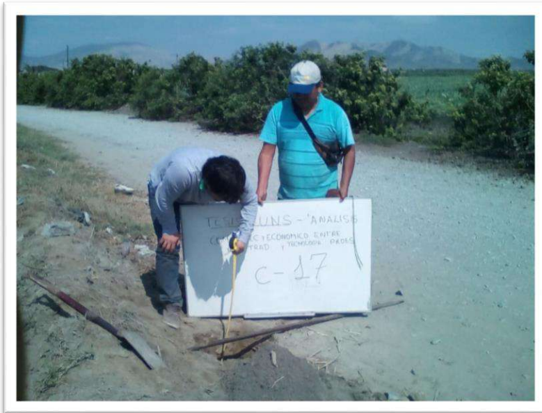
FOTO N° 15: Ubicación de la calicata C-17, presencia de relleno de 0.00 m a 0.15 m., con presencia de gravas y arena de 0.15 m. a 1.70m.
