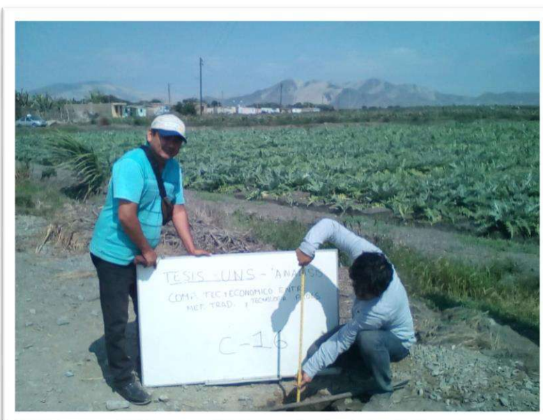
FOTO N° 14: Ubicación de la calicata C-16, presencia de arena y gravas de 0.85 m. a 1.60 m.
