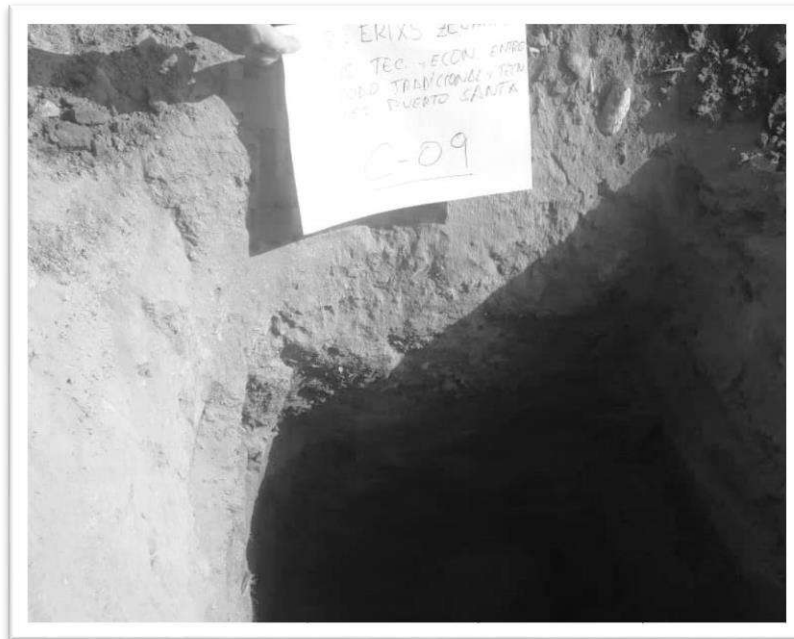
FOTO N° 07: Ubicación de la calicata C-09, toma realizada para la recolección de Muestra 02 y Muestra 03, generalmente con presencia de gravas y arena de 0.85 m. a 1.30 m., presencia de arcilla y limos de 1.30 m. a 1.65 m.
