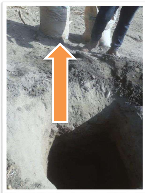
FOTO N° 18: Ubicación de la calicata C-09, extracción de muestra de para laboratorio.
