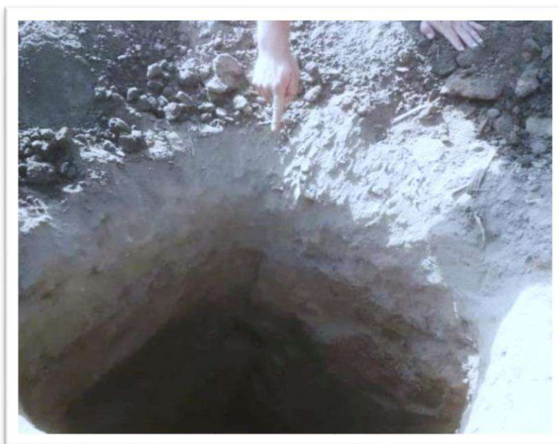
FOTO N° 11: Ubicación de la calicata C-13, presencia de arcilla y limos de 1.00 m. a 1.70 m.
