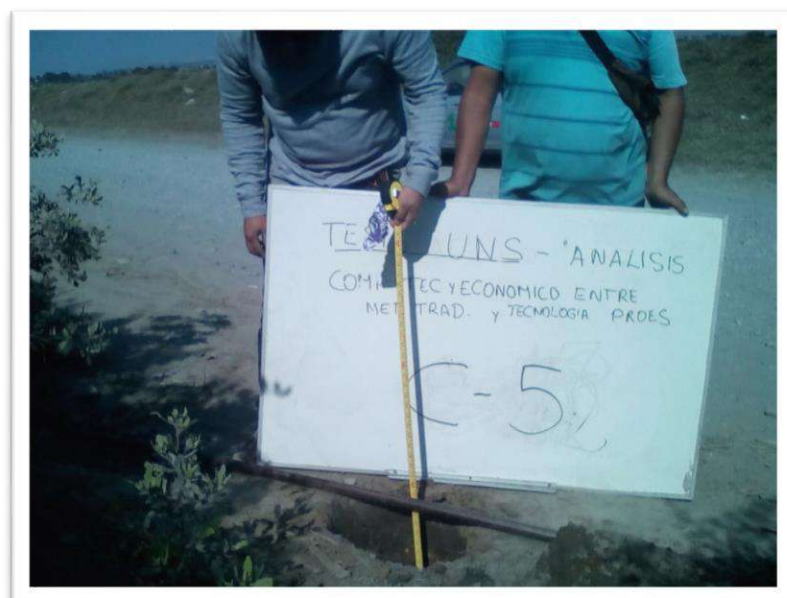
FOTO N° 04: Ubicación de la calicata C-05, El Suelo de 0.0 m a 0.50 m conformado generalmente por relleno, con presencia de gravas y arena de 0.50 m. a 1.00 m., presencia de arcilla y limos de 1.00 m. a 1.55 m.
