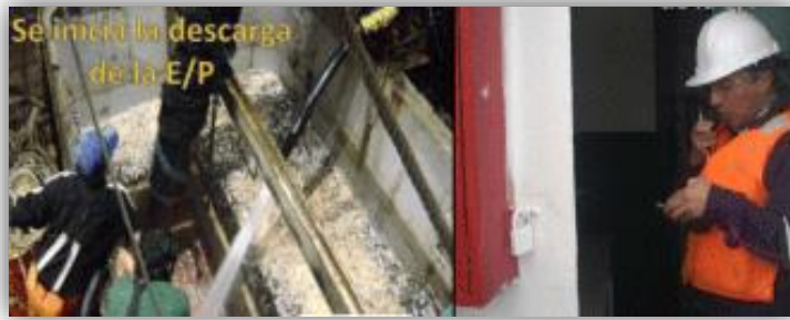
Fig.9. Inicio de descarga de Anchoveta en CHATA
