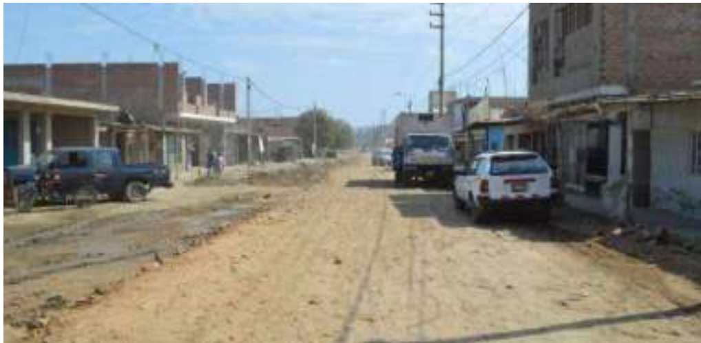
Figura 3: Vivienda afectada en el poblado La Cuadra (Cascajal), ubicado en la parte media de la cuenca Lacramarca.
