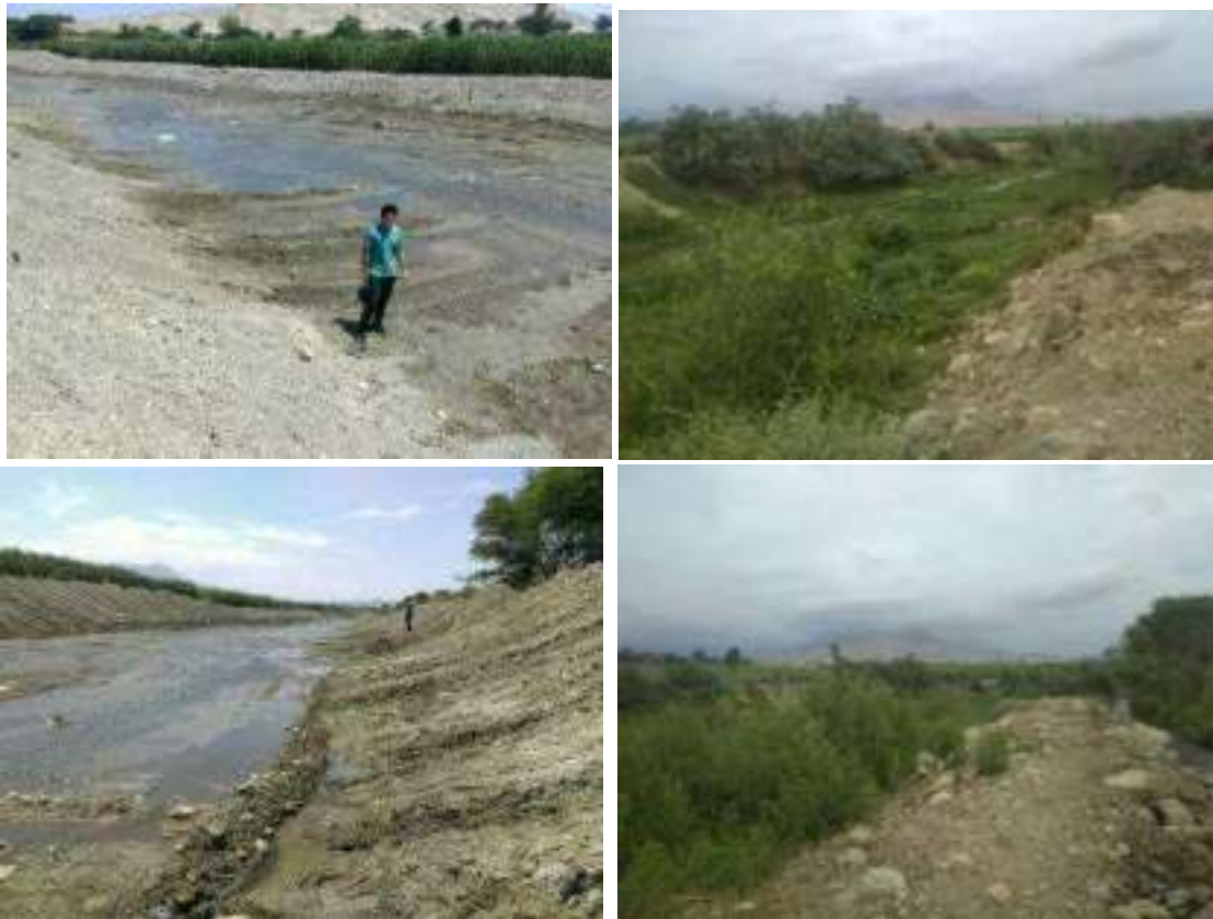
Figura 100, Figura 101, Figura 102 y Figura 103: En la última visita a campo realizada en enero del 2020, se pudo apreciar que el trabajo de descolmatación y encauzamiento (figuras de la izquierda) realizados en el 2018, casi había desaparecido, pudiéndose observar el lecho y márgenes llenos de vegetación, así como los márgenes erosionados por el caudal diario (figuras de la derecha).
