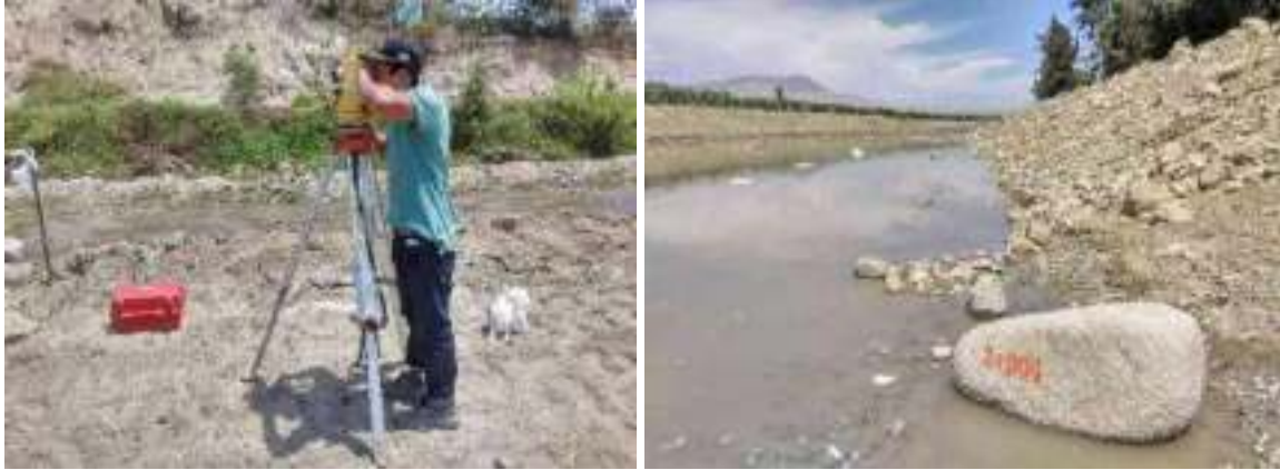
Figura 87 y Figura 88: El levantamiento topográfico finalizó al llegar a la progresiva 2+000 del tramo de estudio.
