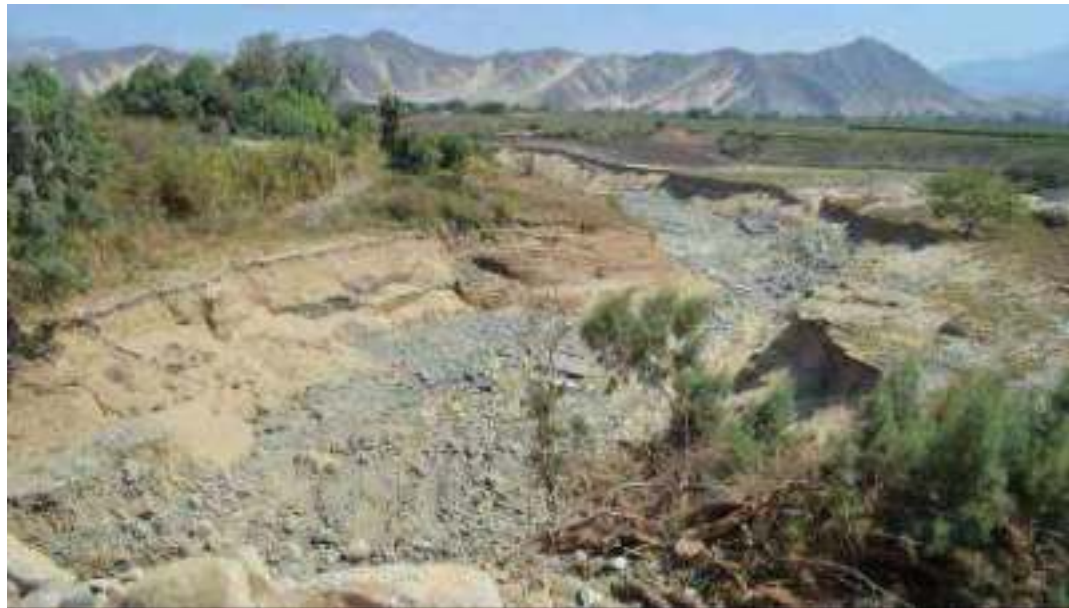
Figura 1: Socavamiento e incisión de un afluente del río Lacramarca, ocasionado por la ruptura del canal Chinecas.
