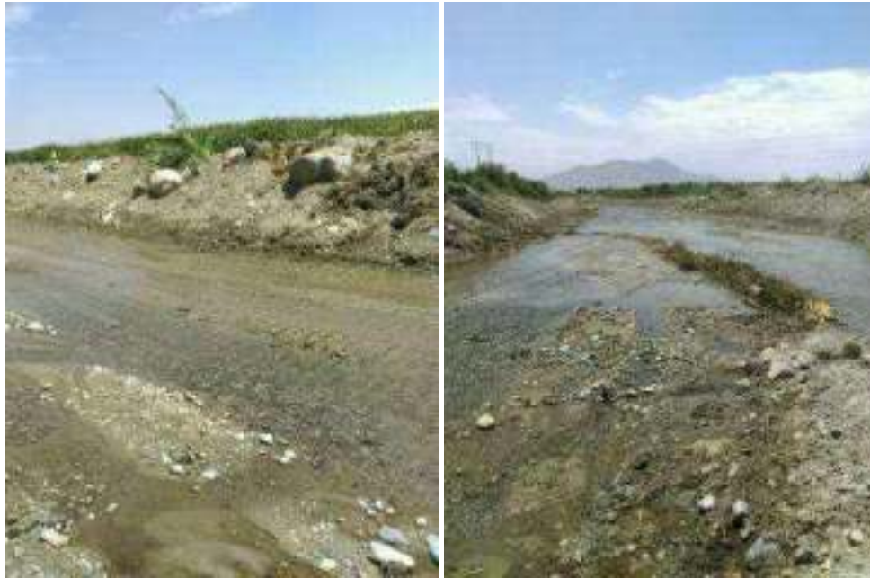
Figura 73 y Figura 74: Este trabajo de encauzamiento, posteriormente sería modelado para determinar su efectividad, Modelado 02.
