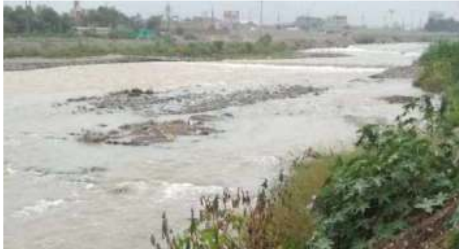
Figura 20: Modificación del pendiente tipo escalonada, del lecho del río Rímac dentro de la PTAP La Atarjea, Lima.
