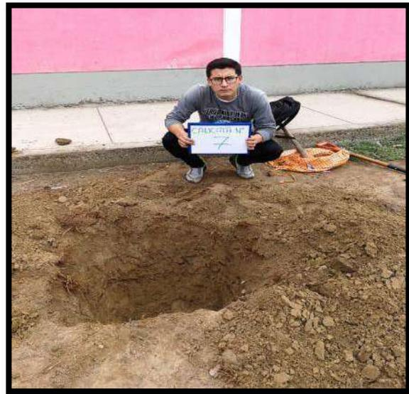
**FOTO N° 03 Y 04:** Se aprecia la excavación de la calicata C-3 y C-7, llegando a la profundidad deseada, para la extracción de la muestra.
