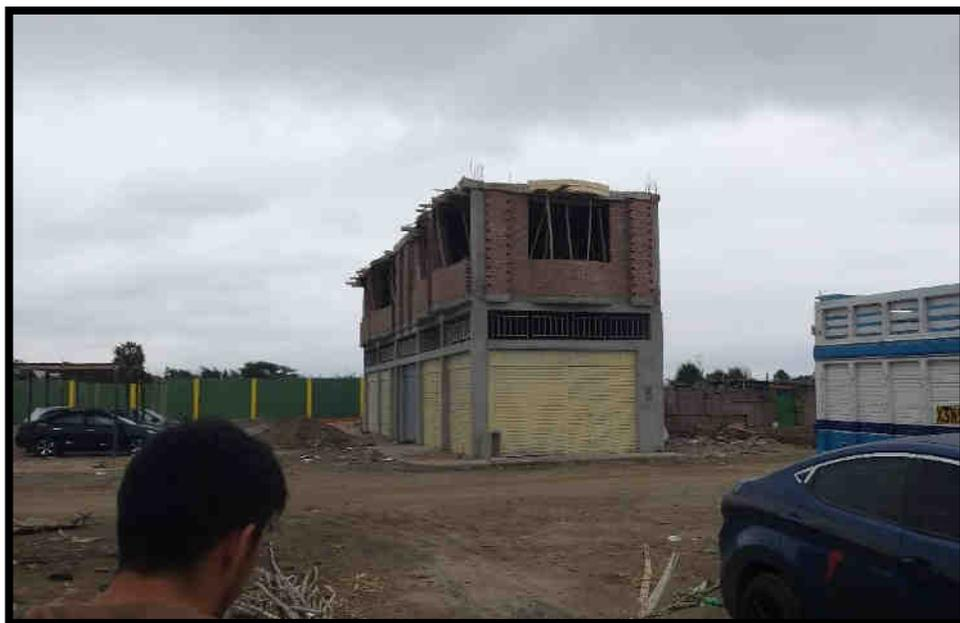
**FIGURA N° 27** Observamos en la imagen una construcción en el mercado La Perla de dos pisos con vigas peraltadas, los pies derechos en el segundo piso están cruzados.
