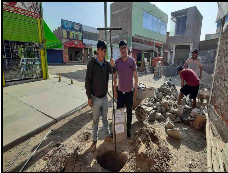
FIGURA N° 09: Excavación y toma de muestra del suelo de la calicata C-03 en el mercado la Perla de Chimbote
