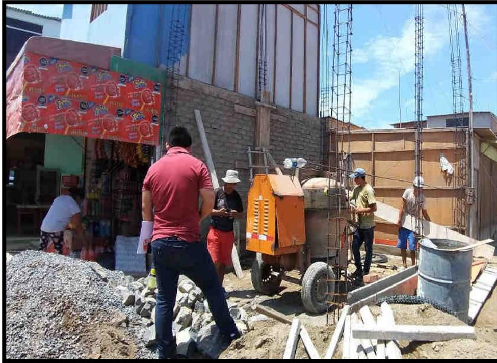
**FIGURA N° 36** Observamos en la imagen el comienzo de la construcción de un local en el mercado la perla y los materiales están todos combinados y la distribución de los estribos no son los adecuados.
