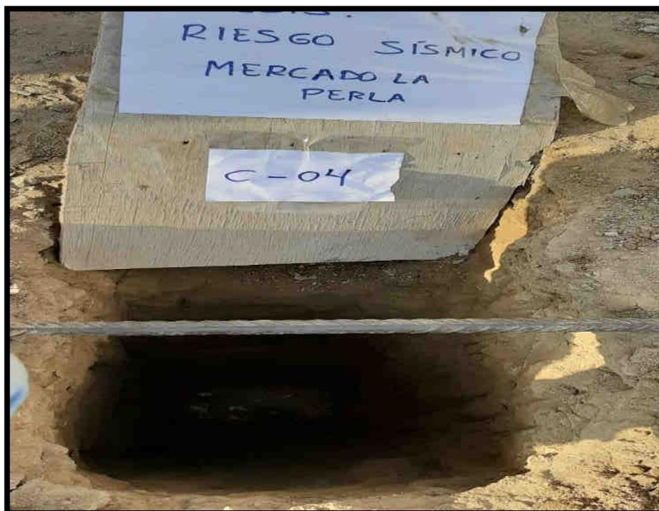
**FIGURA N° 14:** Excavación del suelo de la calicata C-04 en el mercado la Perla de Chimbote
