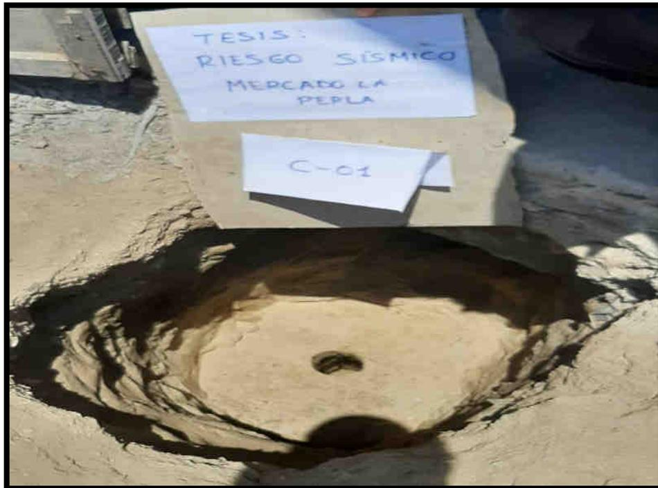
**FIGURA N° 03:** Excavación del suelo de la calicata C-01 en el mercado la Perla de Chimbote
