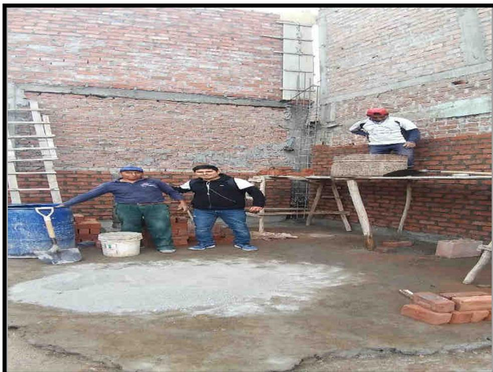
**FIGURA N° 29** Observamos en la imagen las construcciones del mercado La Perla, donde se colocó las zapatas a 1 metro de profundidad, ya que se encuentra el nivel freático a 1.40 m.
