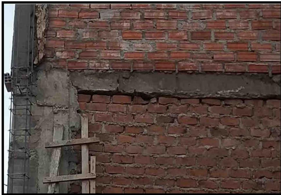
**FIGURA N° 30** Observamos en la imagen las construcciones del mercado La Perla, donde se observa que los ladrillos están colocados sin mezcla debajo de la viga.
