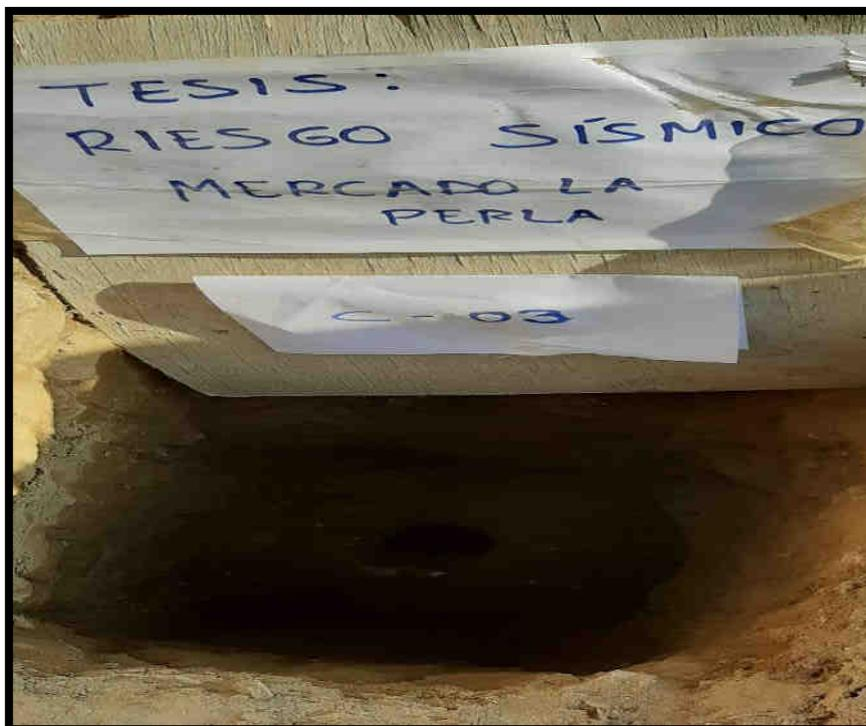
FIGURA N° 10: Excavación del suelo de la calicata C-03 en el mercado la Perla de Chimbote
