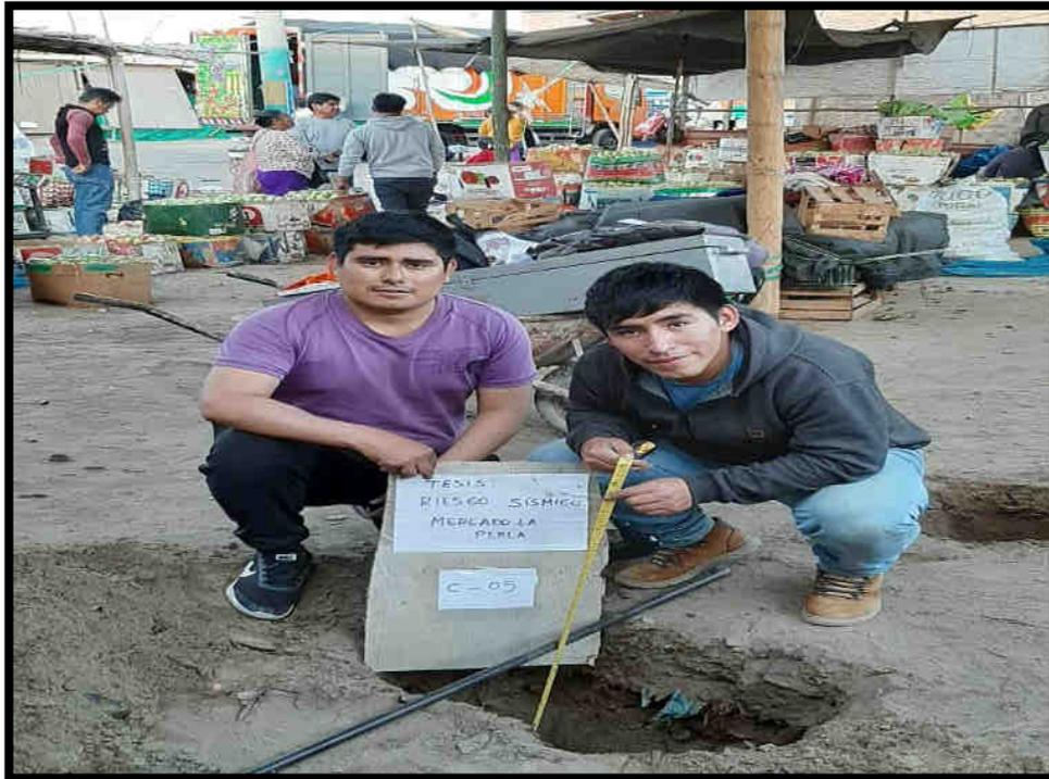
FIGURA N° 17: Excavación y toma de muestra del suelo de la calicata C-04 en el mercado la Perla de Chimbote
