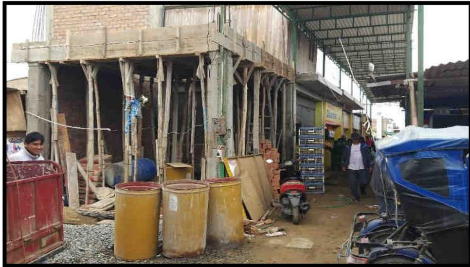
**FIGURA N° 26** Observamos en la imagen una construcción en el mercado La Perla, que los pies derechos están unido a la mitad y eso puede provocar el colapso del techo.
