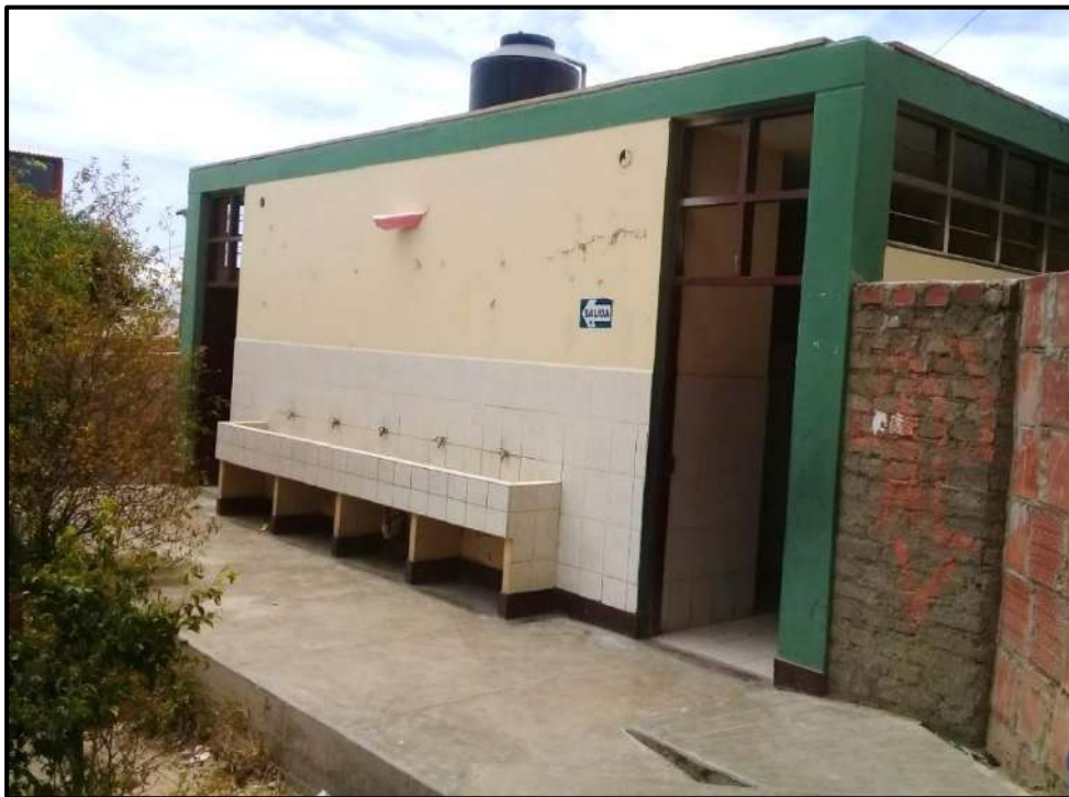
Fotografía N°14: Se aprecia los SS.HH. para hombres y mujeres, ubicado a la izquierda del Pabellón “D”.
