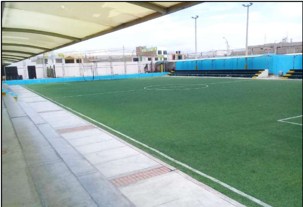
Fotografía N°26: Se observa un campo deportivo con gras sintético cercado de malla metálica dentro del colegio.
