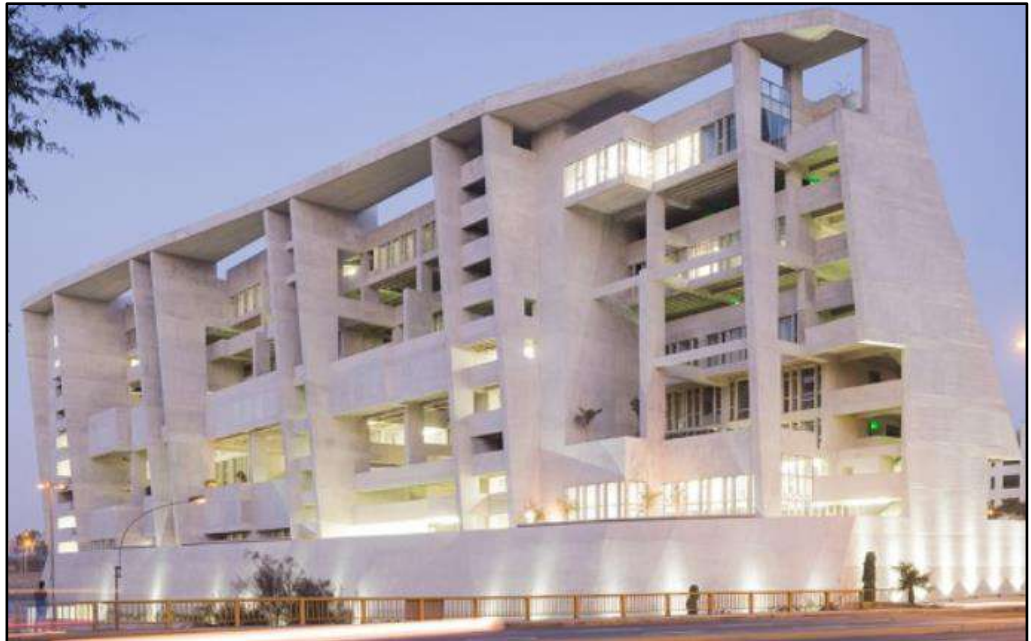
Figura 40: Nuevo campus del UTEC compuesta por 145 aisladores sísmicos LRB y 4 deslizadores sísmicos
