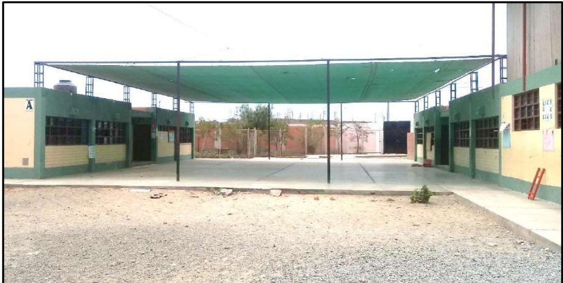
Fotografía N°08: Se aprecia un pequeño patio entre los pabellones “A” y “B”, el cual cuenta con una estructura metálica con una malla de color verde.
