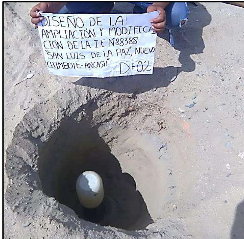
Fotografía N°07 y 08: Se aprecia insitu el ensayo de Densidad de Campo en las calicatas realizadas.
