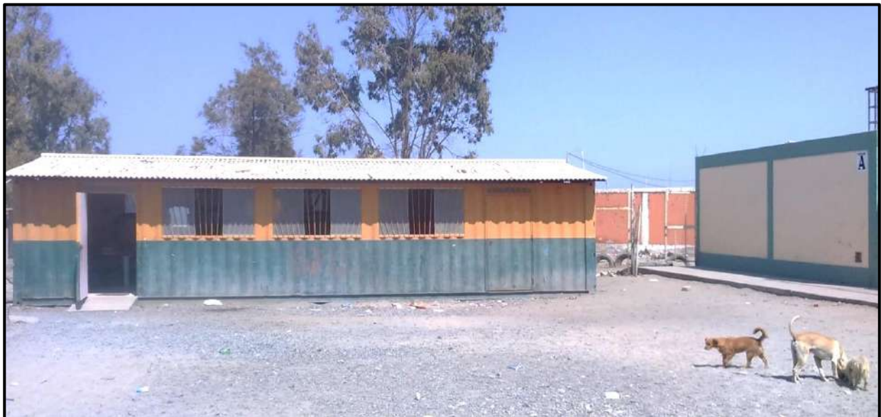
Fotografía N°04: Se aprecia este ambiente de metal utilizado para enseñar arte, ubicado a la izquierda del Pabellón “A”.
