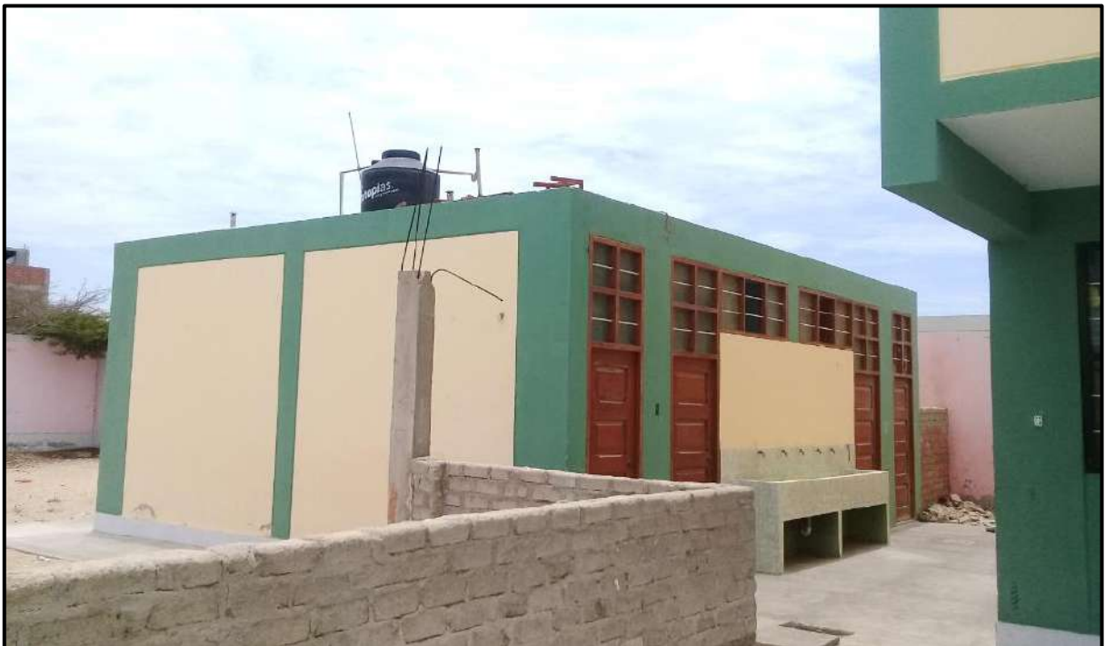
Fotografía N°24: Se aprecia los SS.HH. para hombres y mujeres, ubicado a la izquierda del Pabellón “F”.
