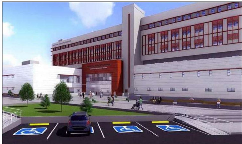
Figura 37: Hospital Hipólito Unanue de Tacna con 135 aisladores sísmicos Fuente: Recuperado de http://infraestructuraperuana.blogspot.com/2018/03/nuevo-hospital-hipolito-unanue-de-tacna.html
