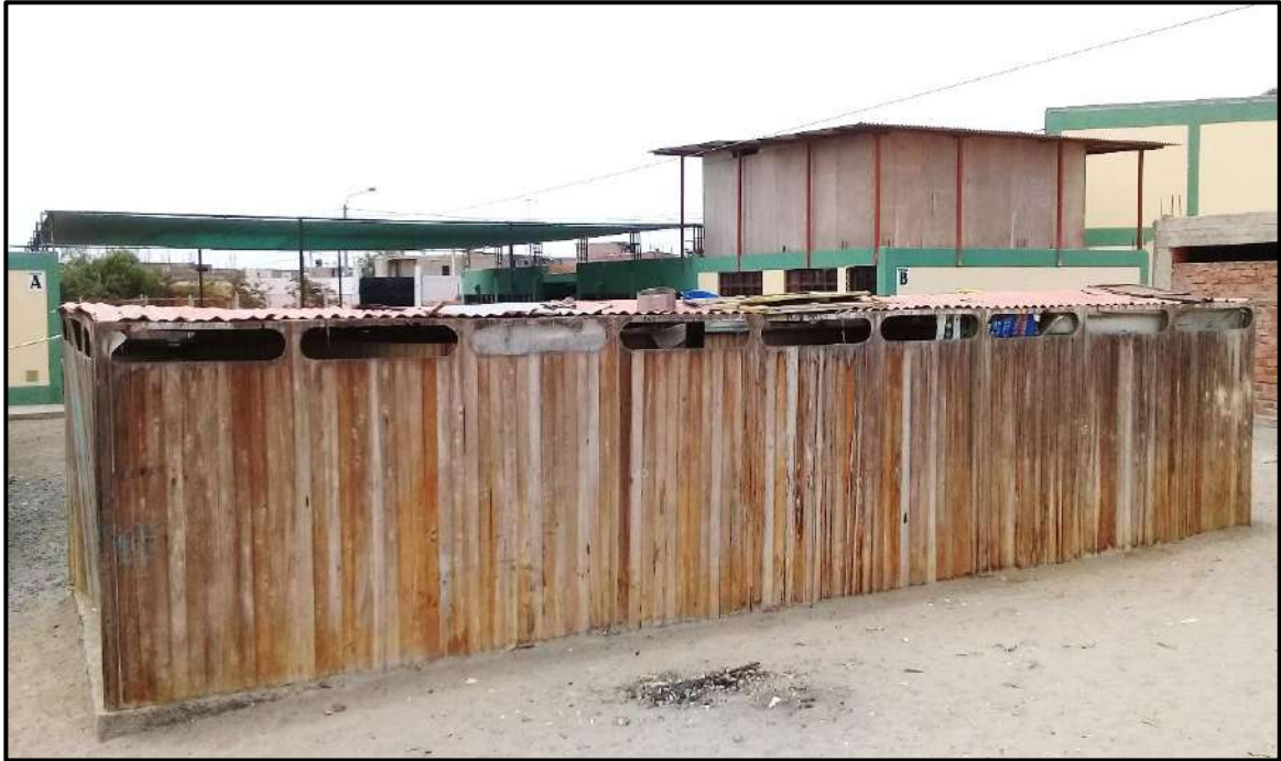
Fotografía N°05: Al costado de la estructura de metal se encuentra este ambiente de madera utilizado como depósito de diversos materiales.
