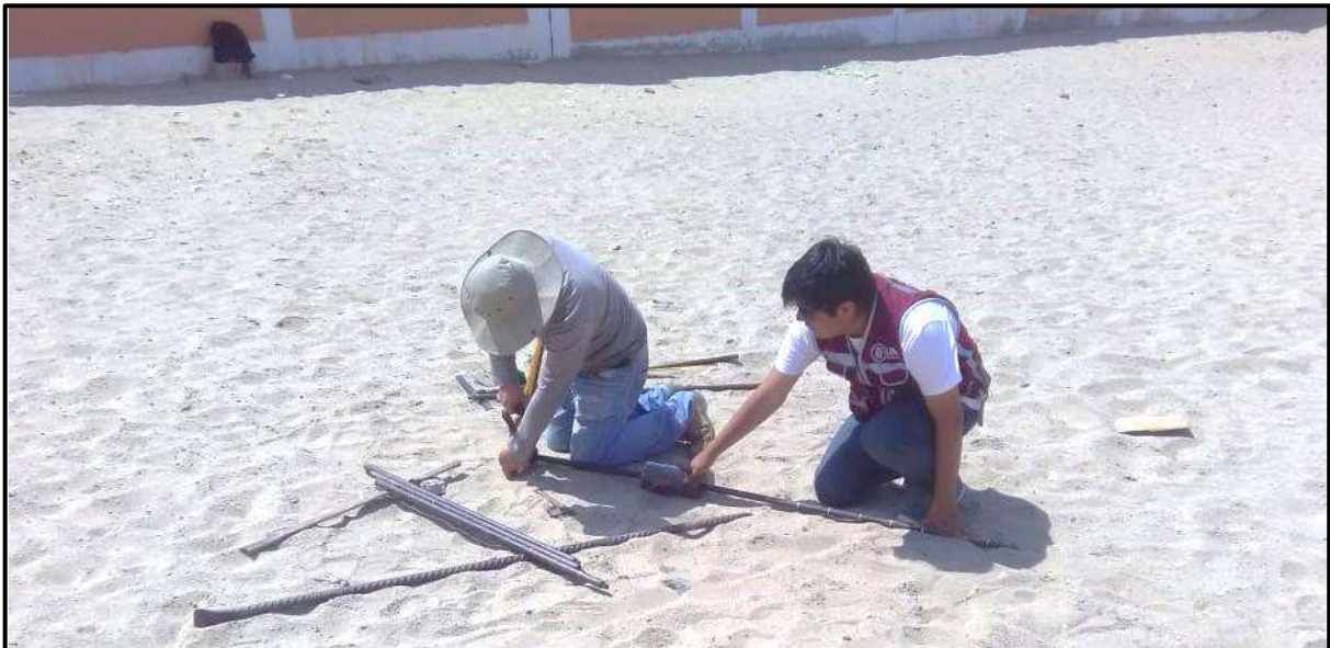
Fotografía N°11 y 12: Se observa la preparación del equipo de Ensayo de Penetración Dinámica Ligera “DPL”.
