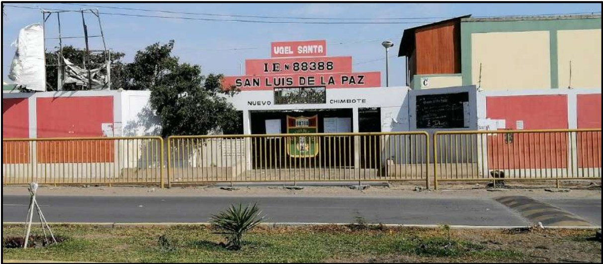
Fotografía N°01: Se aprecia la puerta principal de la I.E. N° 88388 “San Luis de la Paz”, Nuevo Chimbote - Ancash”
