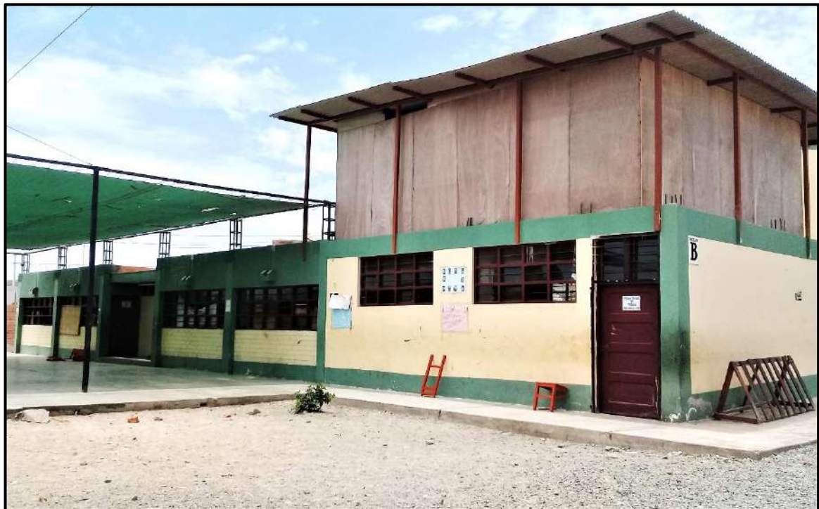
Fotografía N°06: Se aprecia la vista panorámica del Pabellón “B” de 1 nivel.
