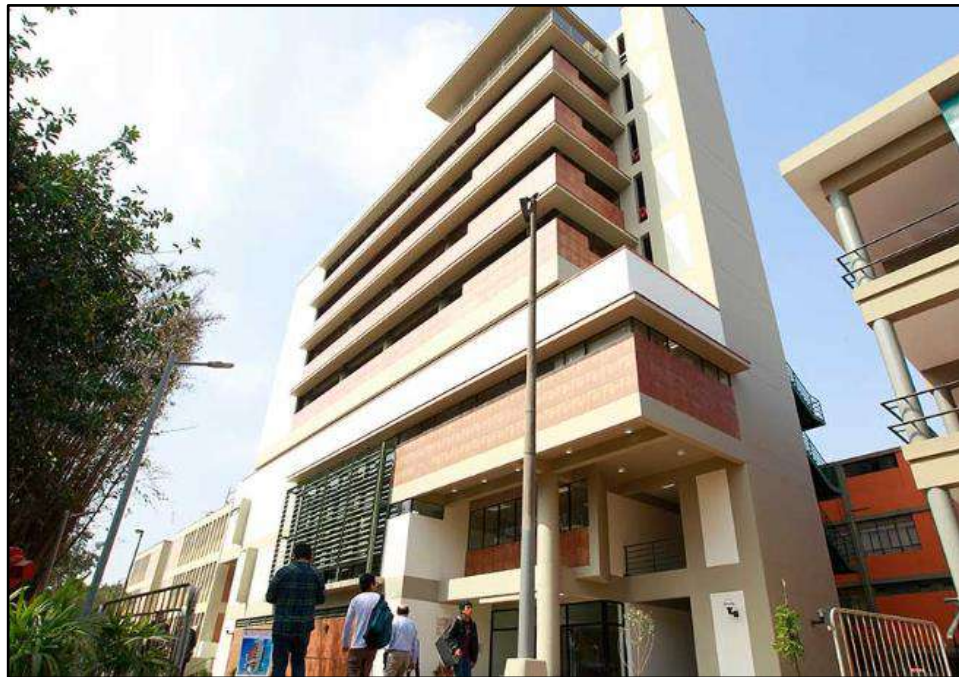
Figura 35: Centro de Información de la Facultad de Ingeniería Civil de la Universidad Nacional de Ingeniería con 20 aisladores sísmicos Fuente: Recuperado de https://andina.pe/agencia/noticia-uni-tiene-primer-edificio-antisismico-capaz-reducir-efectos-temblores-724958.aspx
