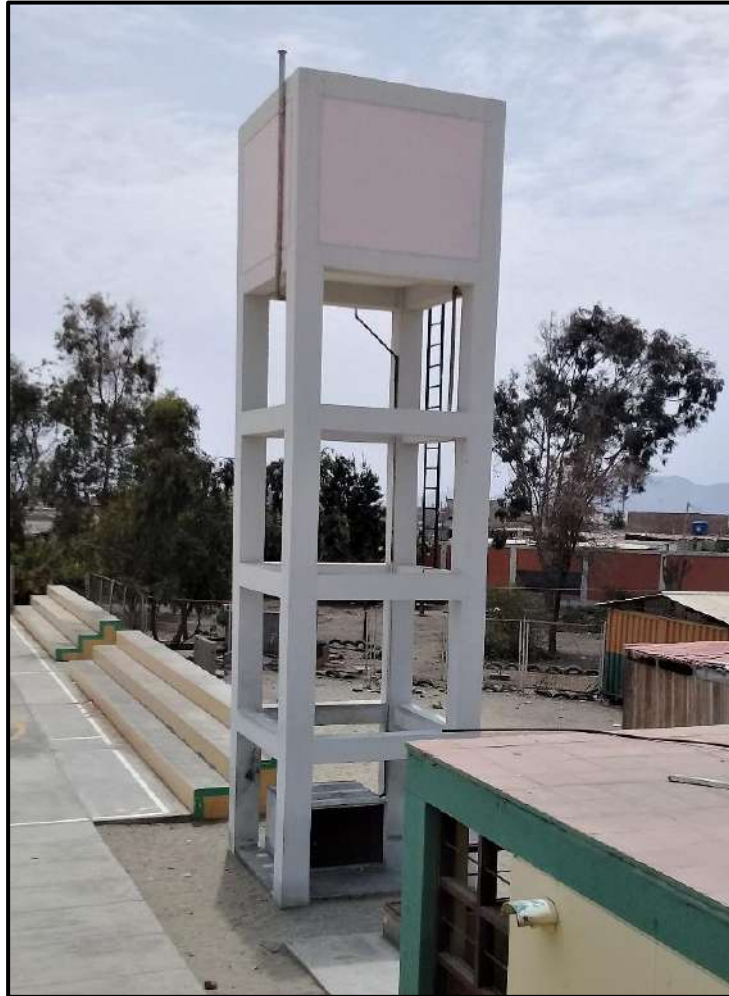
Fotografía N°19: Se observa el tanque elevado de 16m de altura que cuenta el colegio, ubicado a espaldas del Pabellón “E”.
