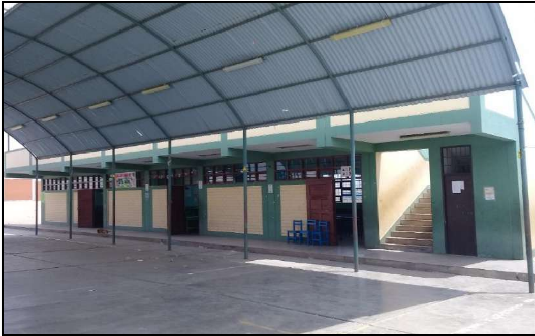
Fotografía N°15: Se observa el Pabellón “E” y una estructura metálica.
