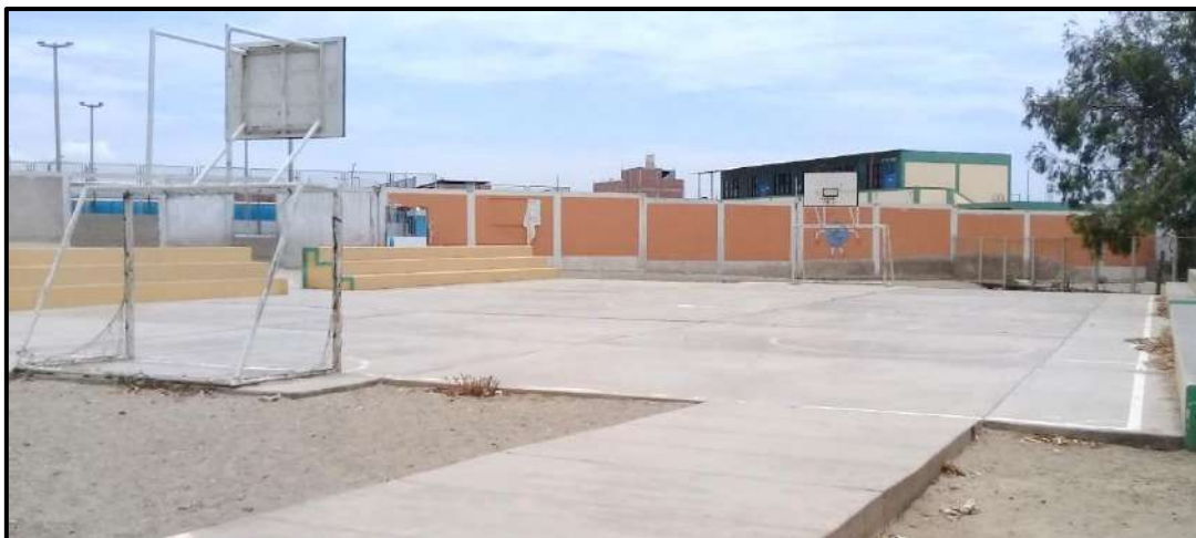
Fotografía N°20: Se aprecia la losa deportiva para practicar futbol, básquet y vóley dentro del colegio, ubicado a espaldas del Pabellón “E”.
