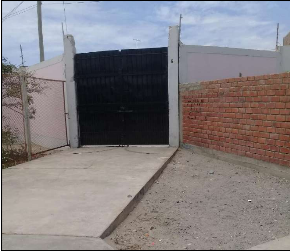
Fotografía N°09: Se aprecia la puerta de Ingreso Secundario al colegio.
