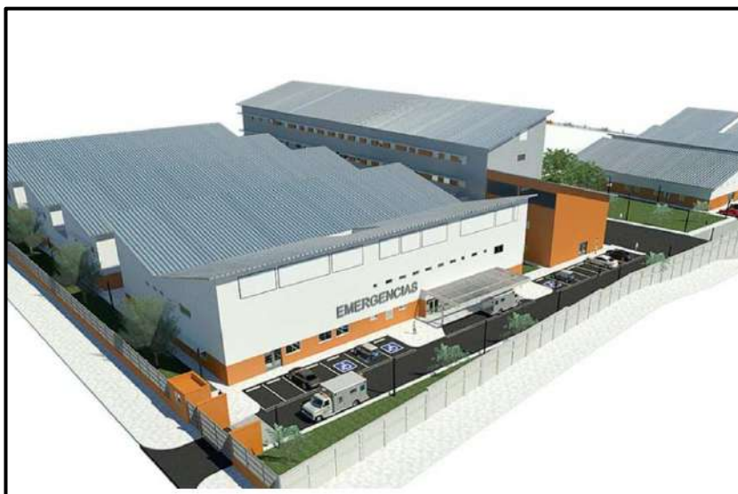
Figura 39: Hospital Santa Gema de Yurimaguas con 28 aisladores sísmicos
