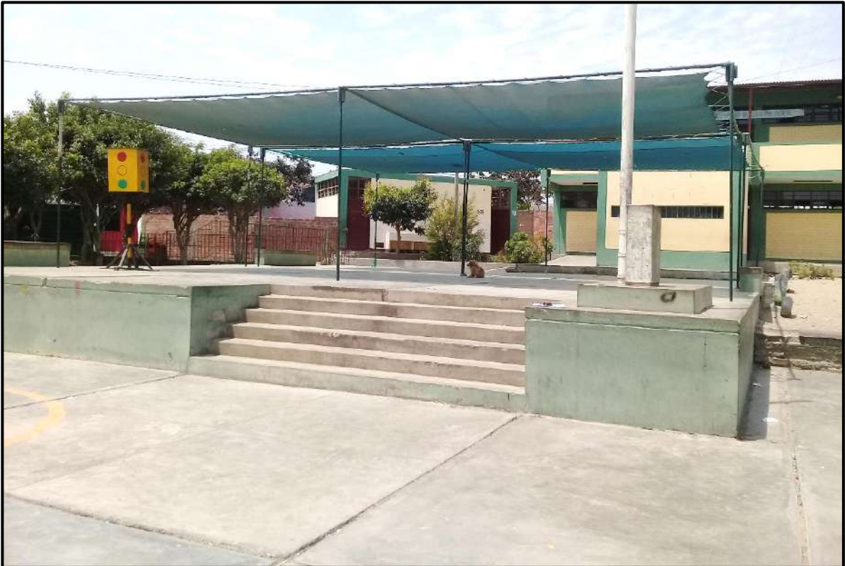
Fotografía N°13: Se observa un patio para recreo al frente del Pabellón “D”.
