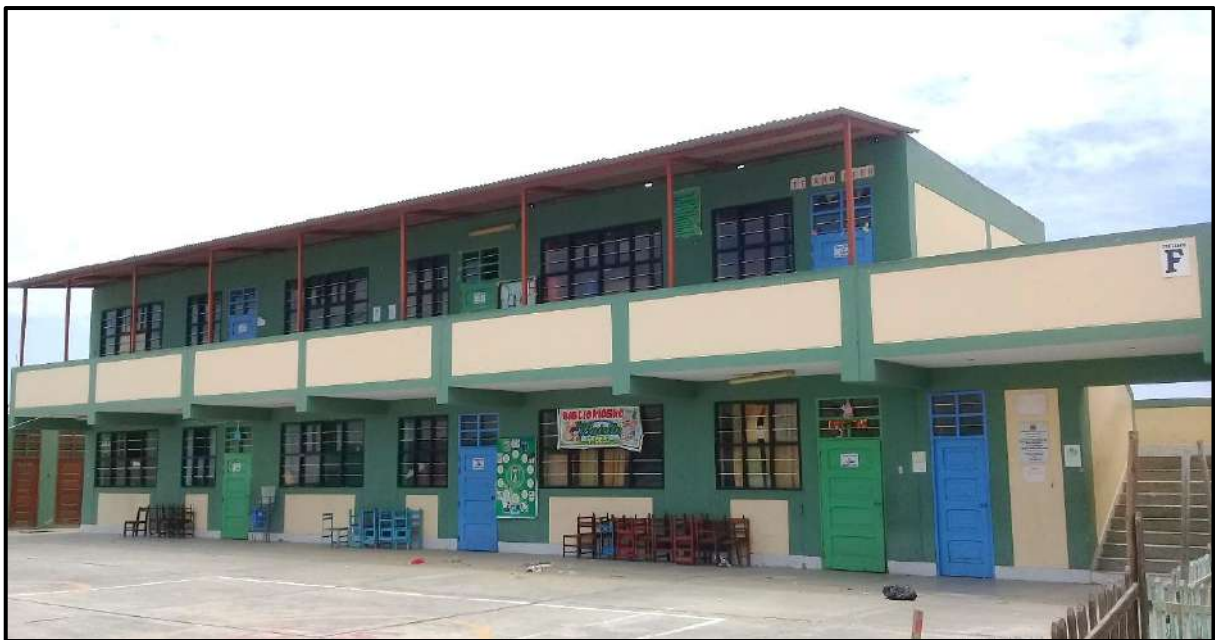
Fotografía N°22: Se aprecia la vista panorámica del Pabellón “F” de 2 niveles.
