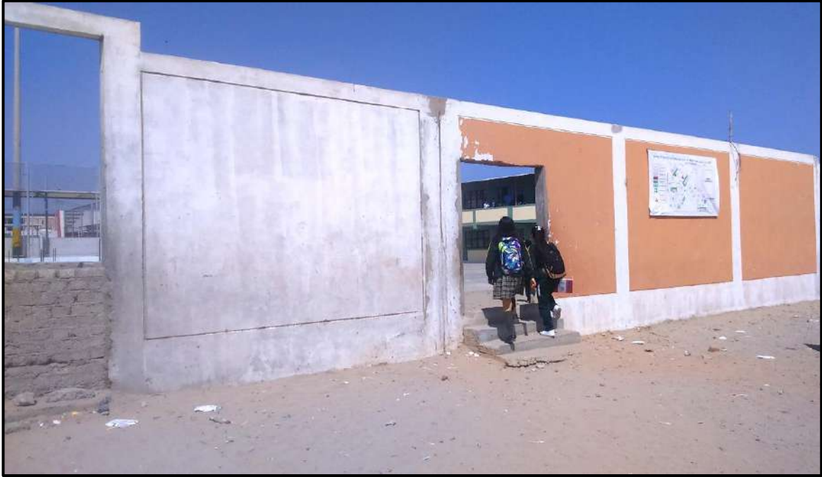
Fotografía N°21: Se aprecia el cerco perimétrico que divide el colegio y que sirve de acceso al Pabellón “F” y complejo deportivo.
