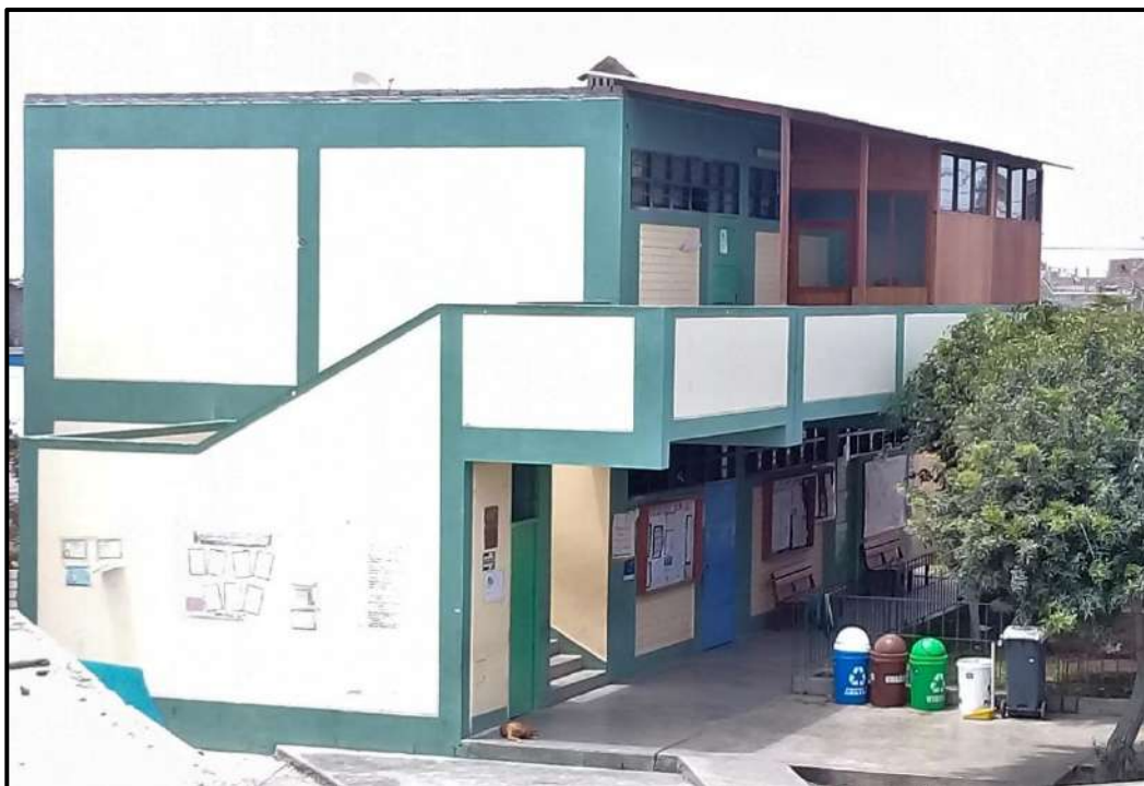
Fotografía N°10: Se aprecia la vista panorámica del Pabellón “C” de 2 niveles.
