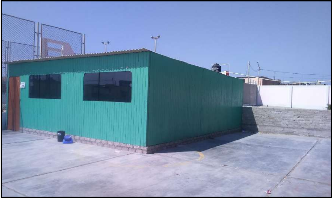
Fotografía N°23: Se observa esta construcción de madera que es usado para dictar clases, ubicado al frente del Pabellón “F”.
