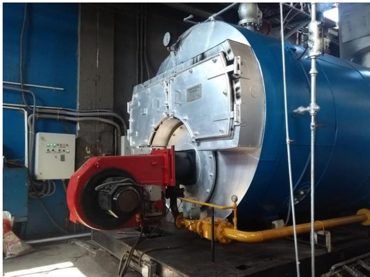
Figura N°15 Caldera de 500 BHP Marca Distral
