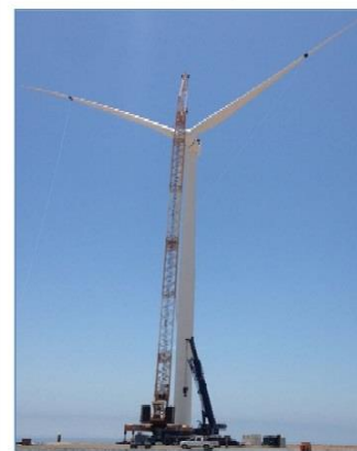
Montaje de Palas
