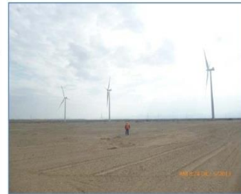
Vista de los aerogeneradores montados
