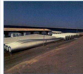
Palas y tramos de torre en la zona de obra
