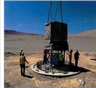
Unidades de Potencia en la zona de obra
