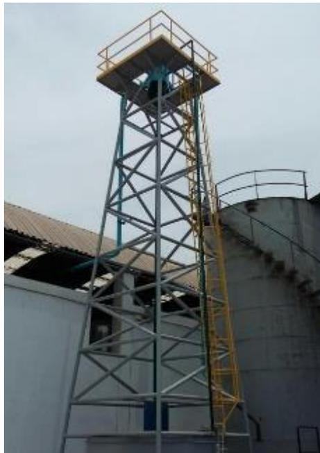
Figura 18: Torre barométrica
