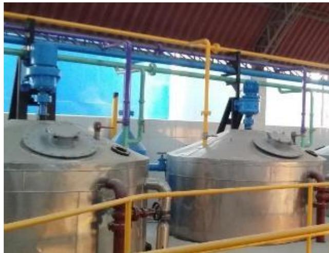
Figura 16: Reactor de almacenamiento de ácido sulfúrico
