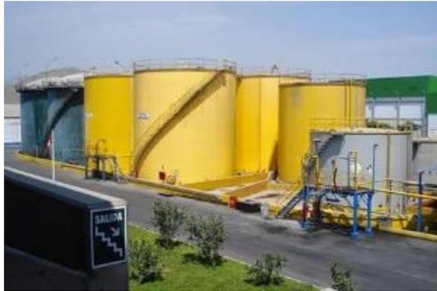
Figura 13: Tanque de almacenamiento de aceite y derivados -etil ester residual
