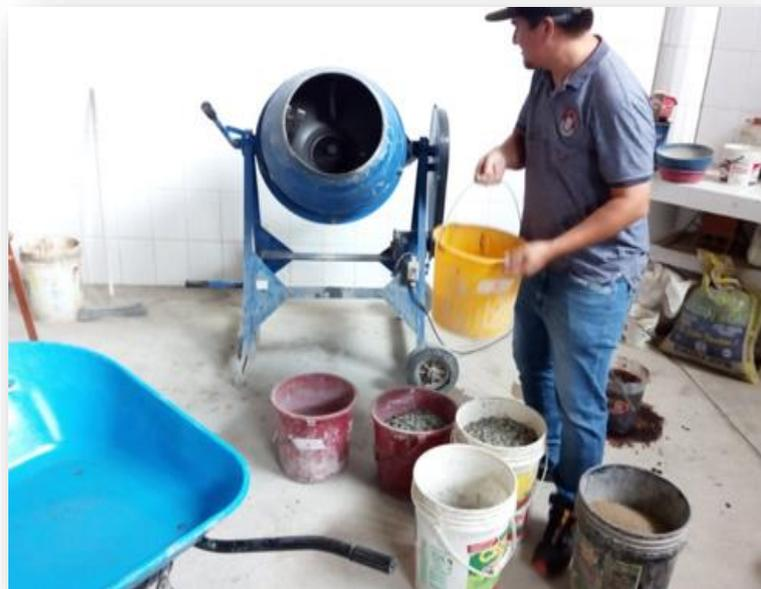
**Figura 8 .Preparación Del Concreto**
