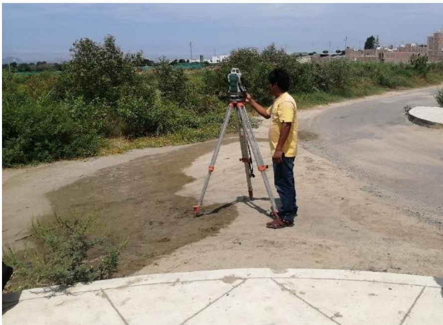
Foto 02.- Levantamiento Topográfico con estación Total desde el buzón 01.
