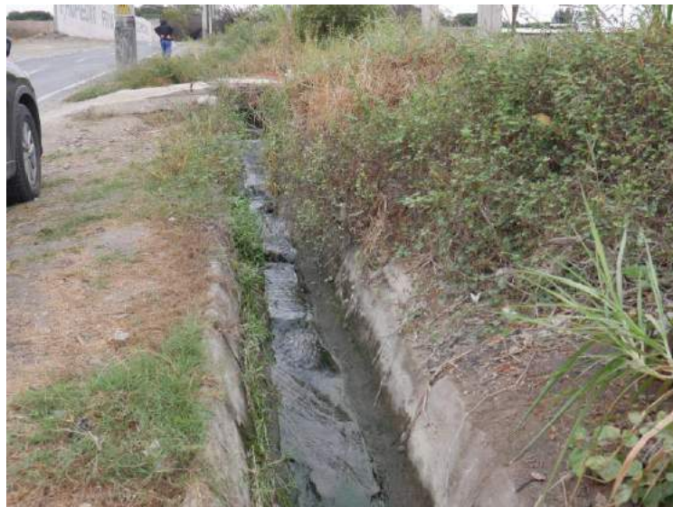
Figura 25: Canal Cuartelero D donde descargara el Sistema de Drenaje
