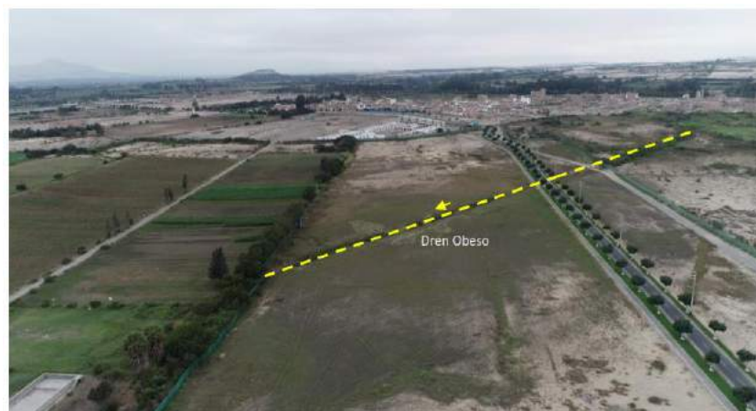
Figura 28: Sistema de Drenaje Obeso
