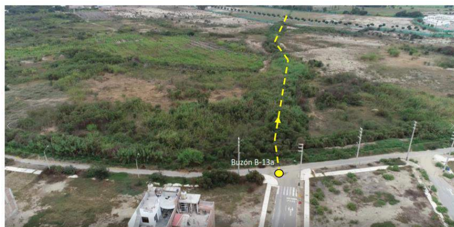
Figura 27: Inicio Sistema de Drenaje Obeso
