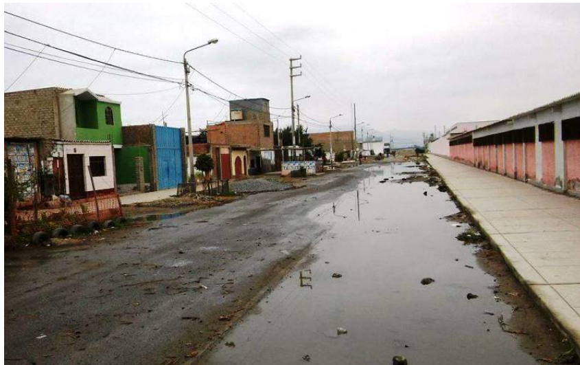
Figura 1: Problemas de Drenaje en el PJ. Villa María
