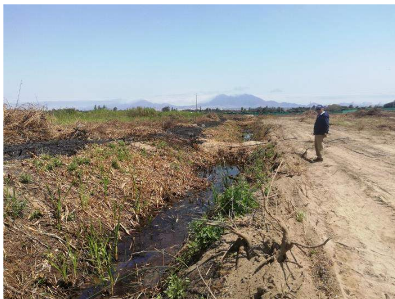
Foto 06.- Dren a Zanja Abierta existente
