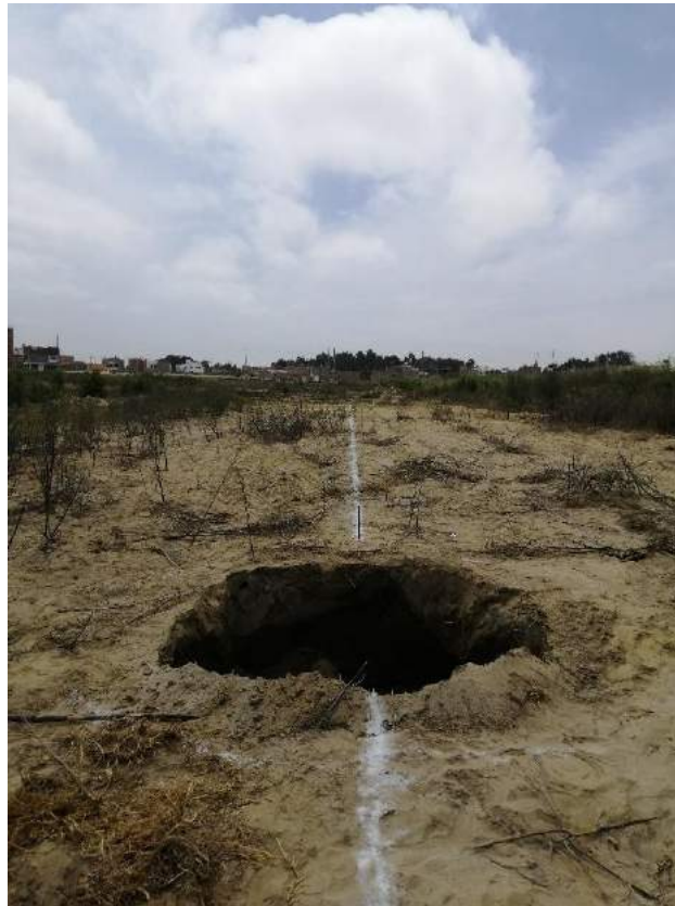
Foto 05 .- Excavación de Calicatas en el eje propuesto
