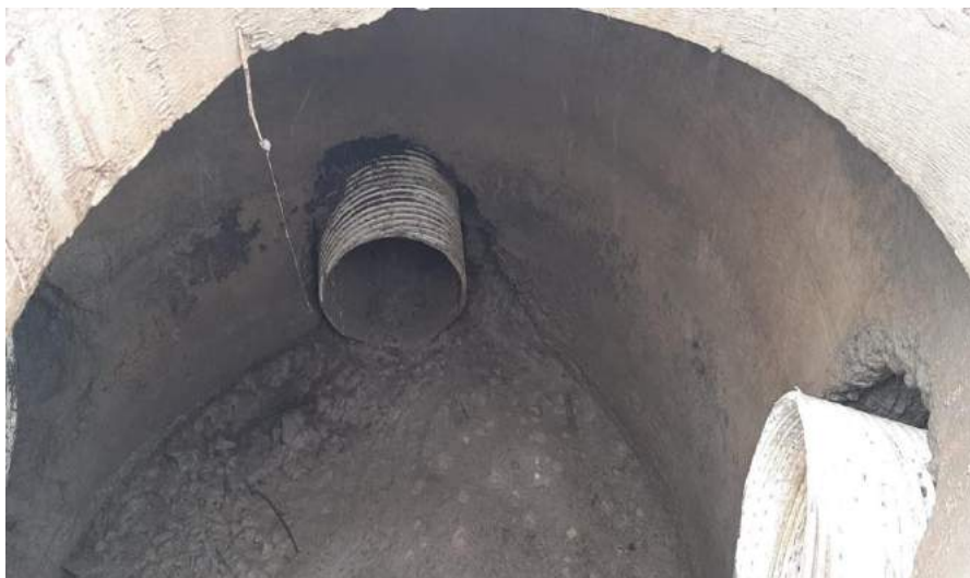
Foto 08.- Tubería Rib loc utilizada en las Praderas de Nuevo Chimbote
