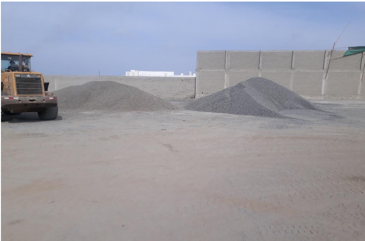
Fotografias N° 01: EXTRAENDO AGREGADOS DE LAS CANTERAS.
