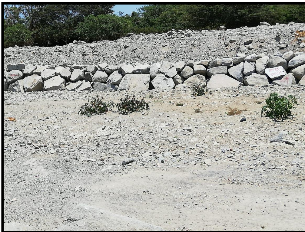
Figura 32 Se observa parte de la sección del río Sechín aguas abajo.
