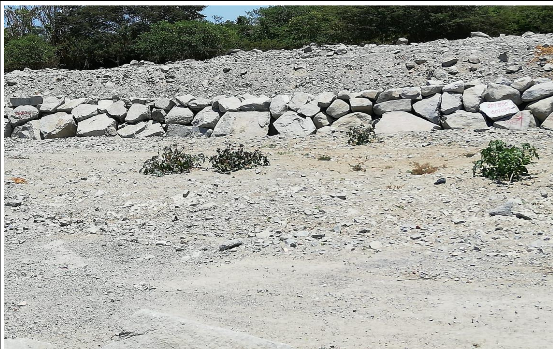
FOTO N° 10: Se observa el enrocado del rio Sechín aguas abajo en la sección N° 10.
