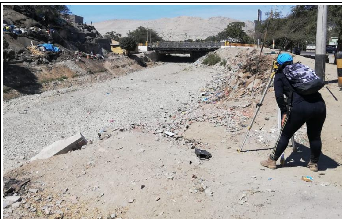
FOTO N° 04: Se observa la toma de medidas de la sección N° 1 aguas arriba del puente Sechín cada 20 metros con el nivel de ingeniero
