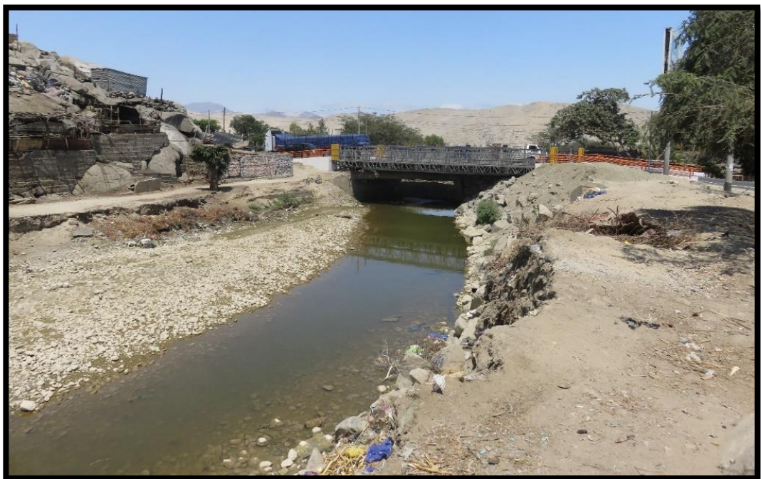
Figura 31 Vista del Puentes Sechín aguas arriba.
