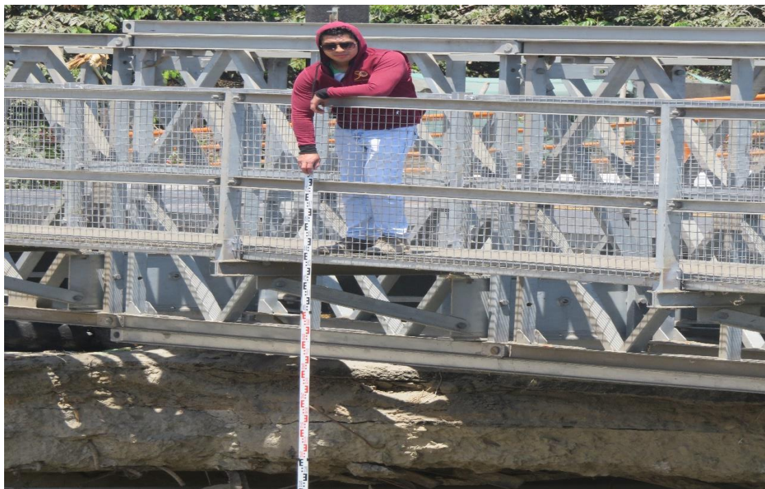
FOTO N° 06: Se observa la toma de medida del fondo del río y el alto de la plataforma del puente del río Sechín.
