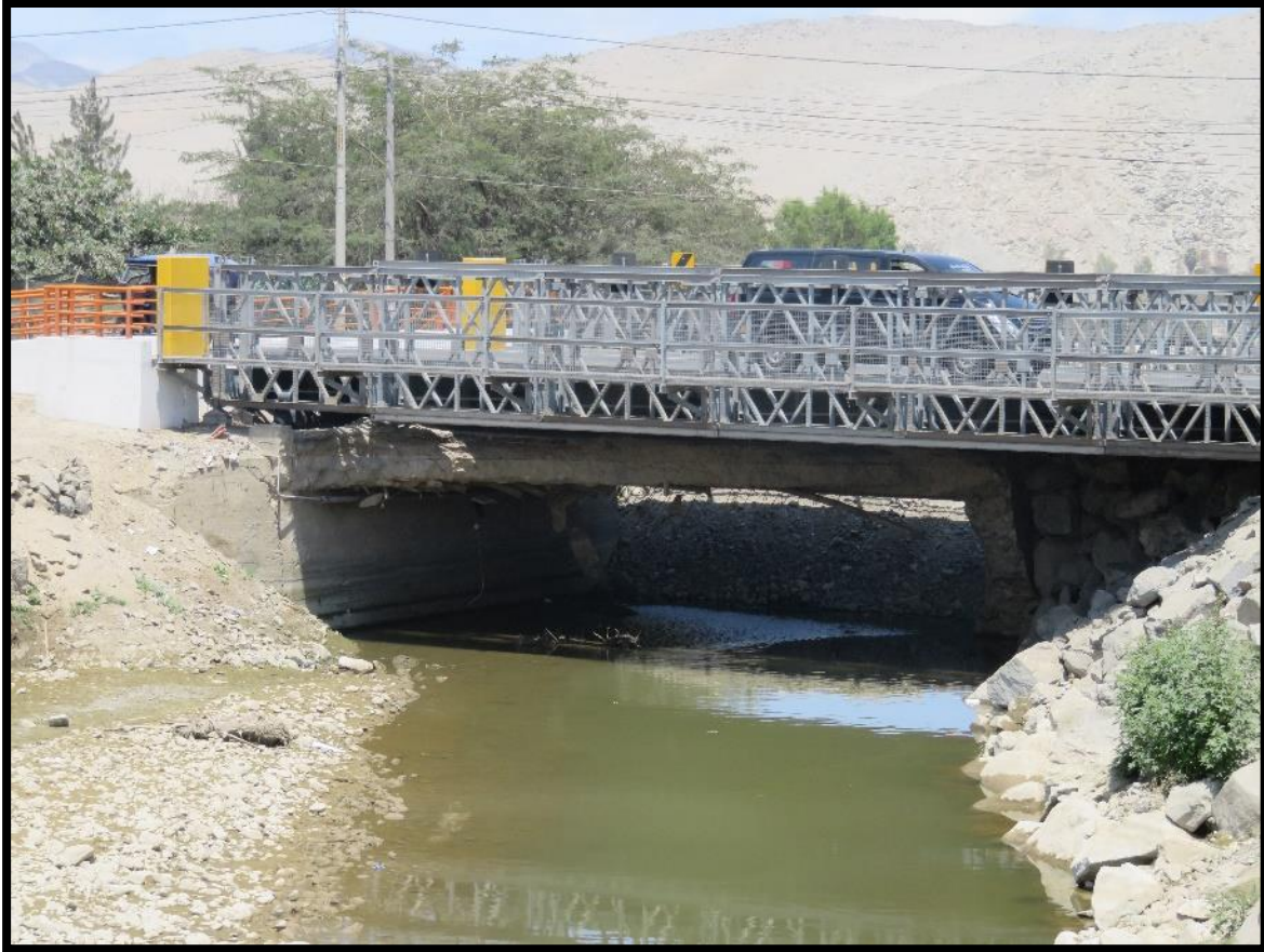
Figura 13 Vista del Puente Bailey Sechin
