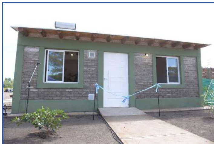
Figura 8: Vivienda a base residuos sólidos
