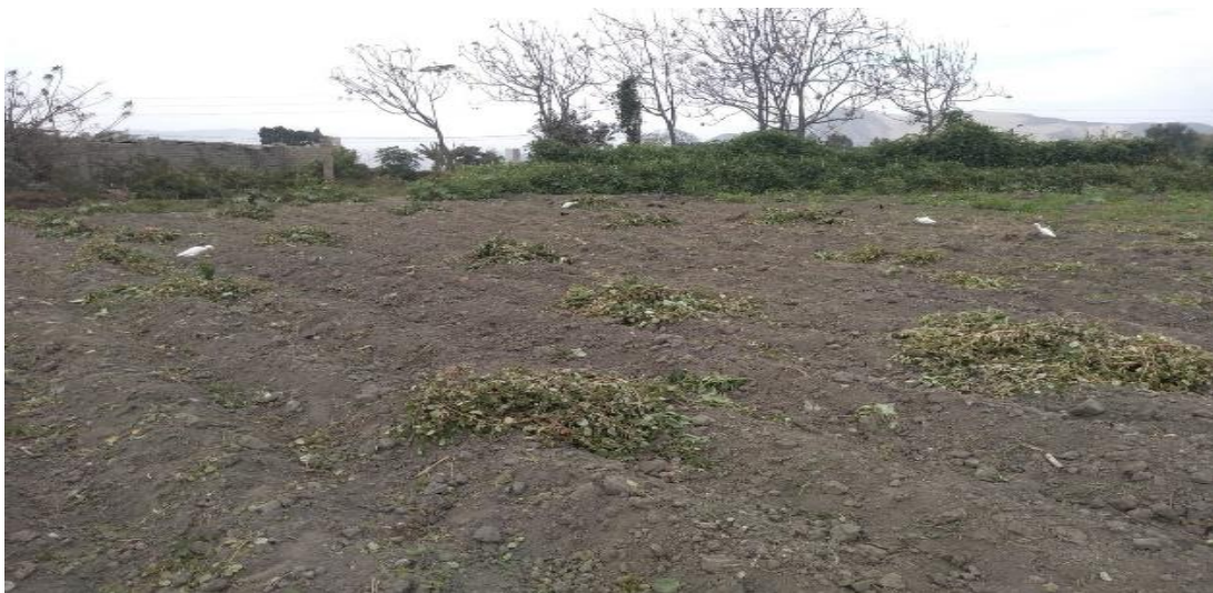
Figura 2. Limpieza de terreno
