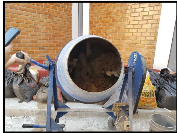
Foto 10: Mezcla de concreto en el trompo.
