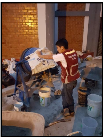
Foto 11: Cubriendo el trompo mientras se espera el tiempo según el manual de ensayo de materiales.
