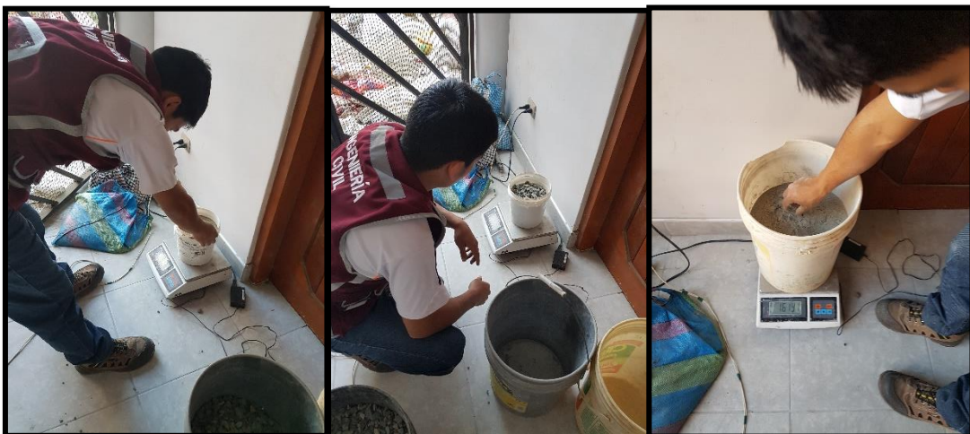
Foto 6 – Foto 7 – Foto 8: Alistando la dosificación en peso de los componentes del concreto previo al mezclado en el trompo.
