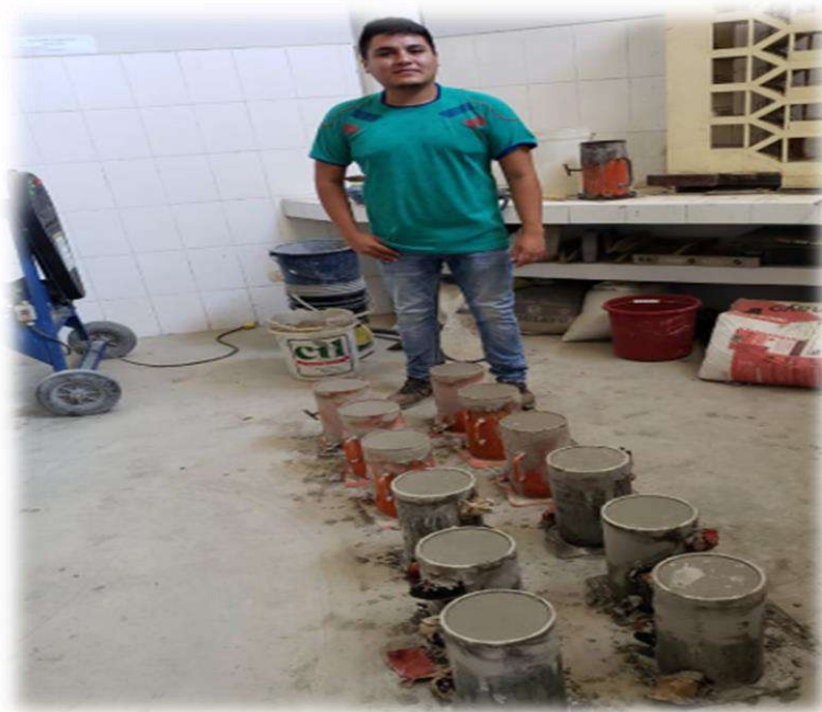
Foto 8. Elaboración de concreto según el diseño de mezcla. Fuente: Elaboración propia, 2019.
