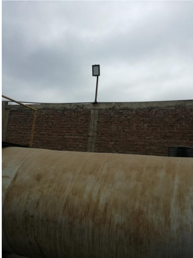
Foto N° 3: Vista perimétrica de Iluminación en baja tensión
