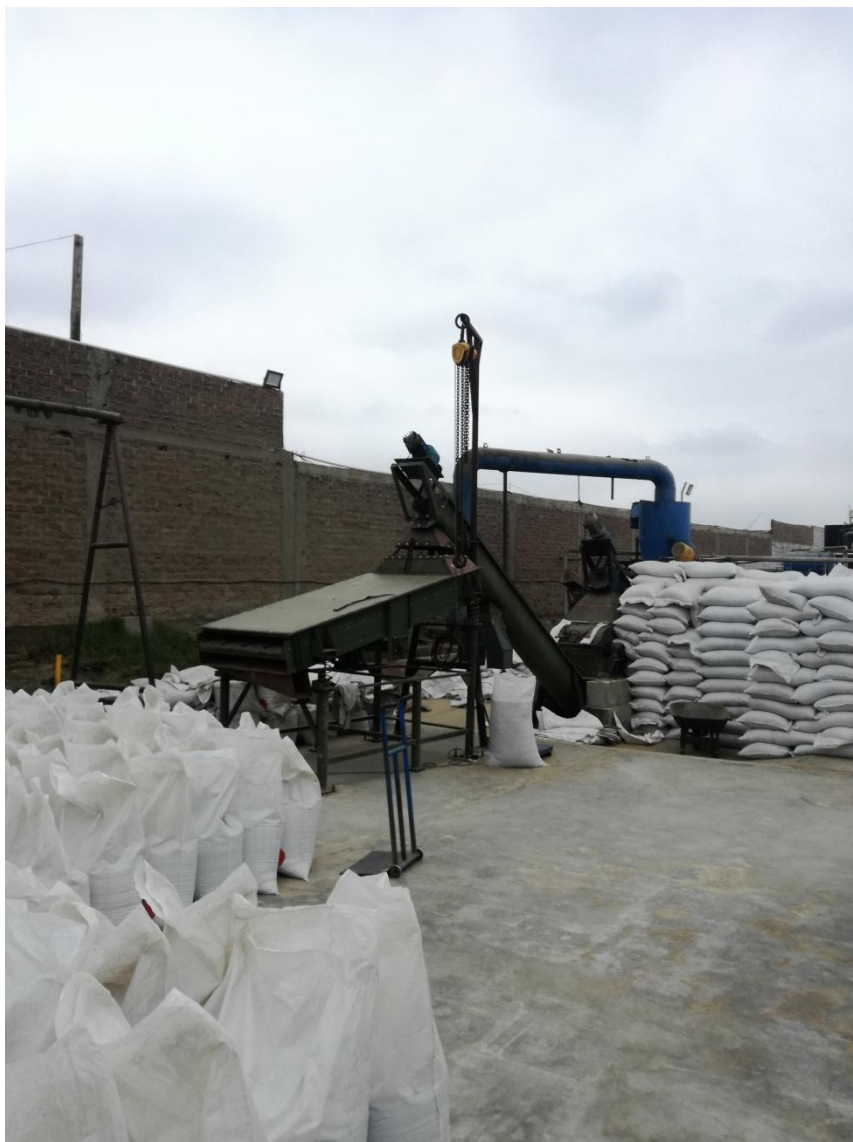
Foto N° 4: Zona de zaranda en media tensión
