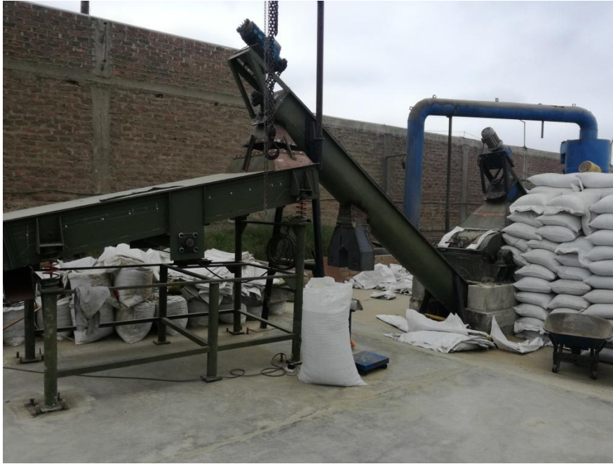
Foto N° 1: Zona de Molienda en media tensión
