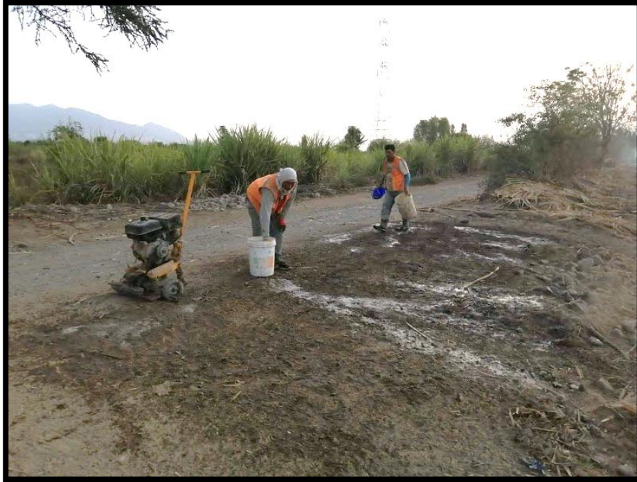
Figura N°23: Humectación del suelo de subrasante después de la escarificación del material hasta llevarlo a una condición de \pm 2\% con respecto a la humedad óptima de compactación obtenida en laboratorio.
