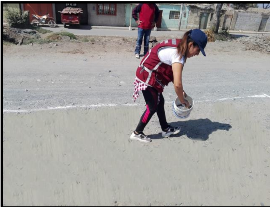
Figura N°17 y 18: Tendido y esparcimiento manual de la mezcla de ceniza de cáscara de arroz y cal en el tramo de prueba a estabilizar, para ser mezclado con el suelo en estudio.
