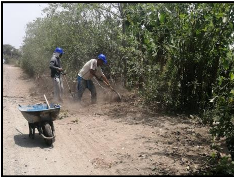
Figura N°15 y 16: Escarificación y homogeneización de la subrasante a lo largo y ancho del tramo de prueba, empleándose rastrillo, palanas y barretas.
