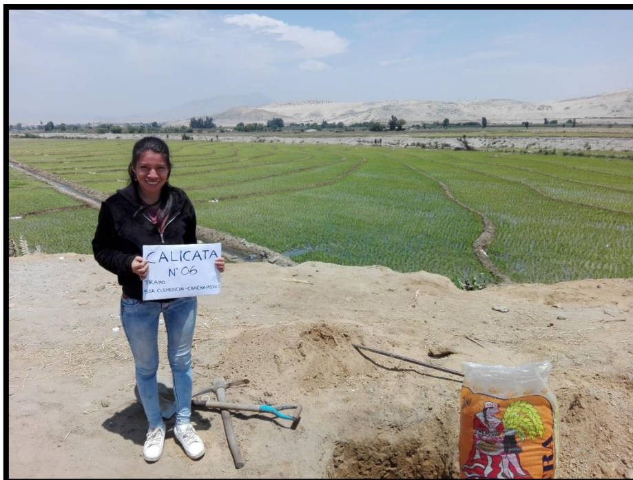
Figura N°06: Excavación y toma de muestra de suelo de la calicata C-06 en la vía Santa Clemencia – Chachapoyas.
