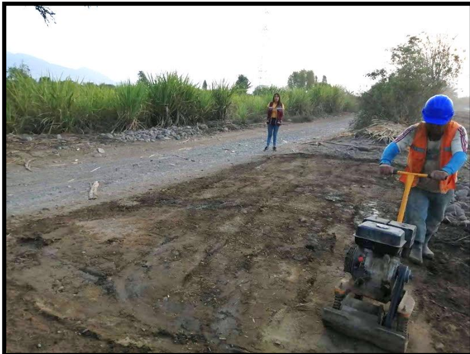
Figura N°24: Compactación del área de prueba con 01 plancha compactadora. La superficie terminada del tramo de subrasante no presenta deformaciones ni altibajos.
