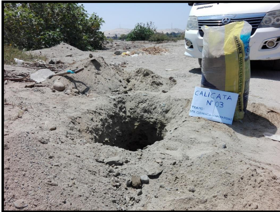
Figura N°03: Excavación y toma de muestra de suelo de la calicata C-03 en la vía Santa Clemencia – Chachapoyas.
