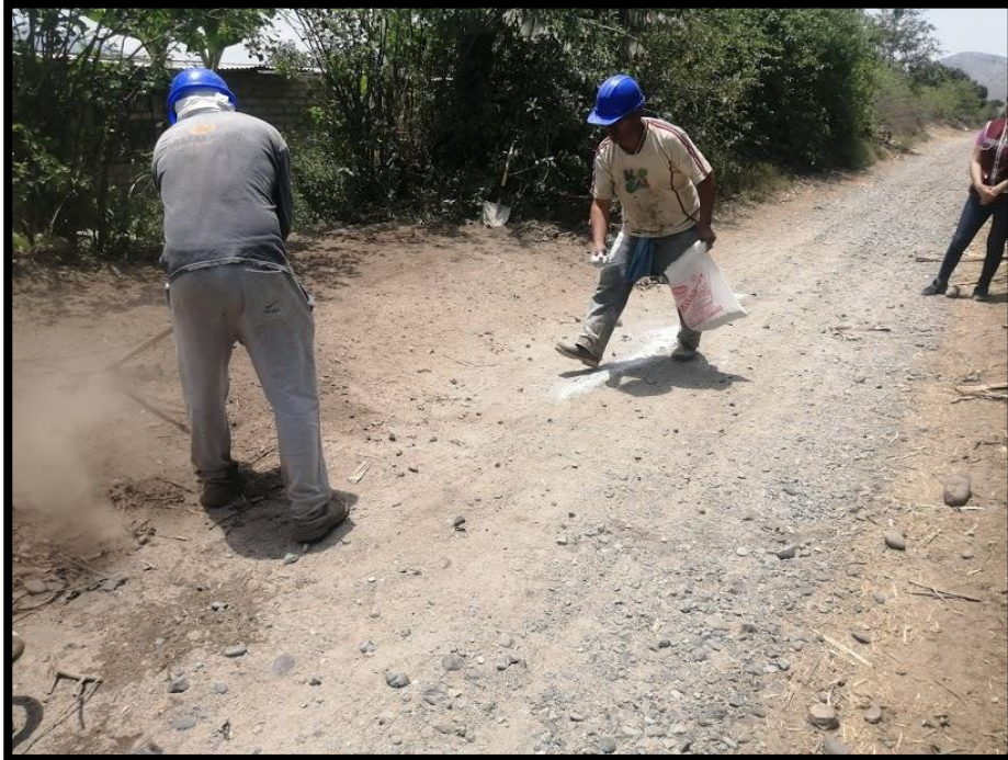
Figura N°11: Demarcación del tramo de prueba, con un área de 3m x 6m.
