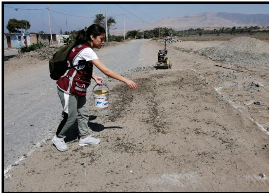
Figura N°19: Tendido y esparcimiento manual de la mezcla de ceniza de cáscara de arroz y cal en el tramo de prueba a estabilizar, para ser mezclado con el suelo en estudio.
