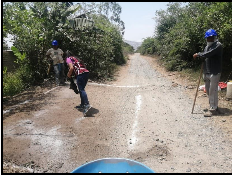
Figura N°19: Tendido y esparcimiento manual de la mezcla de ceniza de cáscara de arroz y cal en el tramo de prueba a estabilizar, para ser mezclado con el suelo en estudio.
