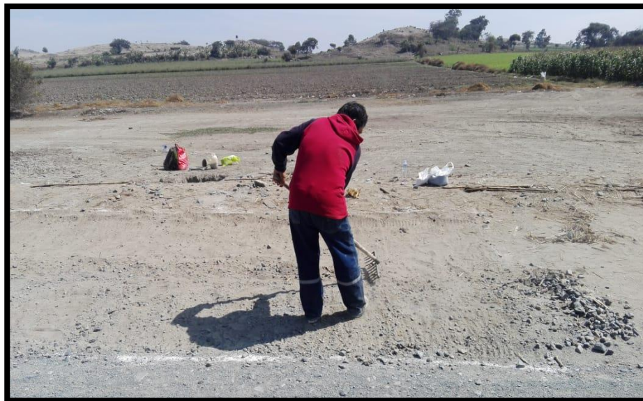
Figura N°13 y 14: Escarificación y homogeneización de la subrasante a lo largo y ancho del tramo de prueba, empleándose rastrillo, palanas y barretas.
