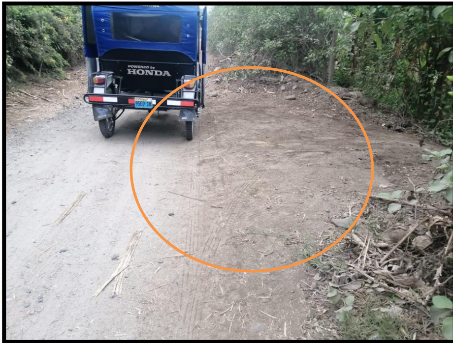
Figura N°39 y 40: Evaluación del tramo de prueba a los 15 días de realizada la compactación.
