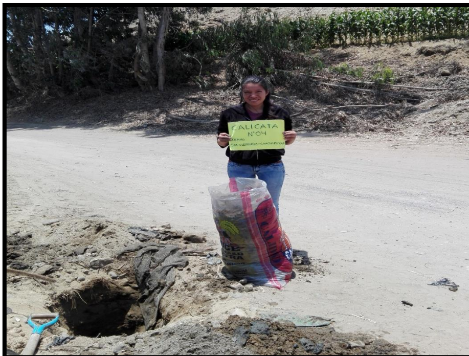
Figura N°04: Excavación y toma de muestra de suelo de la calicata C-04 en la vía Santa Clemencia – Chachapoyas.
