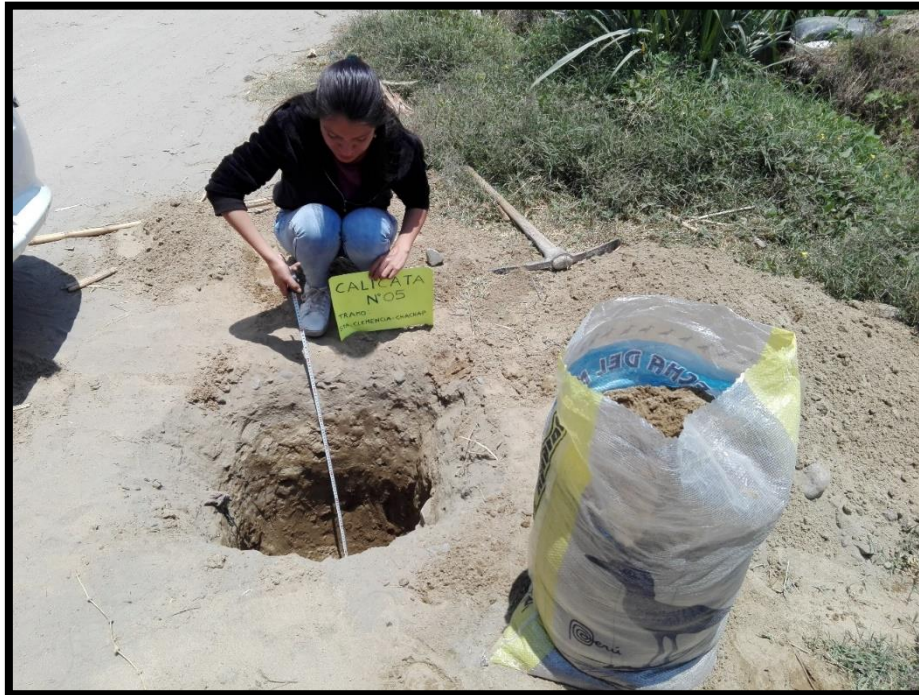
Figura N°05: Excavación y toma de muestra de suelo de la calicata C-05 en la vía Santa Clemencia – Chachapoyas.
