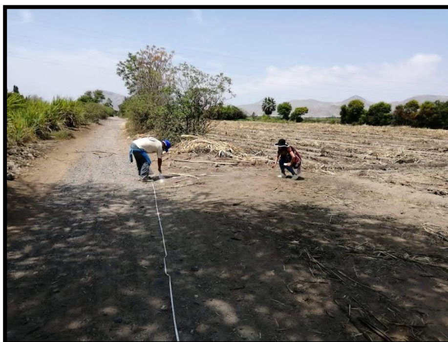
Figura N°09 y 10: Demarcación del tramo de prueba, con un área de 3m x 6m.
