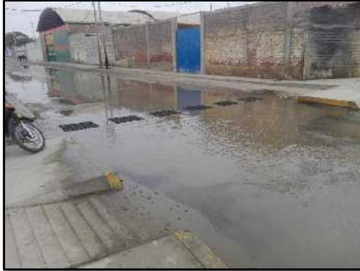
Foto N°01: Problemas de inundación en Piura durante la visita realizada. Se pudo observar que un sistema de drenaje convencional no resuelve los problemas generados por las lluvias.
