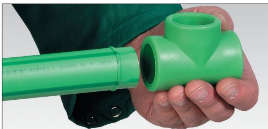
Figura 7: Acoplamiento y alineamiento del tubo.
