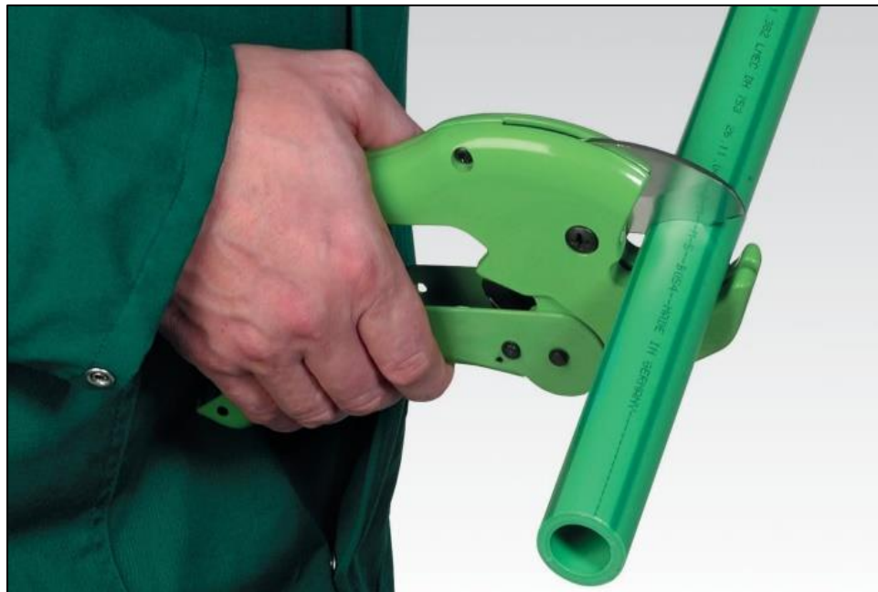
Figura 4: Corte de la tubería.
