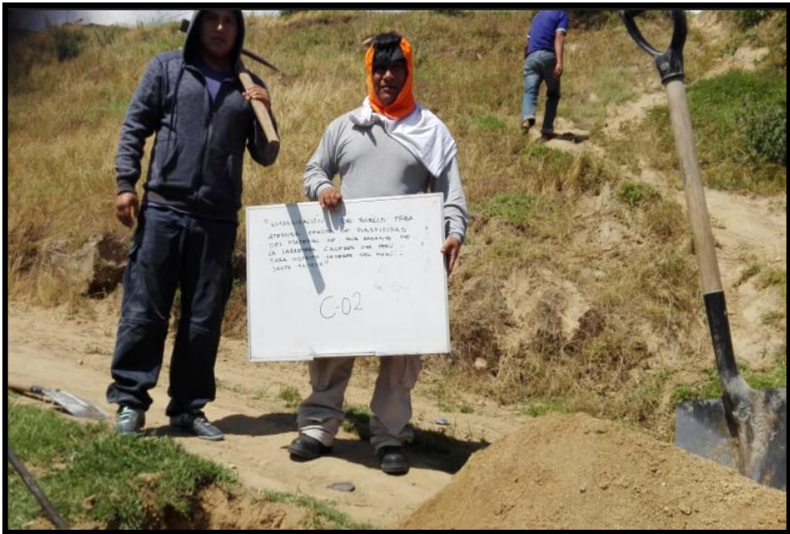
Fotografía 3. Excavación para la toma de muestra del suelo de la calicata 02
