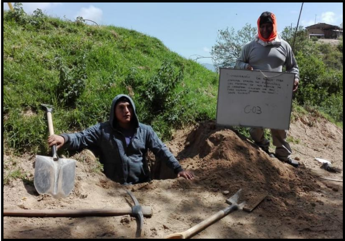
Fotografía 4. Excavación para la toma de muestra del suelo de la calicata 03
