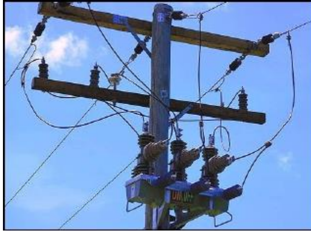
Figura 1.8. Reconector Trifásico
