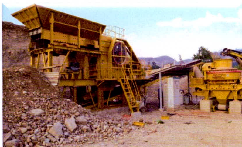
Figura 45: Lugar de procesamiento del concreto reciclado (chancadora Roca Fuerte)
