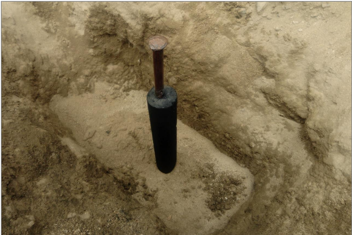
Figura N o 11.- Instalación de electrodo de 5/8" con 2" de diámetro y 1 m de largo del cilindro formado por el cemento conductivo alrededor del electrodo.
