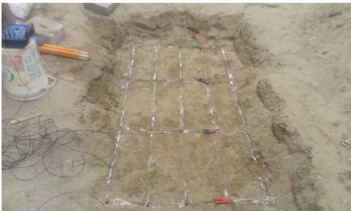
Figura N o 16.- Medición de resistividad con el Teluometro Megabras para la prueba de sal industrial.
