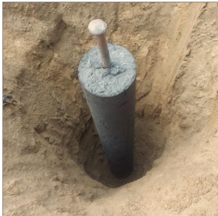
Figura N o 12.- Instalación de electrodo de 5/8" con 4" de diámetro y 1 m de largo del cilindro formado por el cemento conductivo alrededor del electrodo.
