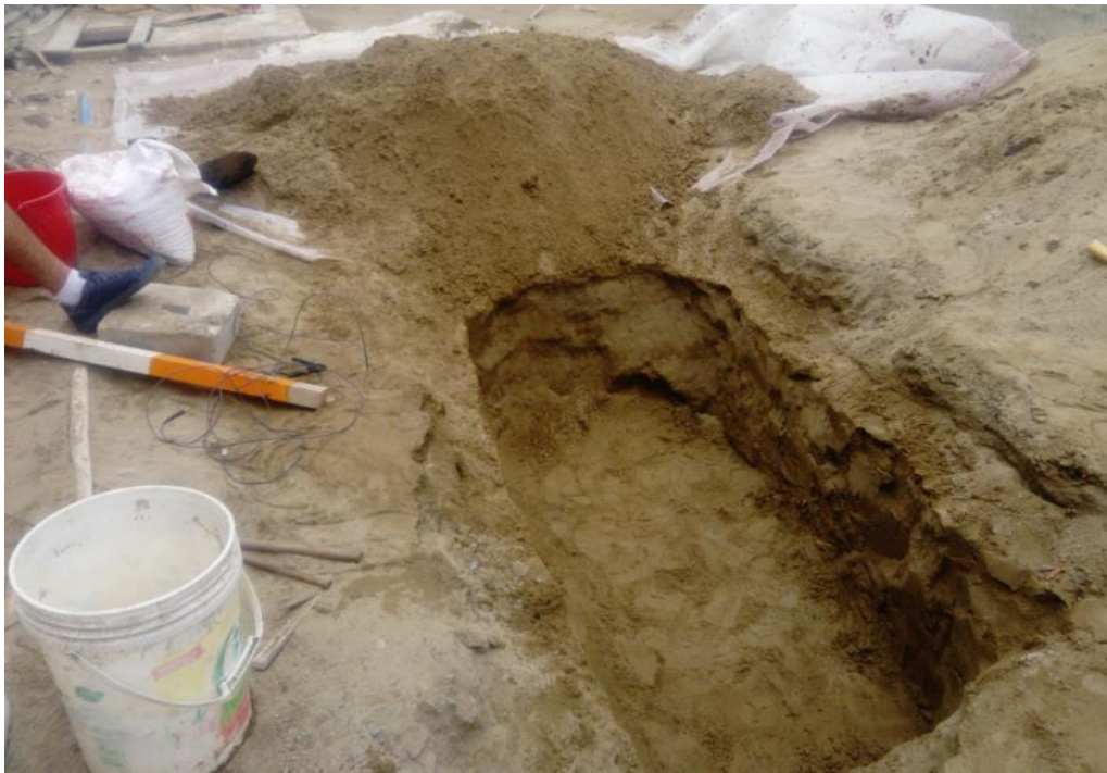
Figura N o 15.- Excavación de la zanja de dimensiones 2m x 1m x 0.5 m para realizar la prueba con sal industrial.
