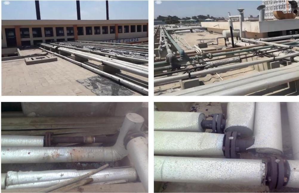
*Figura N° 21:* Deterioros en las redes de vapor.
