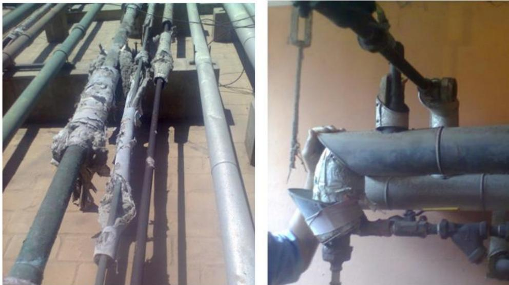
*Figura N° 22:* Deterioros en la red de retorno de condensado.
