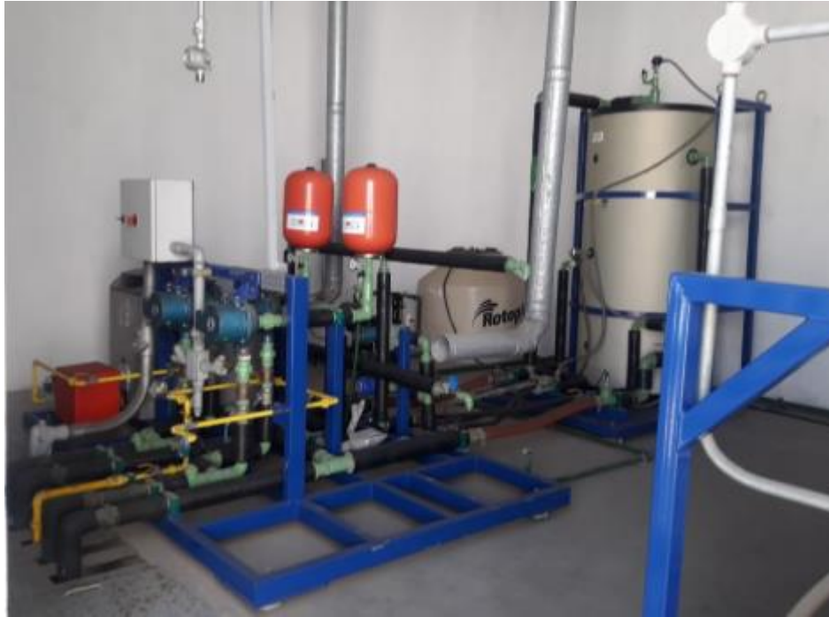
Figura 5. Unidad de calentamiento y tanque de agua de RCU 4000
