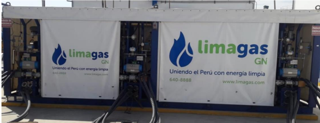
Figura 3: Unidad de reducción y control de presión – RCU de Copeinca Chancay.
