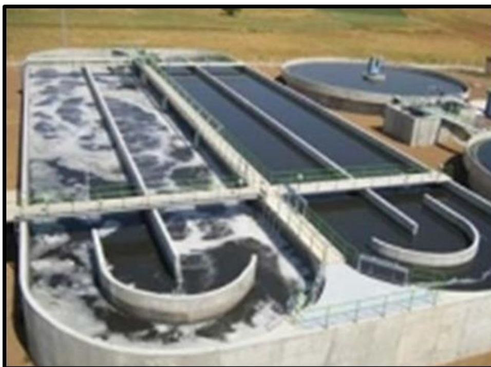
Figura N° 14: Cámara de mezclado con agentes purificadores
