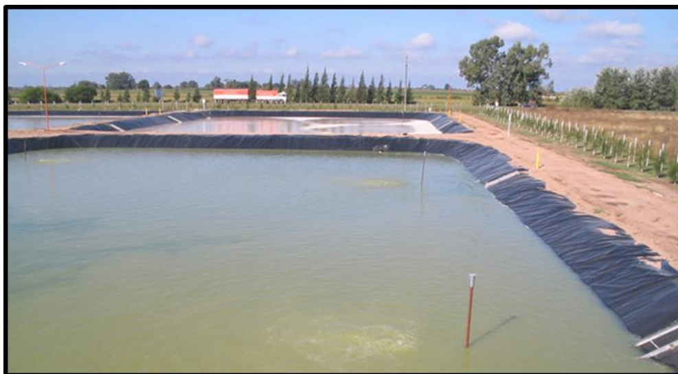
Figura N° 11: Pozas para laguna aireada de gran extensión
