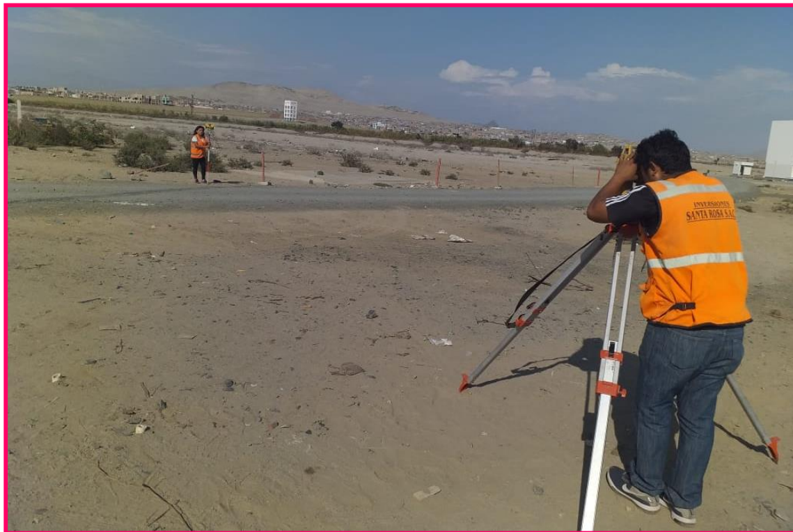
Figura N° 37: Realización de estudios topográficos de la zona donde se proyectará la PTAR.
