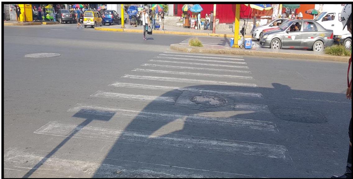
FOTO N° 14: Desgaste de paso peatonal en la intersección Jr. Leoncio Prado con Av. José Gálvez.
