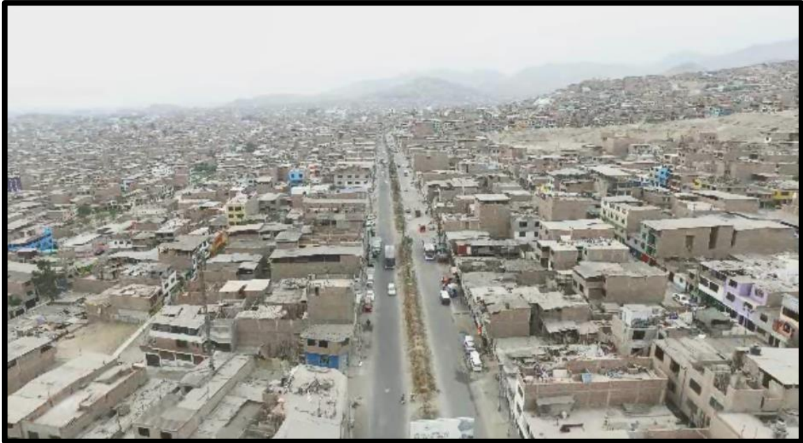
Fotografía 5 captada con dron
