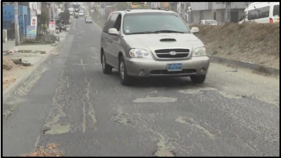
Fotografía 4 captada con dron
