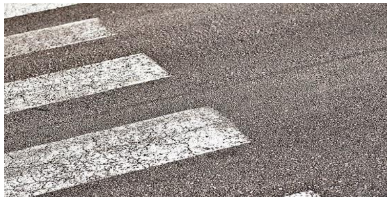
Figura 26: Microtextura utilizada en pavimentos en Lima
