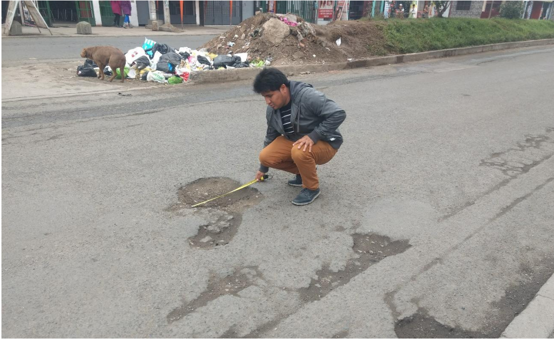
Figura 53: Tomando medidas de las dimensiones de los baches en la vía
