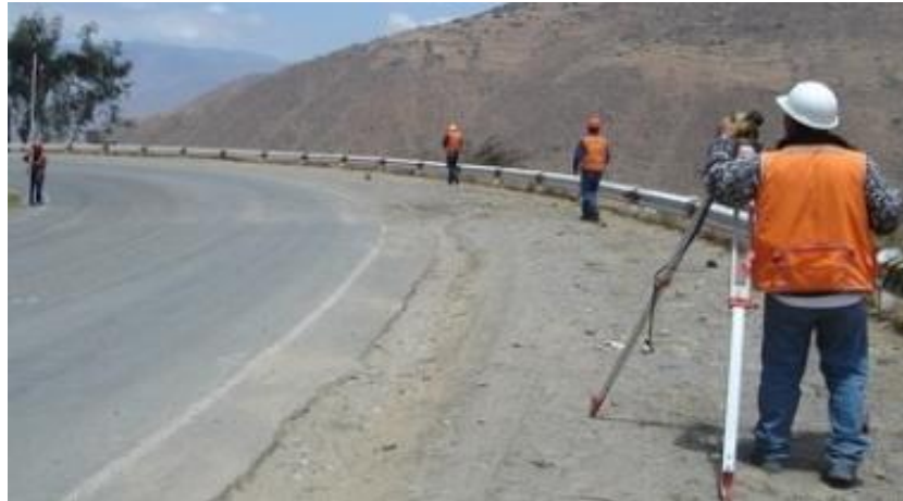
Figura 32: Nivel y mira topográfica
