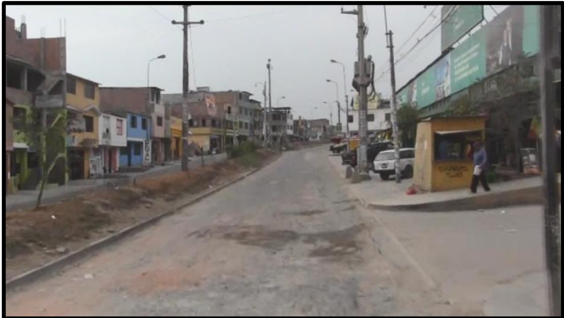
Fotografía 8 captada con dron
