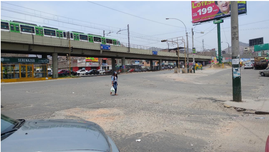
Figura 55: Punto de Control 01, Avenida los Héroes, sector 03
