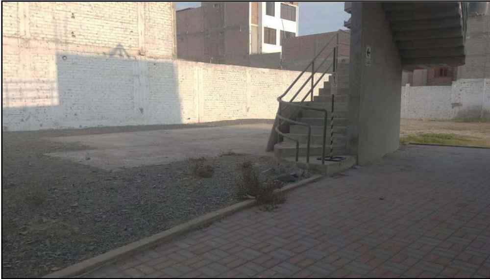
Foto N° 03: Área destinada para la sala de exposiciones.
