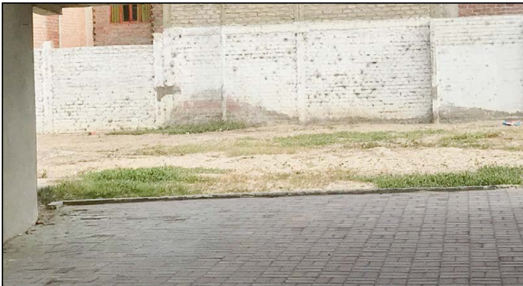
Foto N° 02: Área destinada para la construcción del semisótano.
