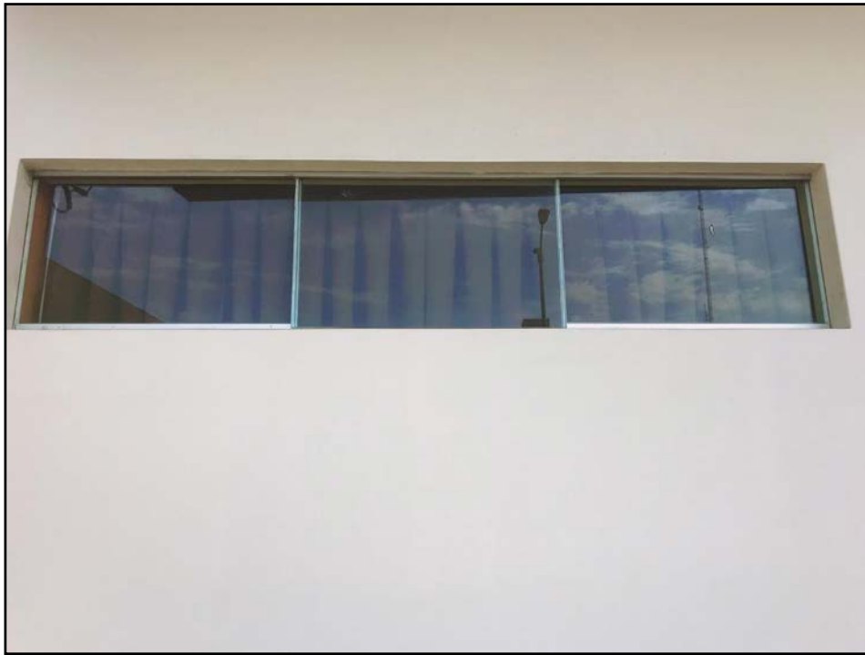
Foto N° 05: Muro con ventana del módulo existente, tarrajado.
