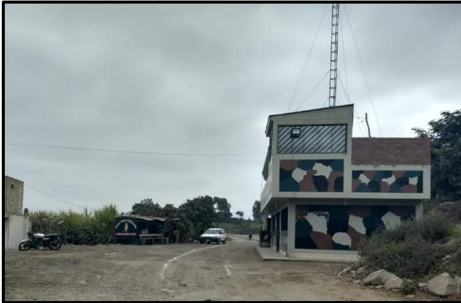
FOTO 01. Garita de control vehicular.
