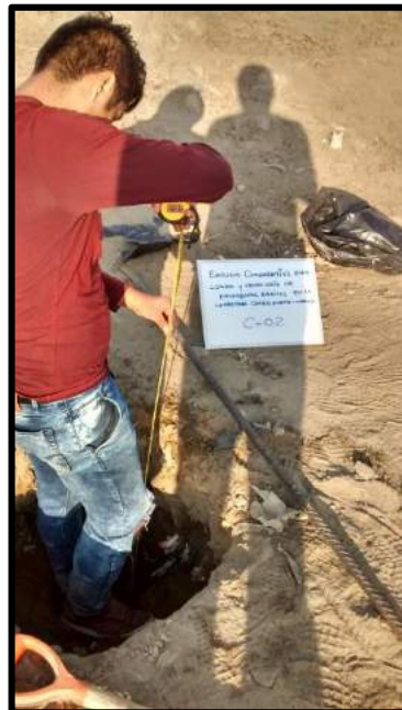
FOTO 02. Se verifico la profundidad de la calicata con la wincha.
