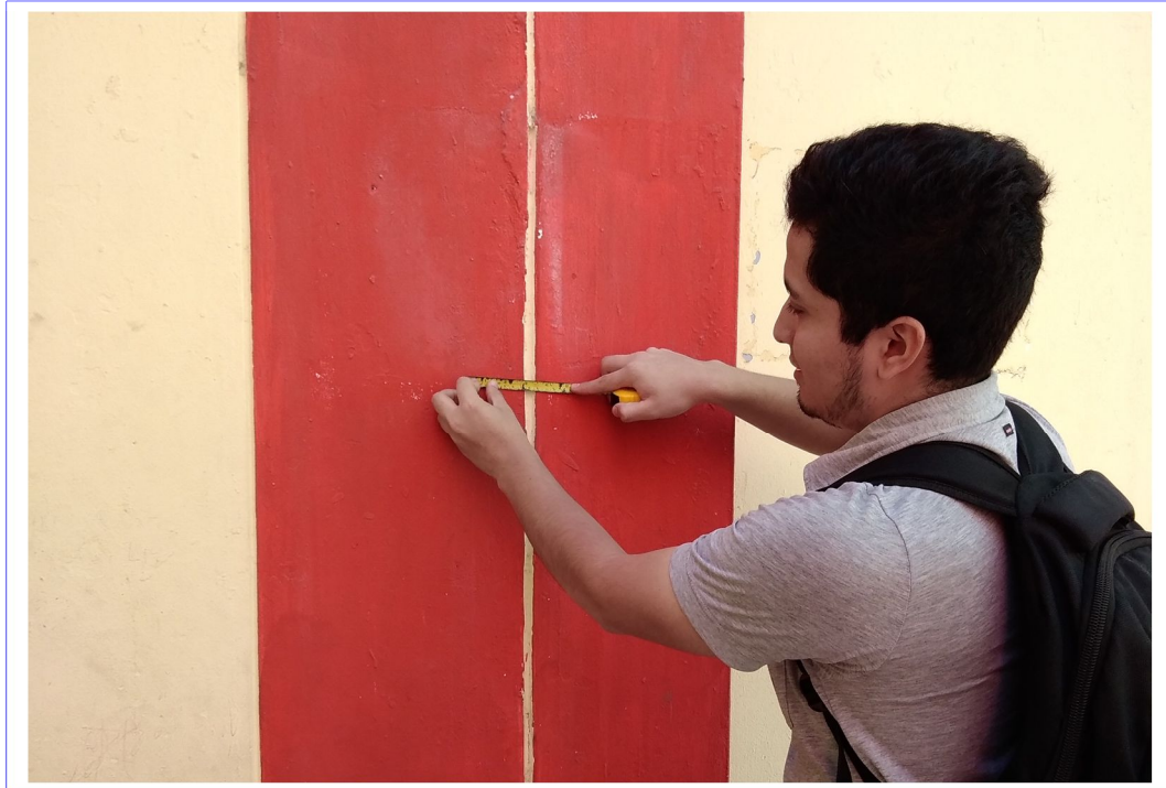
FOTO N° 09 MIDIENDO LA JUNTA SÍSMICA EN EL MÓDULO 2
