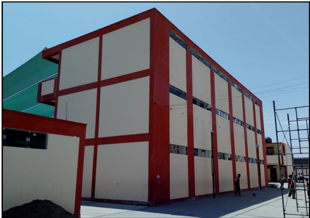
Figura 2.33. Vista lateral y posterior del pabellón “C” de la I.E. Augusto Salazar Bondy
