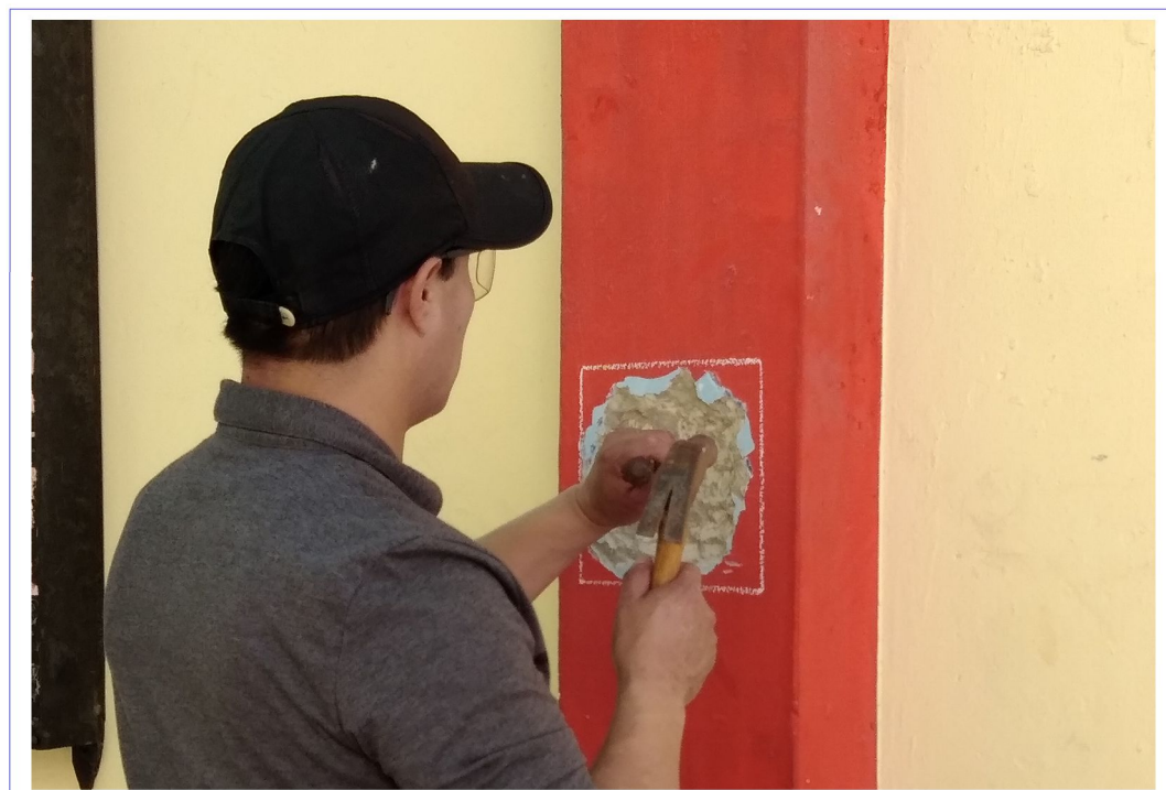
FOTO N° 12 RETIRO DEL TARRAJEO EN EL ÁREA DELIMITADA
