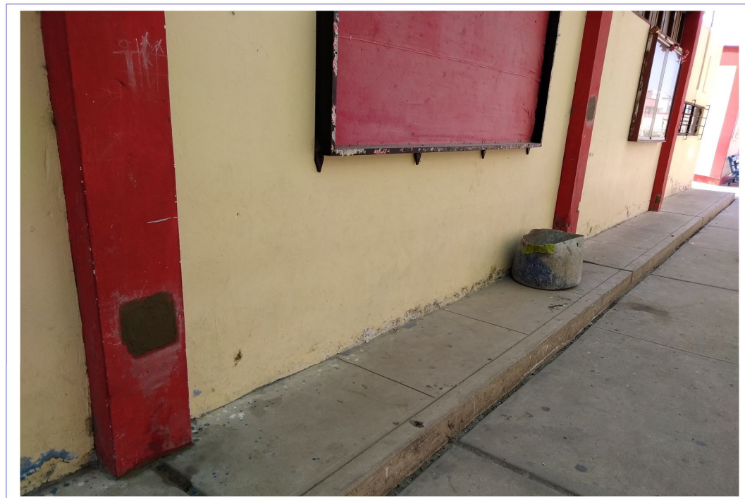
FOTO N° 22 RESANE DE ÁREAS DONDE SE REALIZARON LOS ENSAYOS
