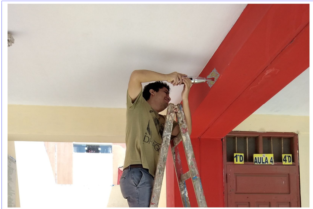
FOTO N° 19 TOMA DE ENSAYO ESCLEROMÉTRICO EN VIGAS EN MÓDULO 2
