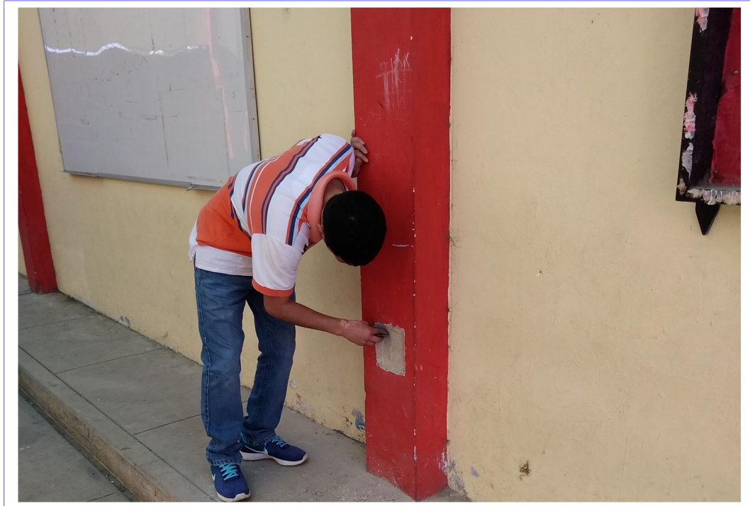
FOTO N° 13 LIJADO DE LA SUPERFICIE DELIMITADA
