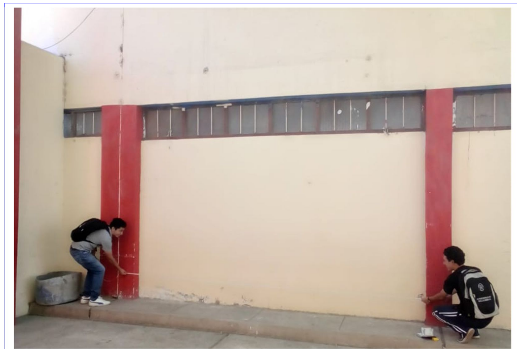
FOTO N° 06 REALIZANDO MEDIDAS EN LA ZONA POSTERIOR DEL MÓDULO 2
