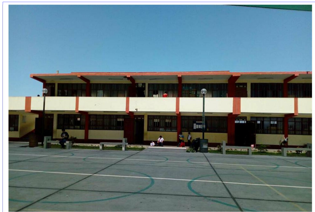
FOTO N° 04 VISTA FRONTAL DEL MÓDULO 2
