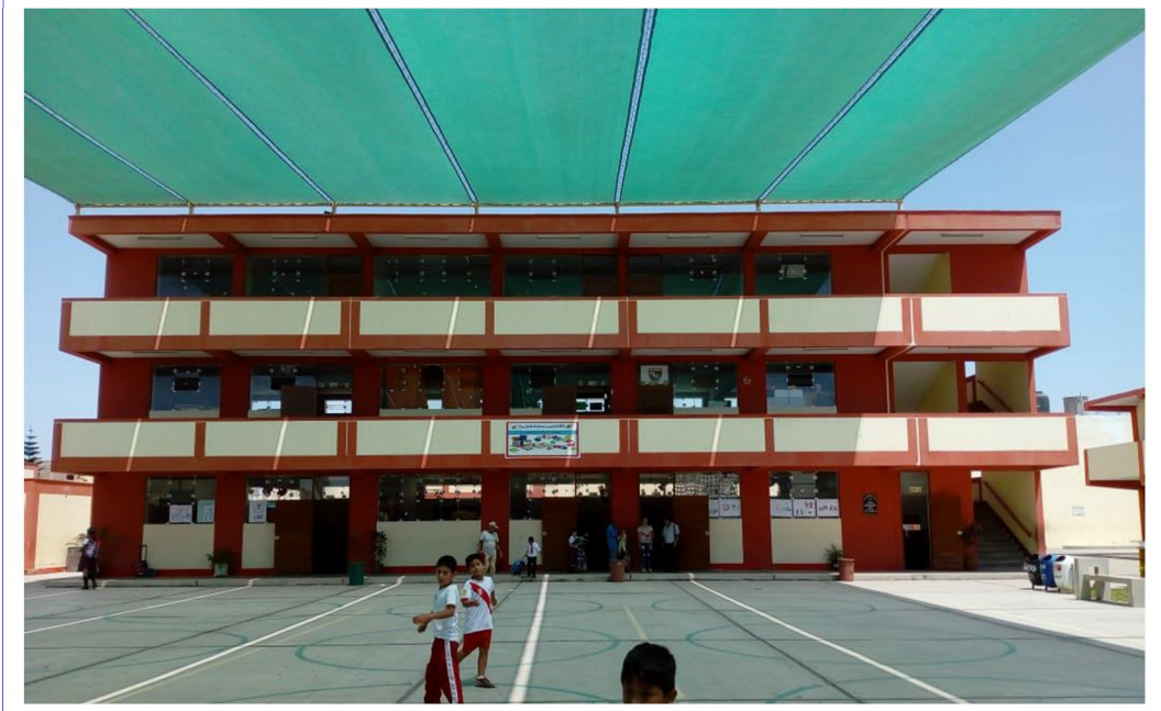
FOTO N° 01 VISTA FRONTAL DEL MÓDULO 1
