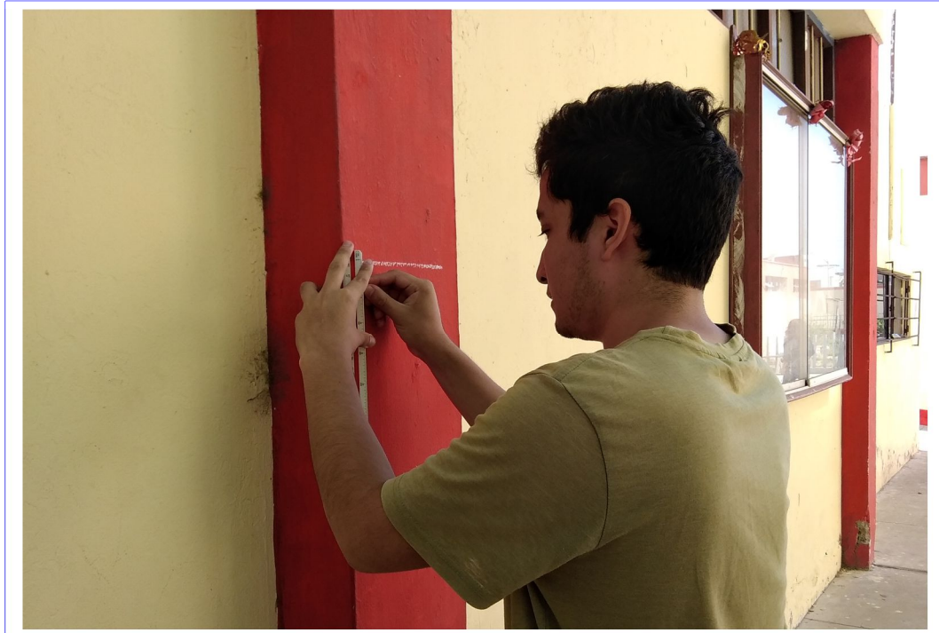
FOTO N° 11 DELIMITACIÓN DEL ÁREA DE 15x15cm PARA REALIZAR EL ENSAYO ESCLEROMÉTRICO
