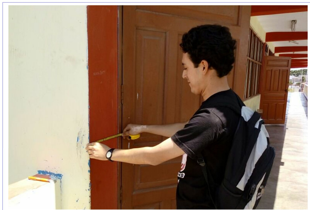
FOTO N° 08 REALIZANDO MEDIDAS EN EL CORREDOR DEL MÓDULO 2
