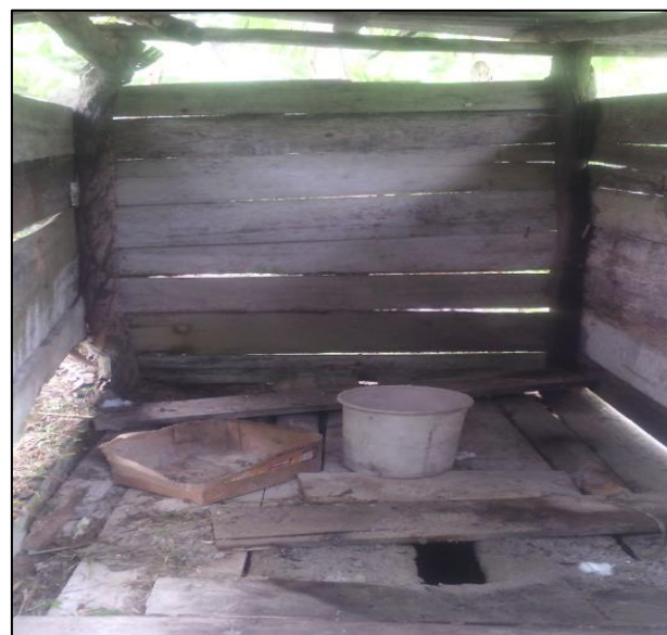
Figura 70 Vista del interior de los baños en la localidad del Alizo
