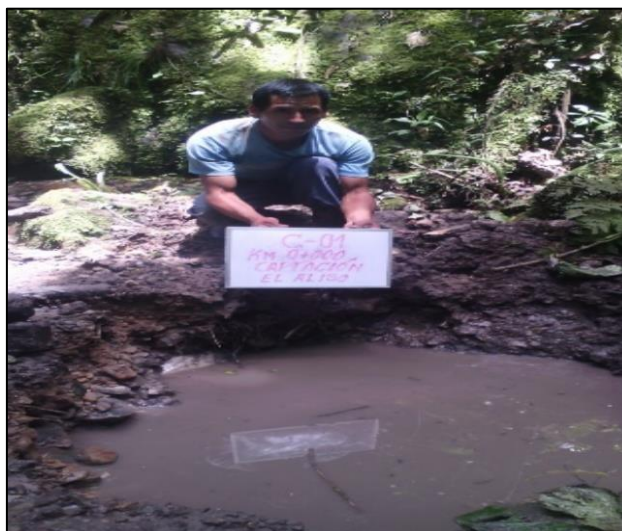
Figura 33 Calicata en captación
