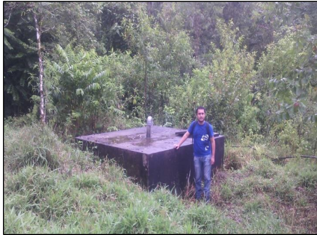
Figura 62 Vista del reservorio existente en la localidad de Alizo
