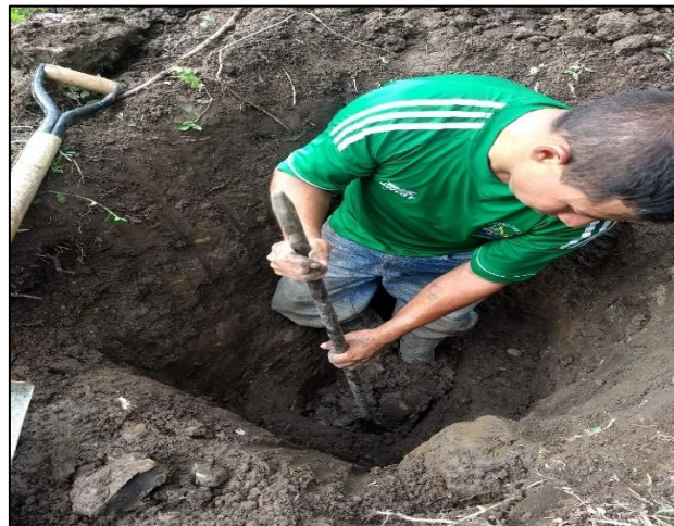
Figura 39 Vista de calicata para test de percolación
