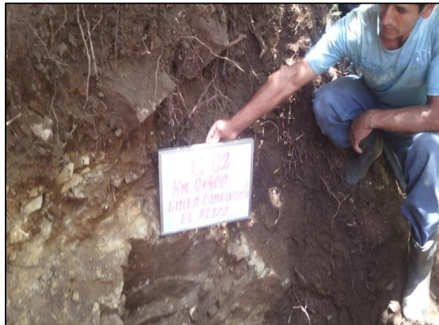
Figura 35 Vista de calicata en línea de aducción
