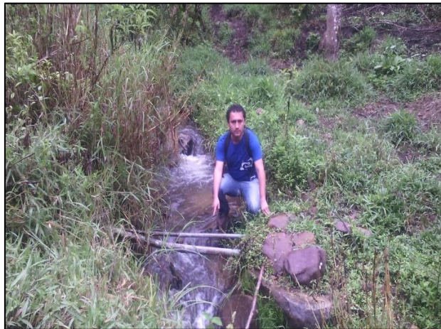
Figura 63 Líneas de conducción en mal estado de la localidad
