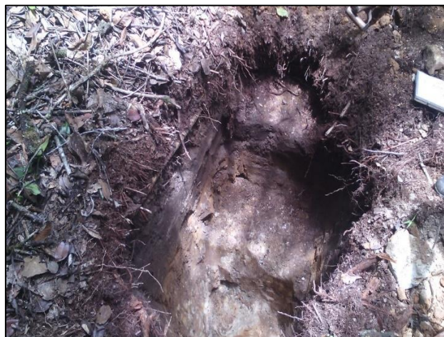
Figura 36 Vista de calicata en línea de distribución
