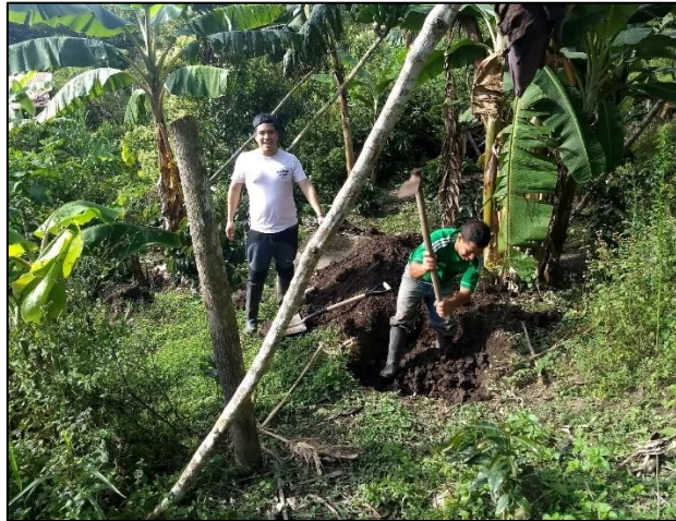
Figura 38 Vista de calicata para test de percolación
