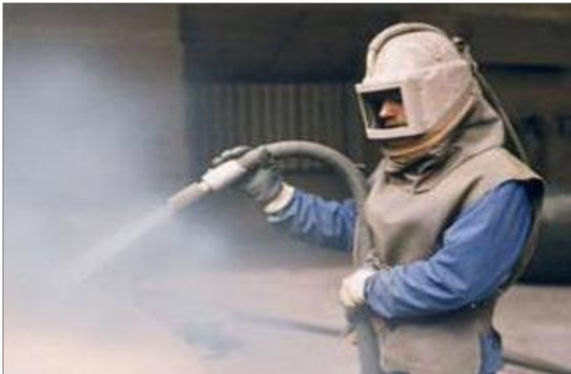
Ilustración 9 Método de preparación de la superficie: Por proyección (Obra)
