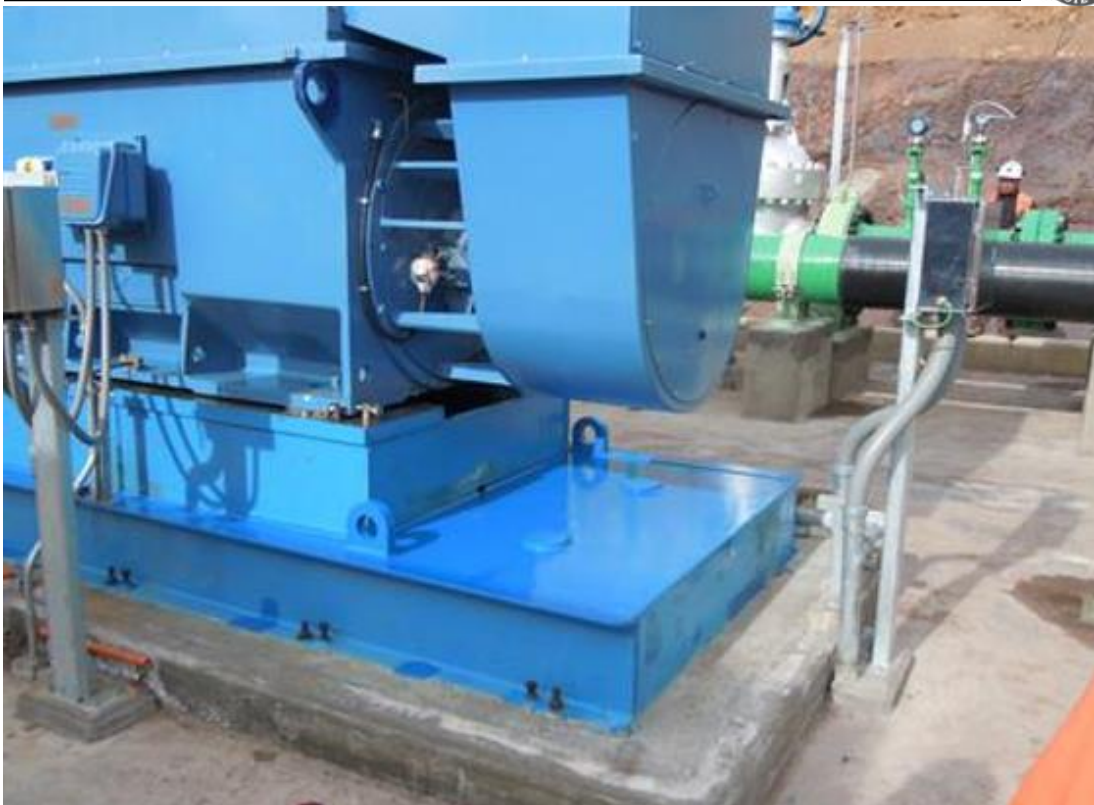
Ilustración 21 Grouting-Terminación de la superficie (Obra)
