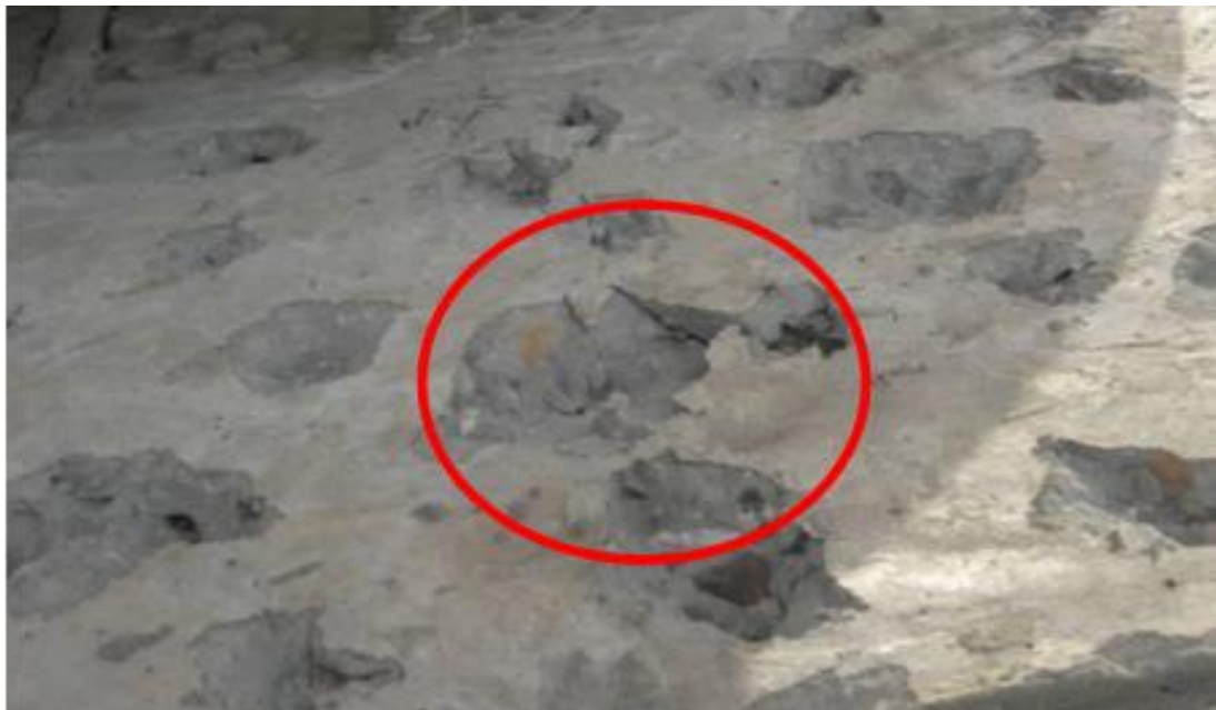
Ilustración 11 Método de preparación de la superficie: Por impacto (Obra)
