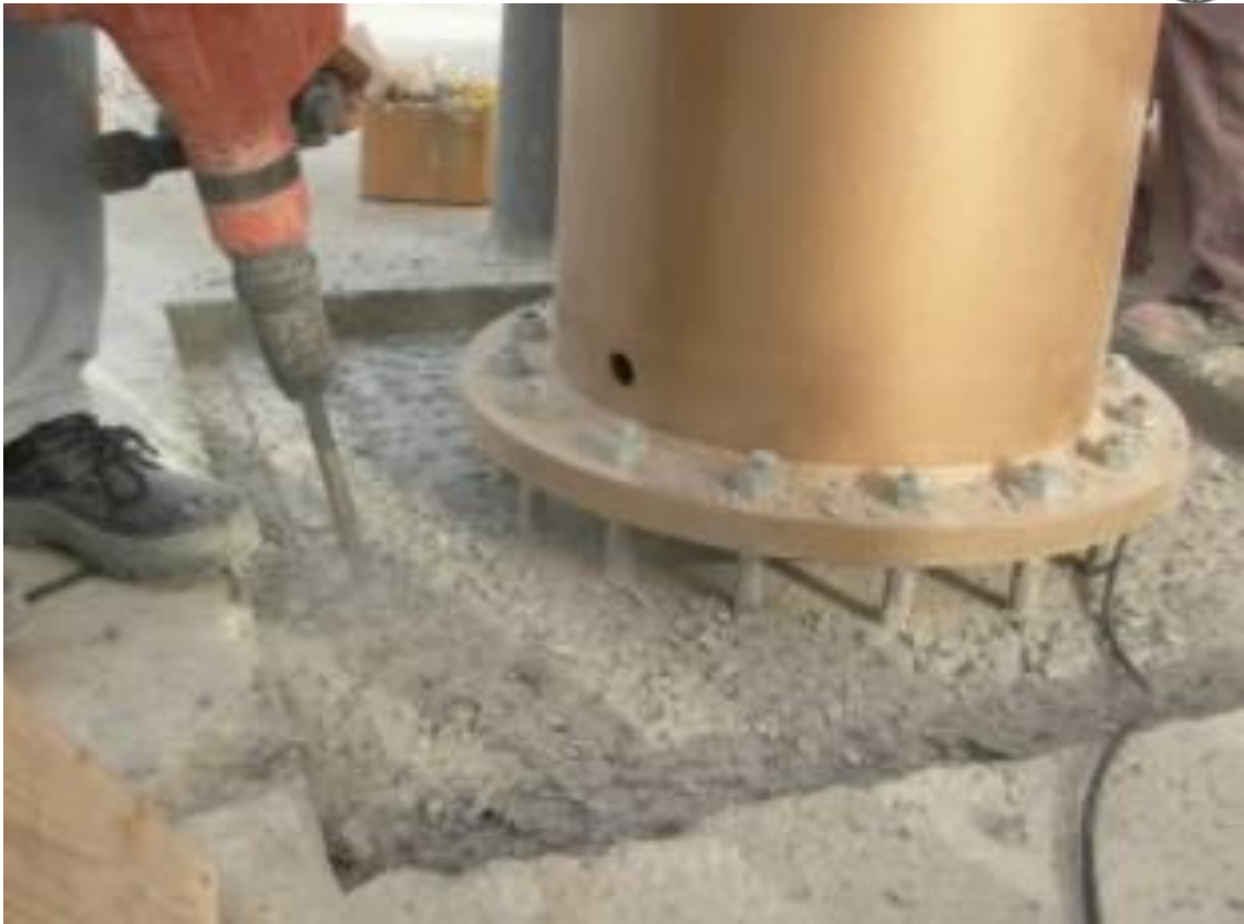
Ilustración 10 Método de preparación de la superficie: Por impacto (Obra)
