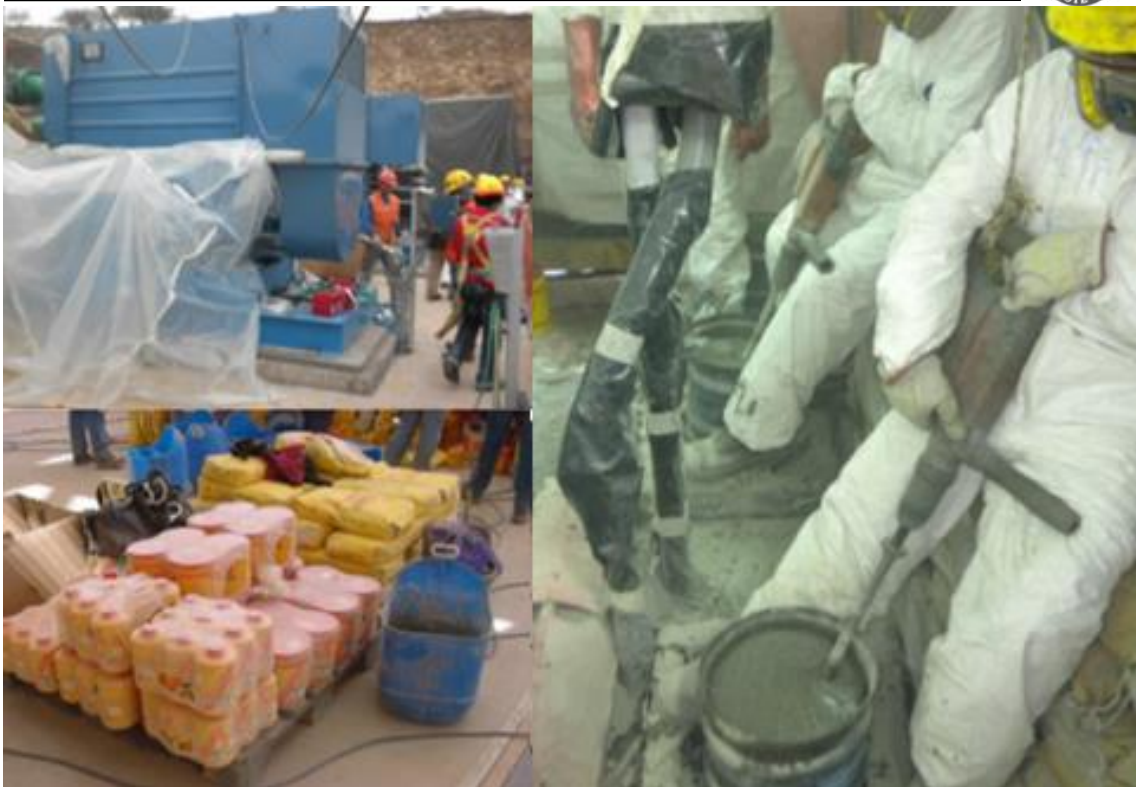
Ilustración 7 Mezcla de grout cementicio (Obra)
