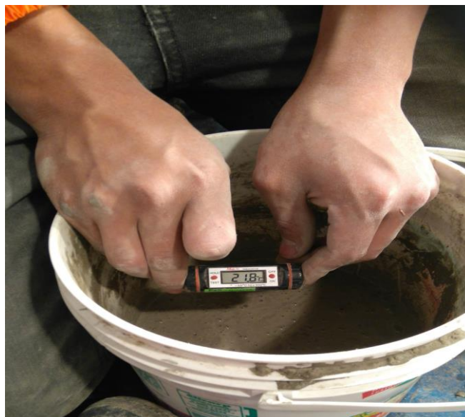
Ilustración 48 Temperatura de la mezcla (procedimiento constructivo del tesista).
