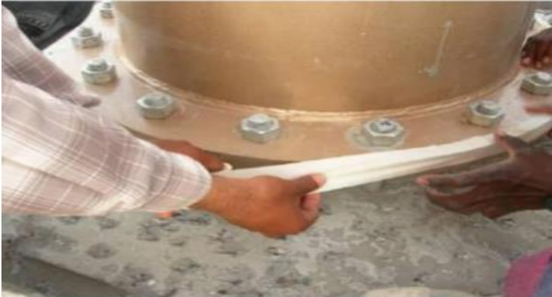
Ilustración 12 Protección del acero (Obra)
