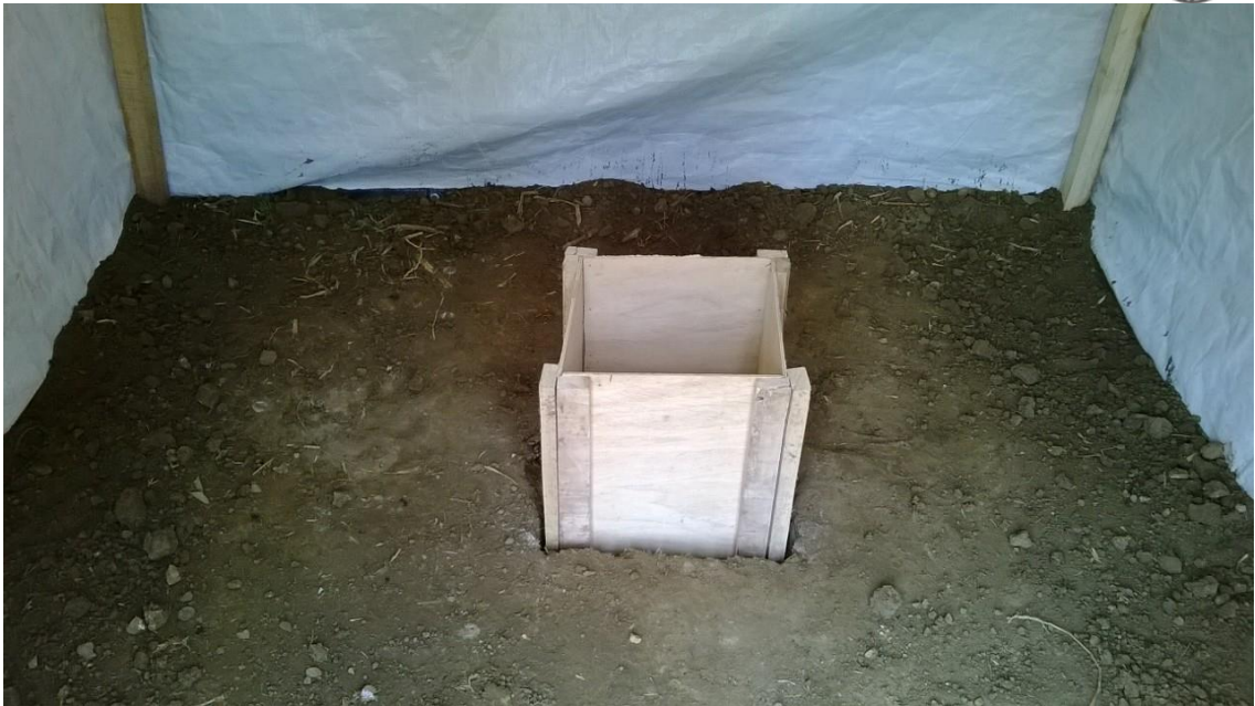
Ilustración 81 Encofrado del Microclima Huaraz
