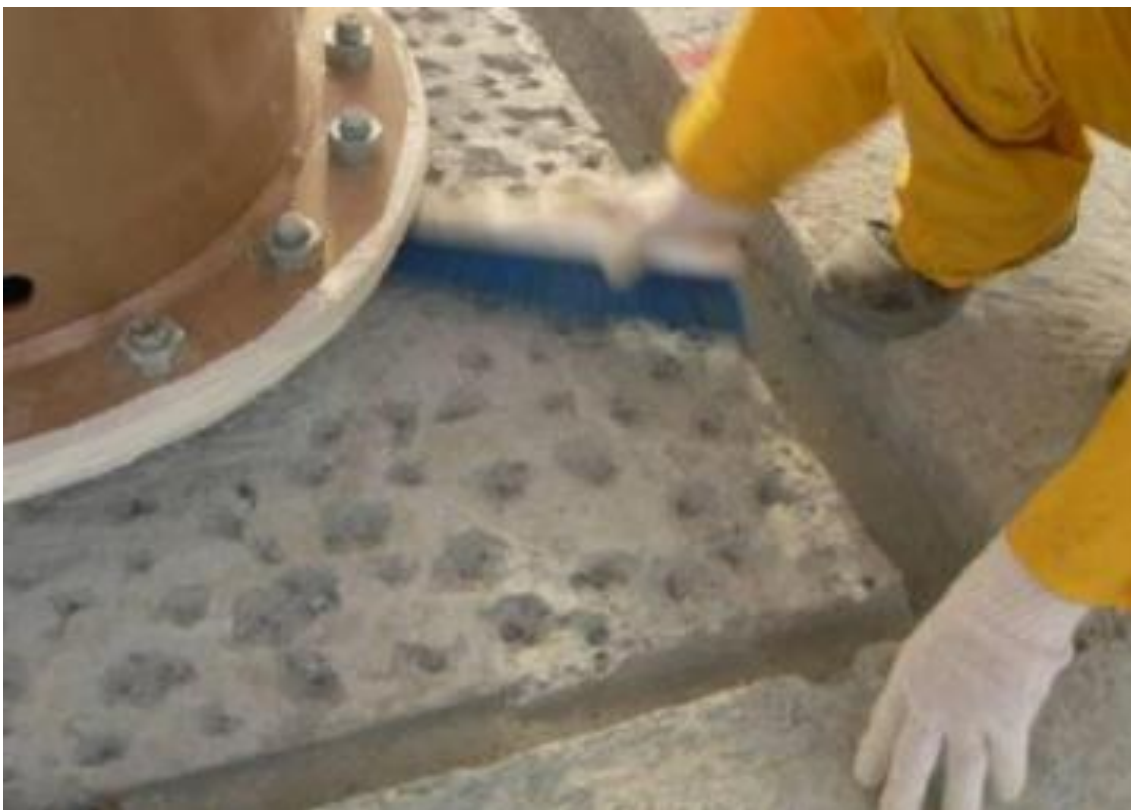
Ilustración 13 Limpieza del sustrato (Obra)
