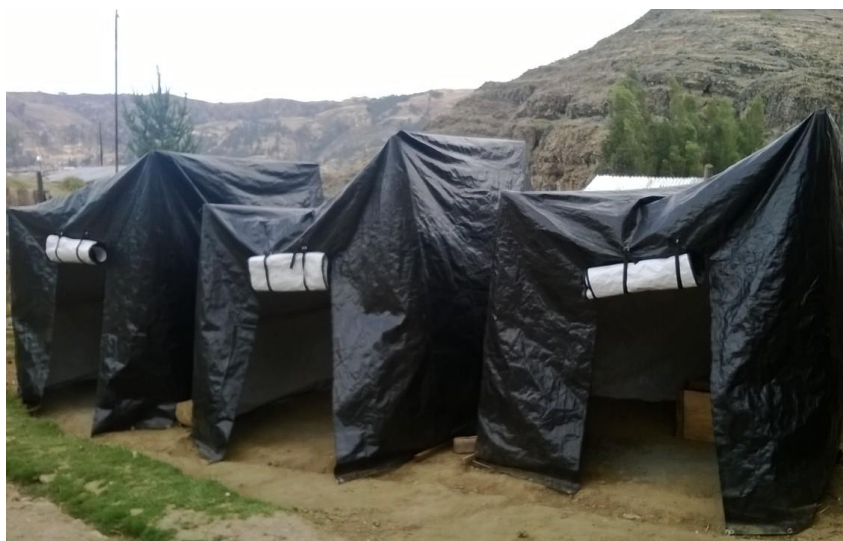
Ilustración 31 Carpa de lona (procedimiento constructivo del tesista)
