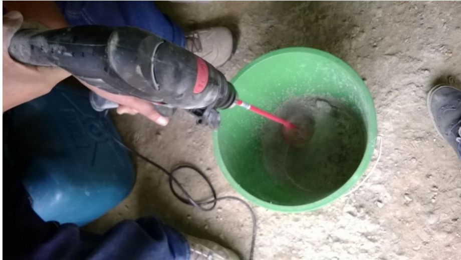
Ilustración 47 Proceso de batido de la mezcla (procedimiento constructivo del tesista).
