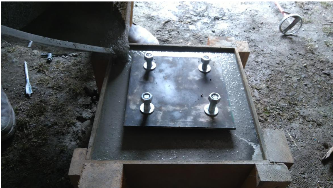
Ilustración 86 Colocación del grout cementicio- Cerro de Pasco
