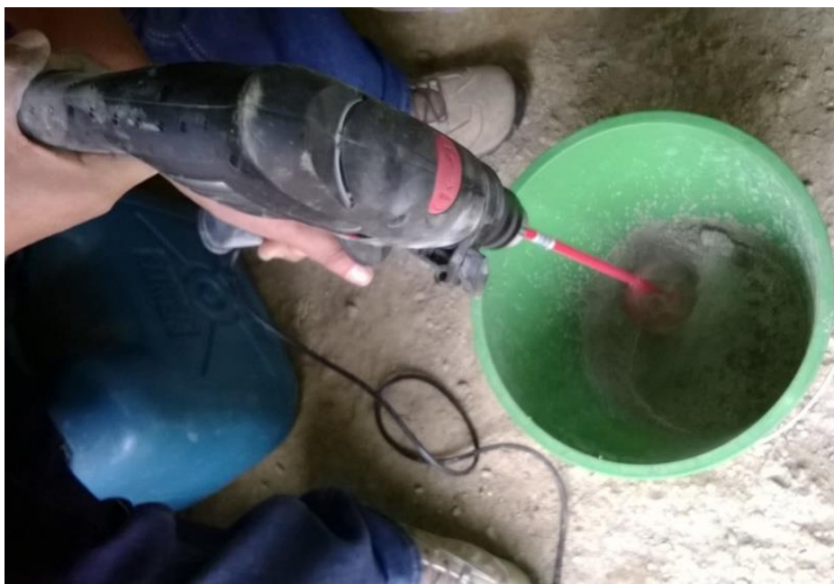
Ilustración 55 Proceso de mezclado (MC2-Calefactor). Procedimiento constructivo del tesista.
