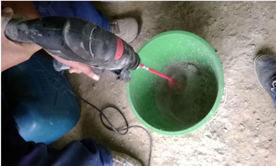
Ilustración 38 Baldes, batea (procedimiento constructivo del tesista).
