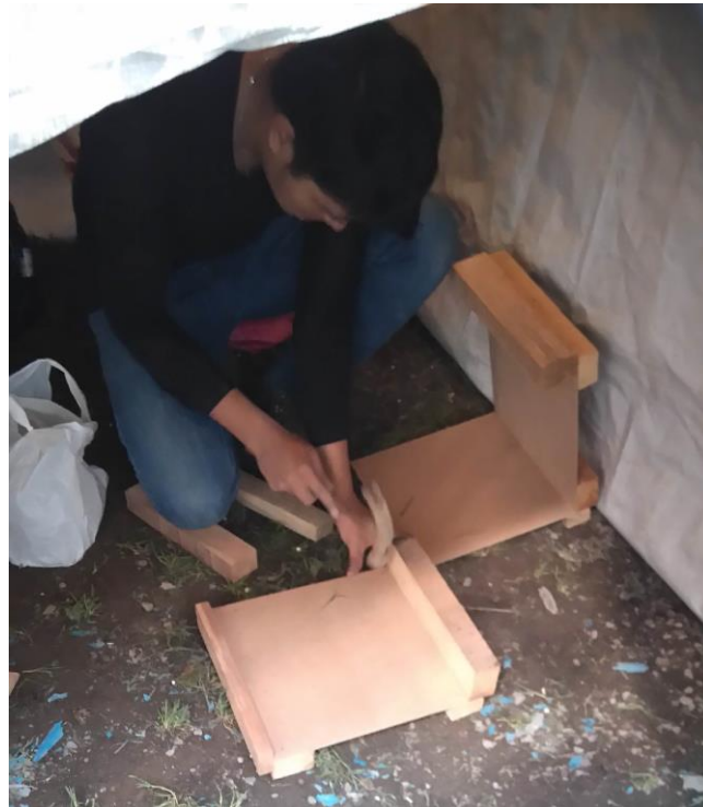
Ilustración 30 Encofrado (procedimiento constructivo del tesista)
