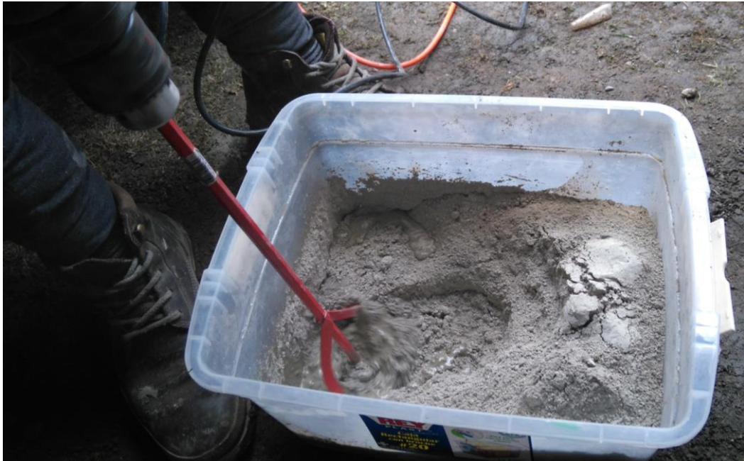
Ilustración 34 Taladro de bajas revoluciones (Procedimiento constructivo del tesista)
