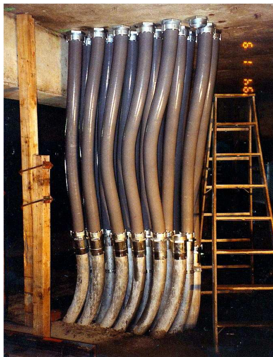
Figura 2.6.a. Servicios básicos con conexiones flexibles.
