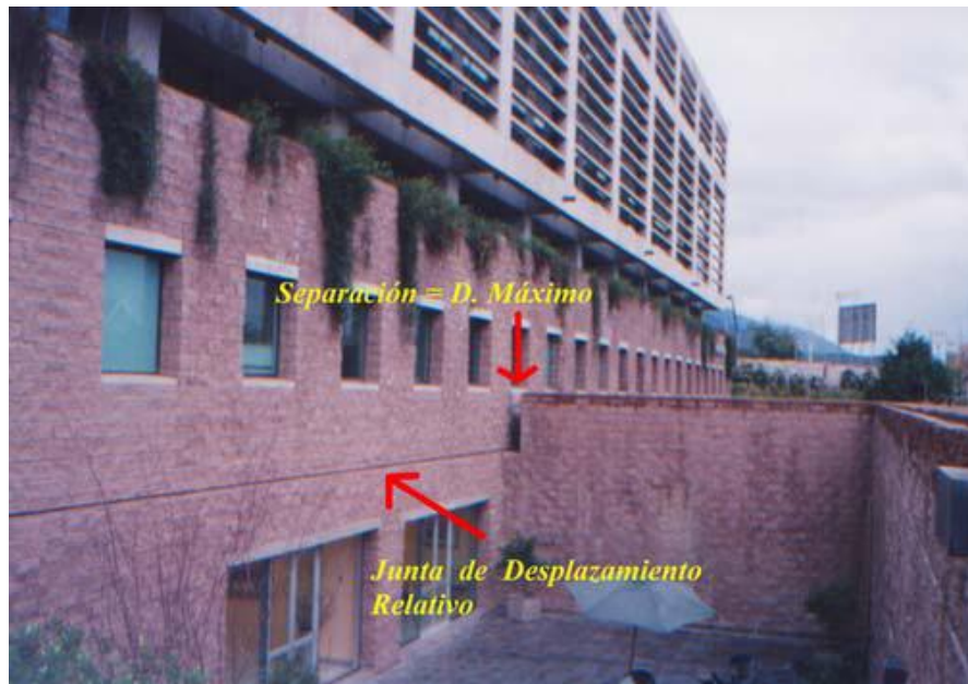
Figura 2.6.d. Exterior del Hospital Militar (Chile) con junta y separaciones para permitir el movimiento entre la parte fija y la estructura aislada.
