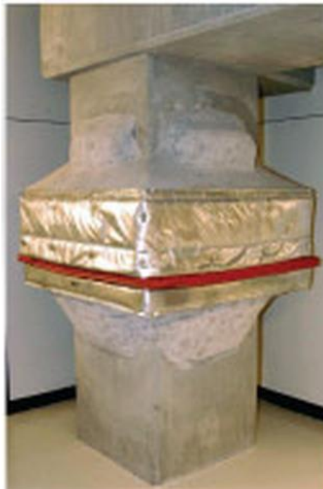
Figura 2.6.e. Aislador elastomérico con funda protectora anti-fuego.
