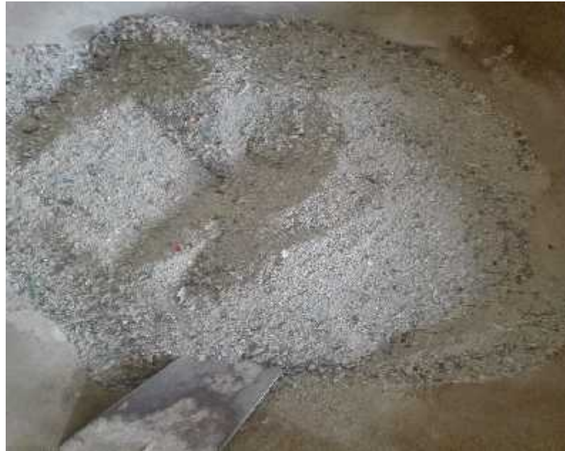
Foto N°15: Se realizó el mezclado con una plancha de batir en una carretilla, agregando la arena, el confitillo y el cemento hasta lograr la homogenización de la mezcla.
