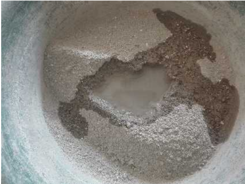
Foto N°27: Se utilizó la dosificación 1:4 ( cemento- arena) para el mortero para el asentado de los ladrillos.
