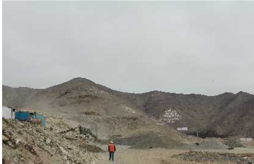
Foto N°01: Ingreso a la cantera "Roca Fuerte" donde adquirimos el material grueso (Confitillo) ubicada cerca al túnel de Coishco.
