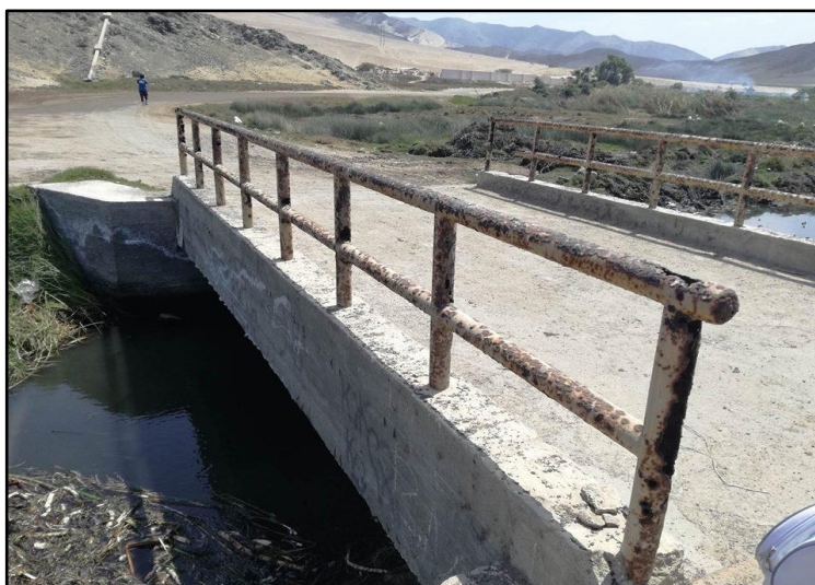
Vista lateral del puente
