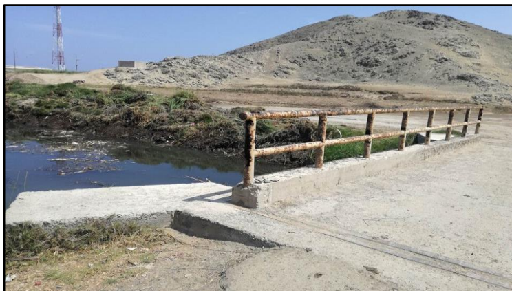
Puente existente como vía de acceso al Cementerio de Samanco
