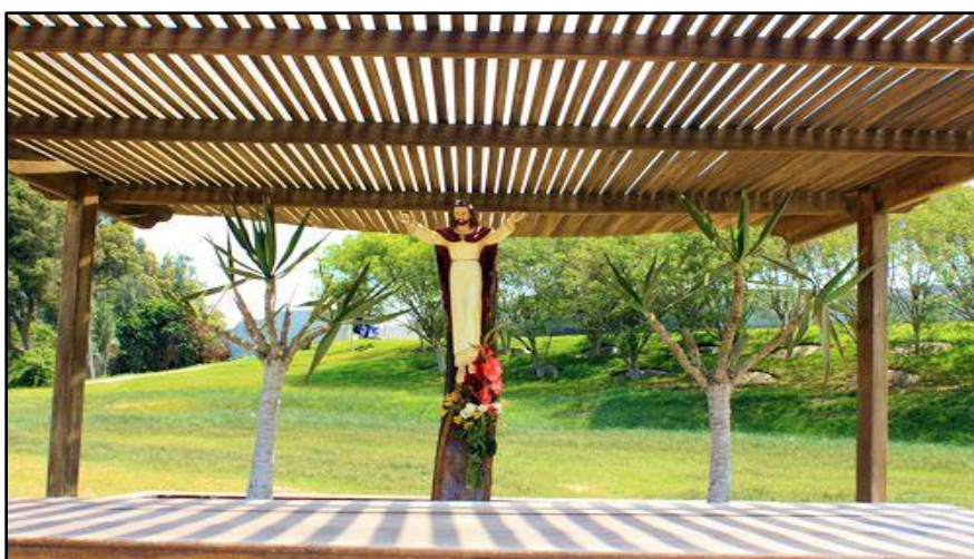
La capilla del cementerio su estructura es de madera
