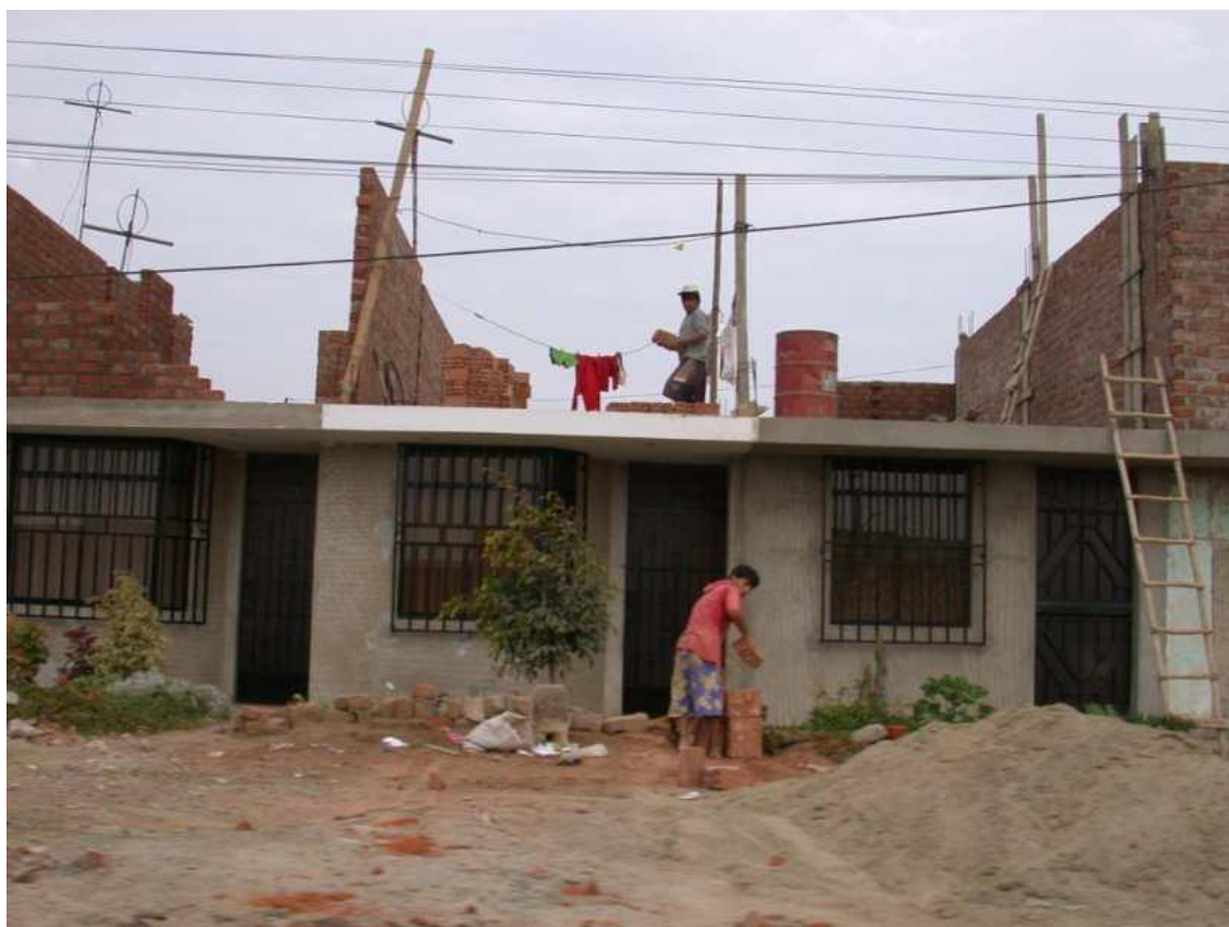
Fig. 2.5 Retomando la construcción de un segundo piso
