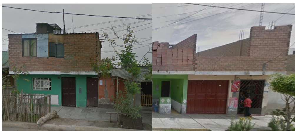
Fig. 4.13 Viviendas sin arriostrar en F.B y F.A.
