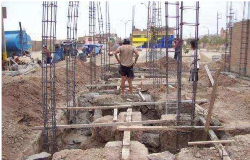
Fig. 2.2 Zapata y columna armada
