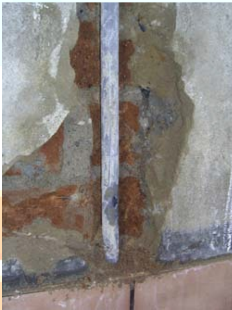
Fuga de agua en tubería rota
