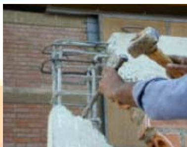
Picado del nudo viga columna
