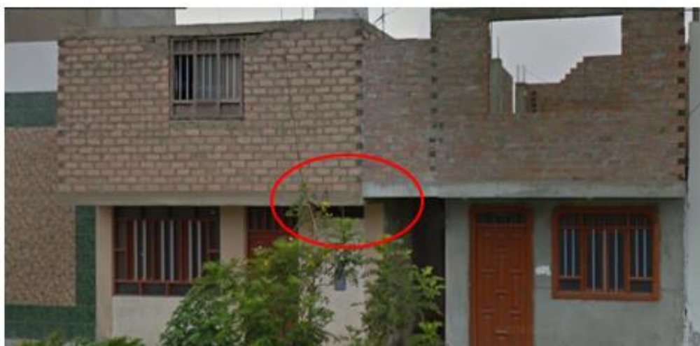
Fig. 4.13 Viviendas sin junta sísmica y losas a desnivel (Jr. Huancavelica J-2, F.B.)
