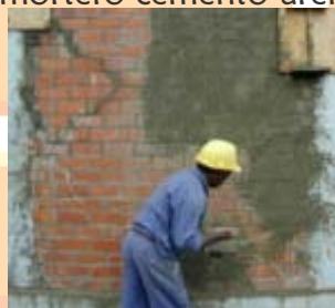
Pañeteo del muro
