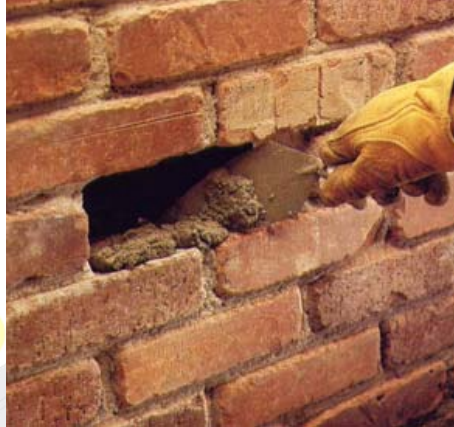
Colocación de nuevo mortero
