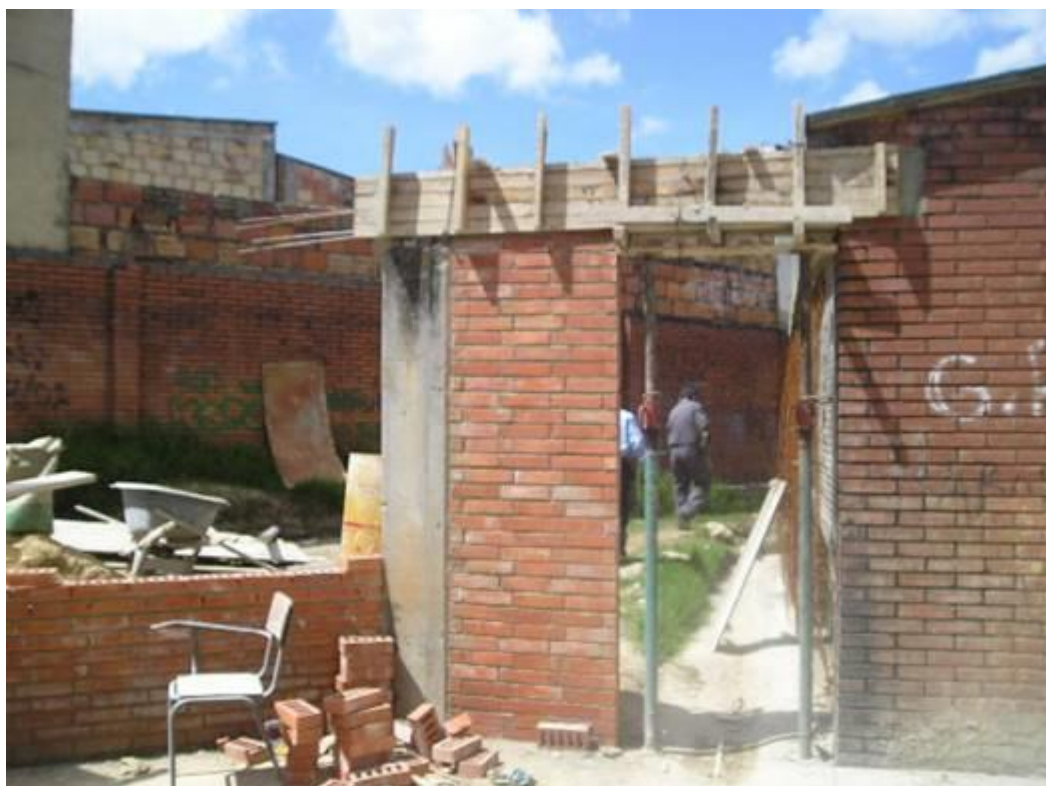
Fig. 2.3 Armado de muros de fachada con columnas
