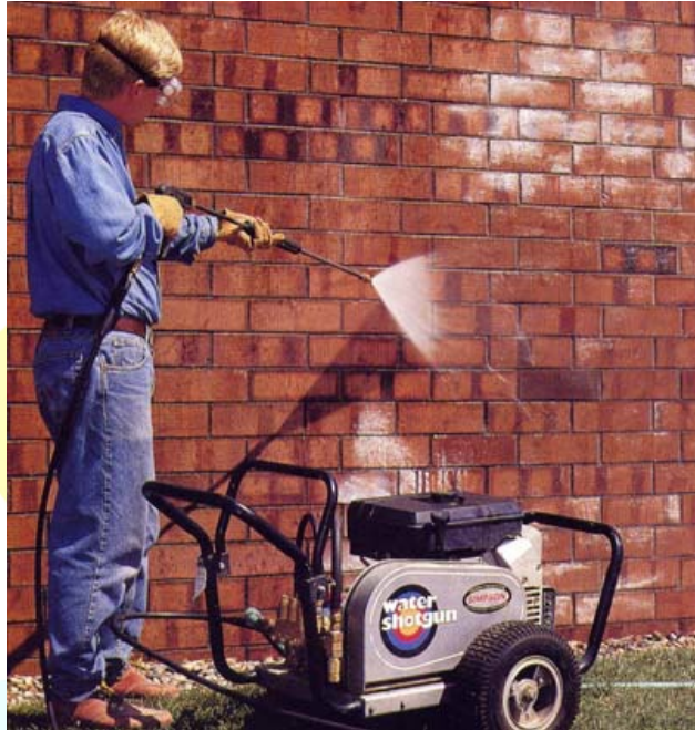
Lavado de grietas
