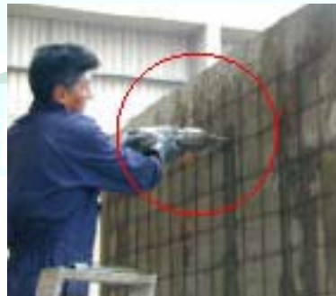
Inyección de perforaciones
