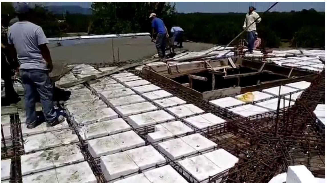
Fig. 2.4 Preparado de la losa aligerada para su vaciado
