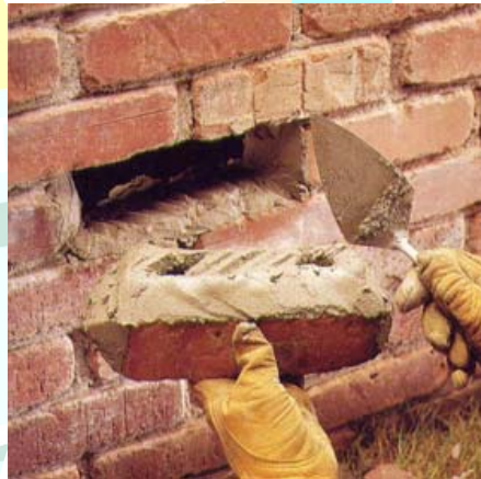
Colocación de nuevo ladrillo
