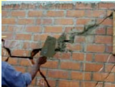
Reparación de grietas gruesas
