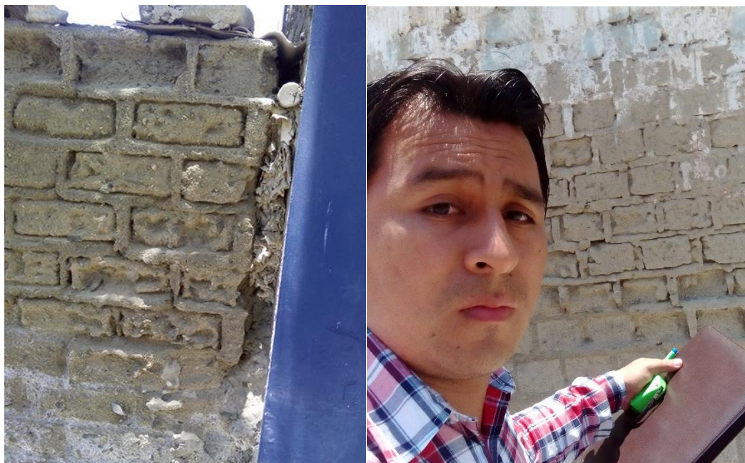
Fig. 4.11 Muros afectados por lluvia ácida en muros (Jr. Lima A-20, F.A.)
