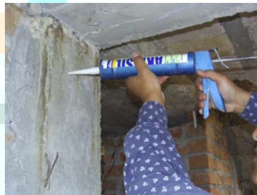
Inyección de grietas con resina epóxica
