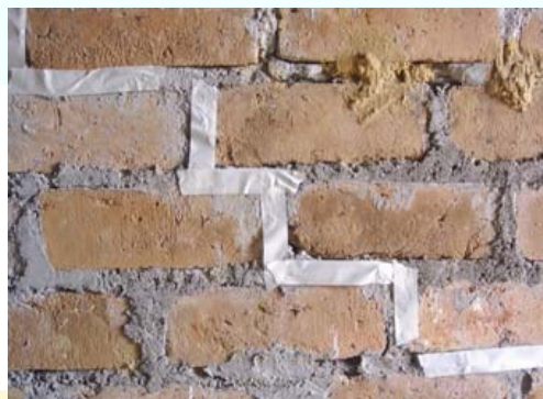
Sellado de las grietas
