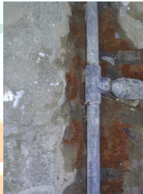
Fuga de agua en unión de tubería
