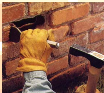
Extracción de ladrillo
