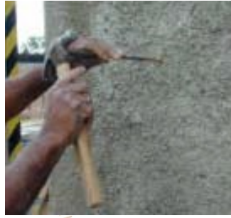
Perforación del muro
