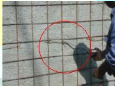
Fijado de la malla electrosoldada
