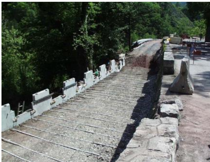
Figura N° 347 : EXTENDIDO DE LAS TIRAS METÁLICAS Fuente: Tierra Armada, Jiménez Salas, J.
