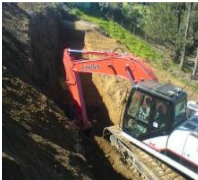
Figura N° 18 : TRABAJOS PRELIMINARES: EXCAVACION DEL TERRENO
