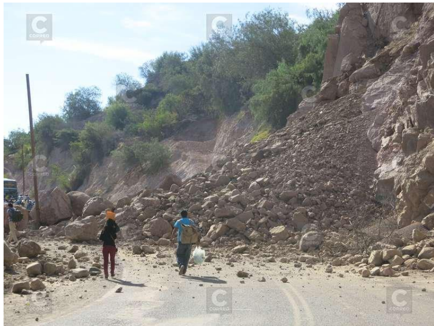
Figura N° 8: DERRUMBE DE TIERRA
