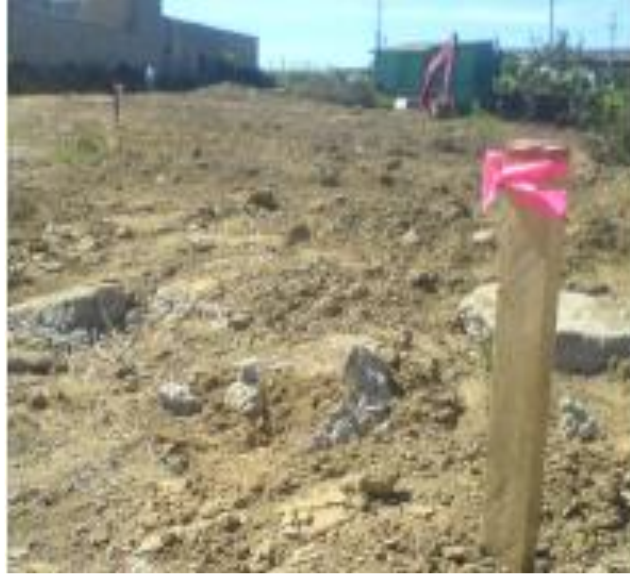
Figura N° 17 : TRABAJOS PRELIMINARES: PREPARACIÓN DEL TERRENO
