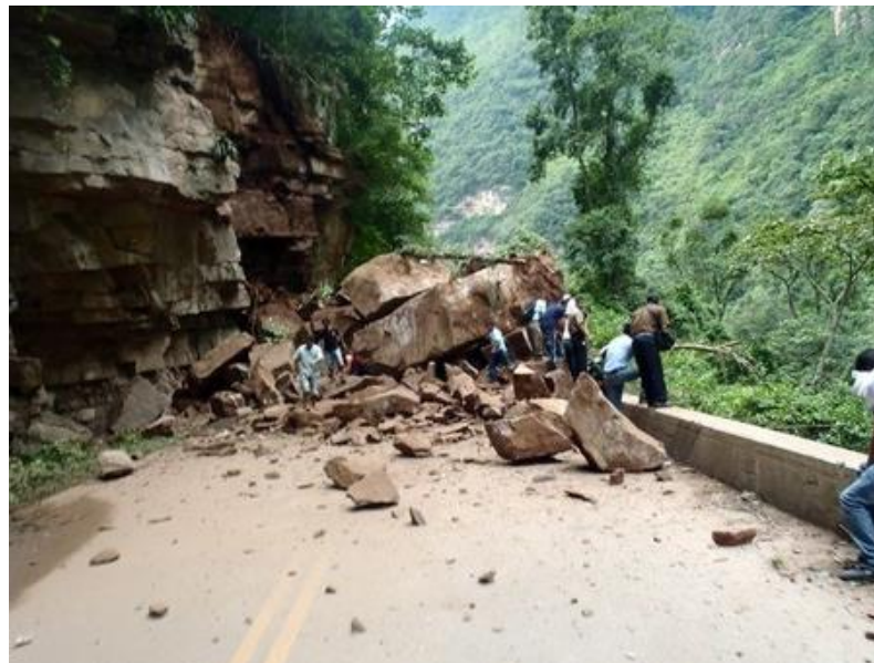
Figura N° 7 : DESPRENDIMIENTO DE ROCA
