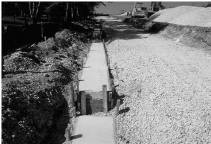
Figura N° 31 : COLOCACIÓN DE LA SOLERA
