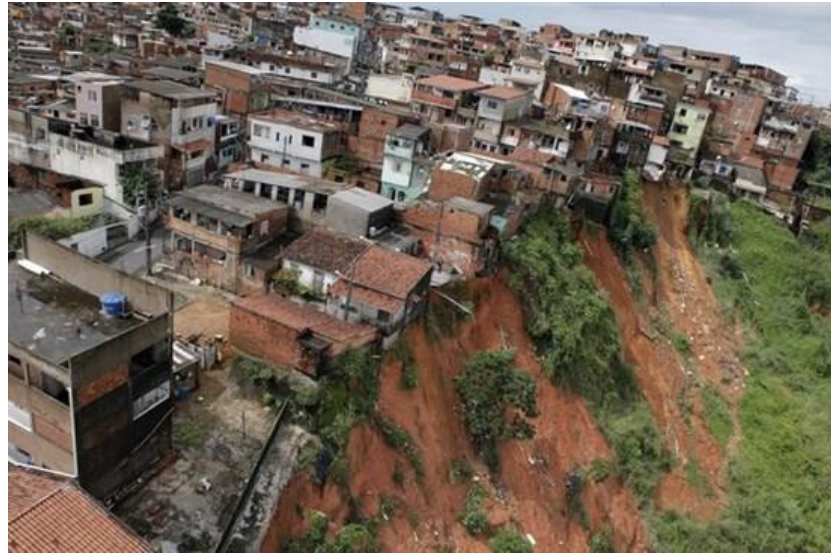
Figura N° 6 : DESLIZAMIENTO DE TIERRA
