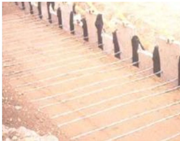
Figura N° 26: REFUERZO CONSIDERADO INEXTENSIBLE
