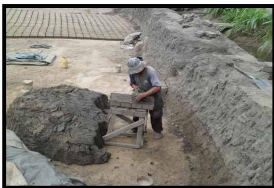
Figura 3.3. Moldeo de unidades de Albañilería Fuente: Los Autores
