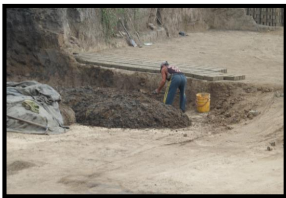
Figura 3.2. Preparación de la mezcla para la elaboración de las unidades de albañilería
