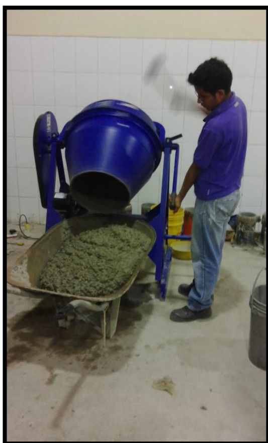
Foto 25. Vaciado de concreto
