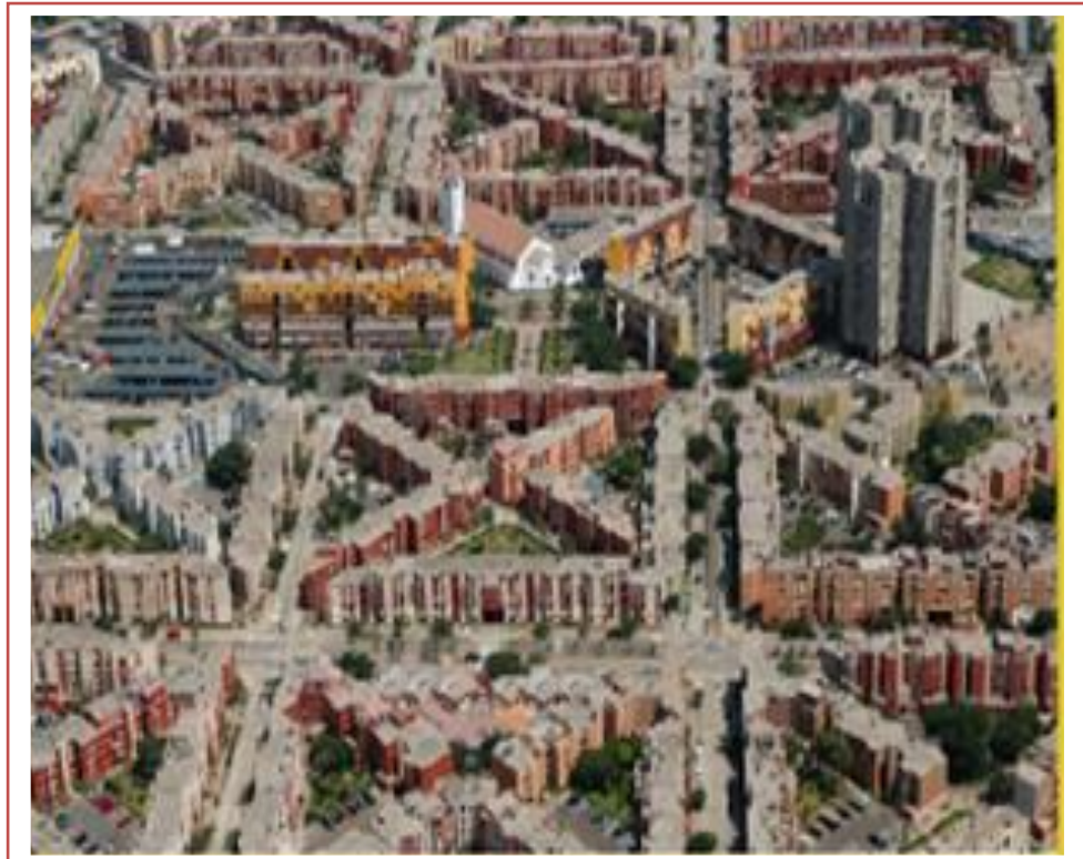
Imagen 2.4: Vista aérea del Conjunto Habitacional de Limatambo.
