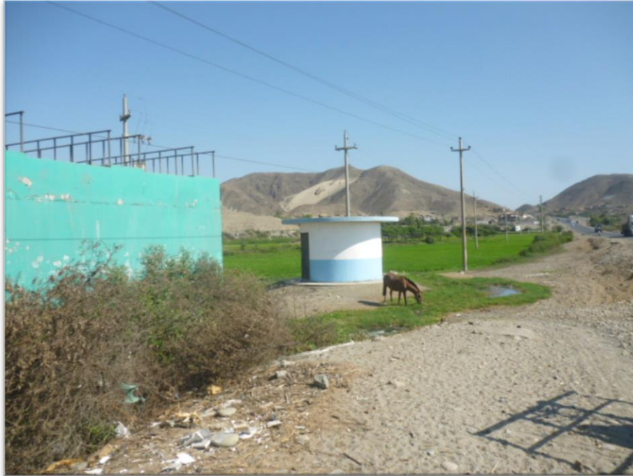
Pozo de oxidación de aguas servidas.
