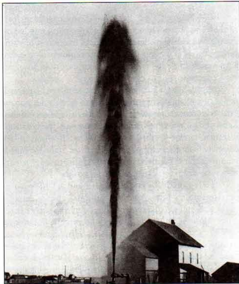
Figura N°10 Pozo artesiano que fluye , en Dakota del sur a principios del siglo XX. En la actualidad se explota el mismo acuífero confinado a través de millares de pozos adicionales; por tanto, la presión ha descendido hasta el punto de que muchos pozos han dejado de fluir por completo y deben bombearse).
