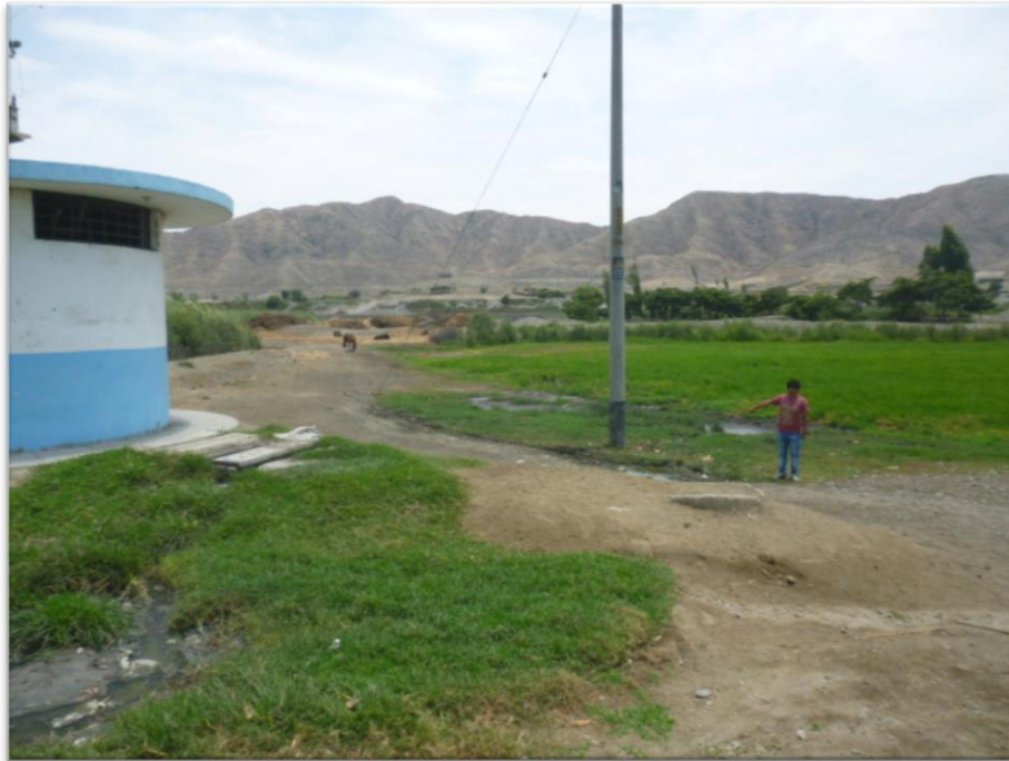
Se aprecia el derrame de agua servidas y como contamina el humedal
