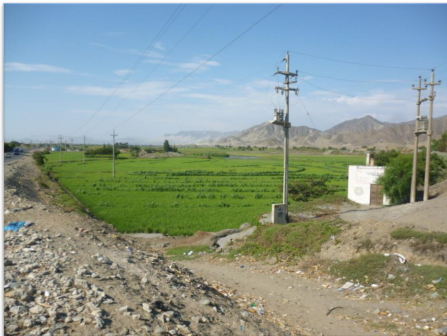
Distancia entre la caseta del pozo artesiano y el pozo de oxidación
