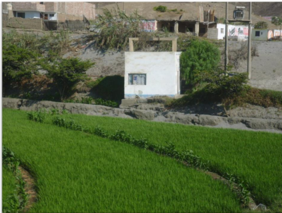
Caseta donde está ubicado el pozo artesiano donde se capta agua para la población
