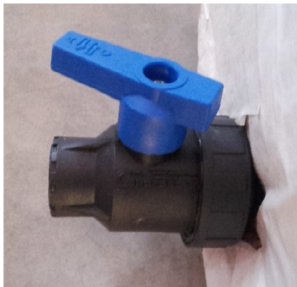
Figura N° 40. Válvula bola con conector para el desfogue de agua. (Fuente: Propia, 2016).
