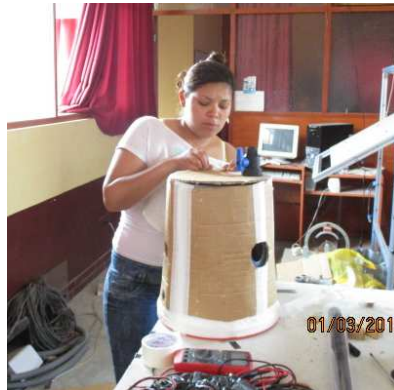
Figura N° 57. Proceso de forrado del tanque. (Fuente: Propia, 2016)
