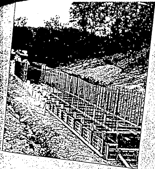
· Cajones y túneles
