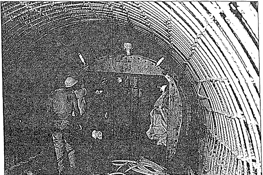
Sistema de Encofrado EFCO para galerías.
