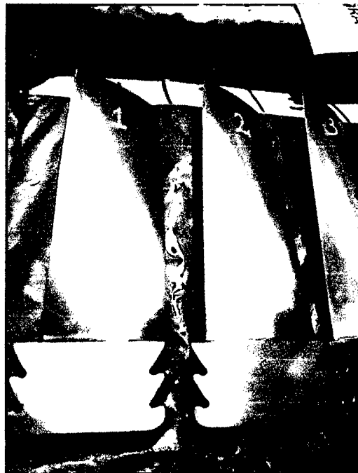
Fotografía N° 04. Numeración de alabes fijos.
