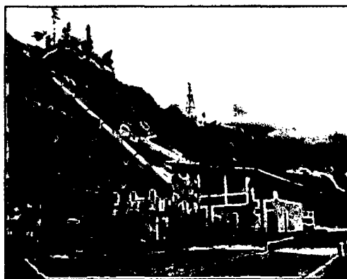
Figura 2.6: Central Hidroeléctrica Santa Cruz II de 6 MW) / 2 turbinas Francis Fuente: OSINERGMIN
