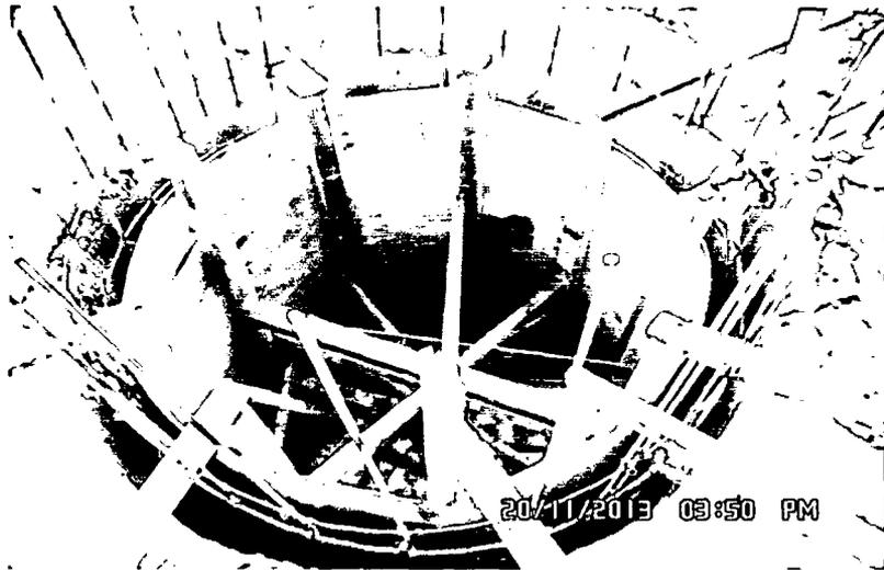
**Fotografía N°09.- Aseguramiento final de muertos de madera, antes del vaciado de mezcla**
