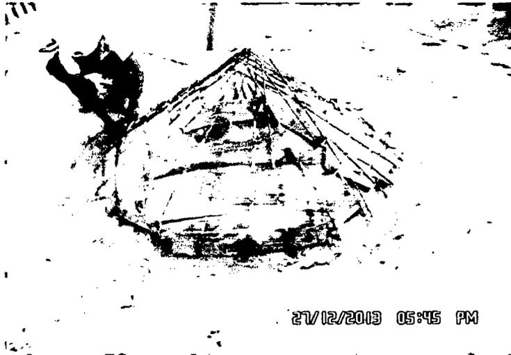
**Fotografía N°18.- Encofrado para la cúpula**
