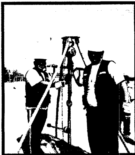
Ensayo de DPL 03, Se procede a sacar las varillas de DPL con ayuda de un tecele.
