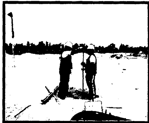
Ensayo de DPL 02, Realizando la caída libre del martillo en la primera varilla.
